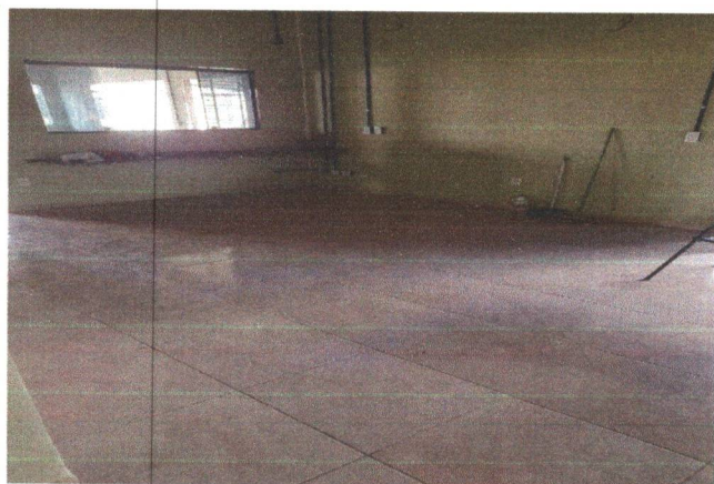
BANCADA DE GRANITO / PINTURA
