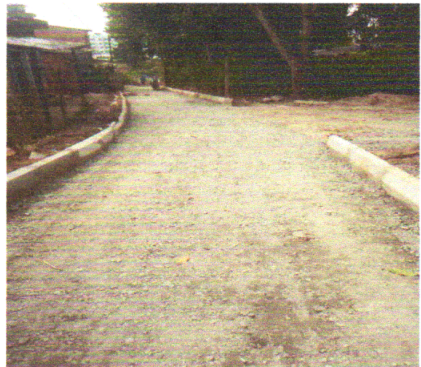
ASSENTAMENTO DE GUIA (MEIO-FIO) EM TRECHO RETO, CONFECCIONADA EM CONCRETO PRÉ-FABRICADO, DIMENSÕES 100X15X13X30 CM (COMPRIMENTO X BASE INFERIOR X BASE SUPERIOR X ALTURA), PARA VIAS URBANAS (USO VIÁRIO). AF_06/2016
