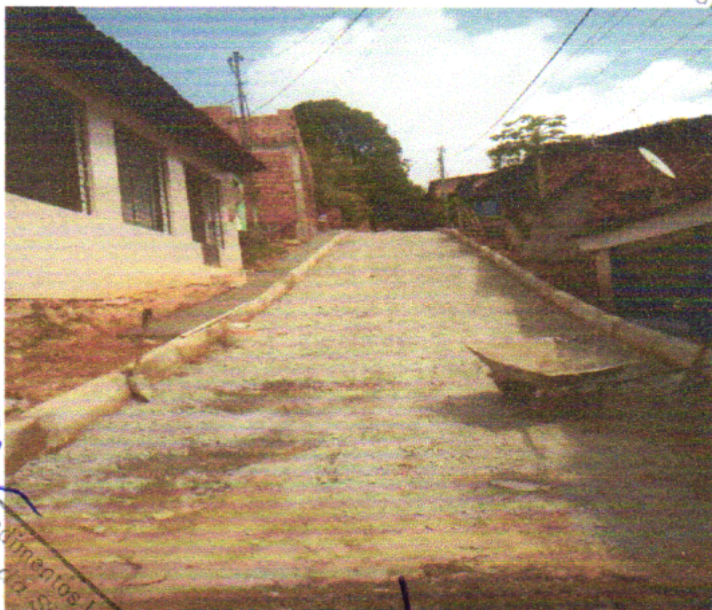
EXECUÇÃO E COMPACTAÇÃO DE BASE E OU SUB BASE PARA PAVIMENTAÇÃO DE BRITA GRADUADA SIMPLES - EXCLUSIVE CARGA E TRANSPORTE. AF_11/2019
