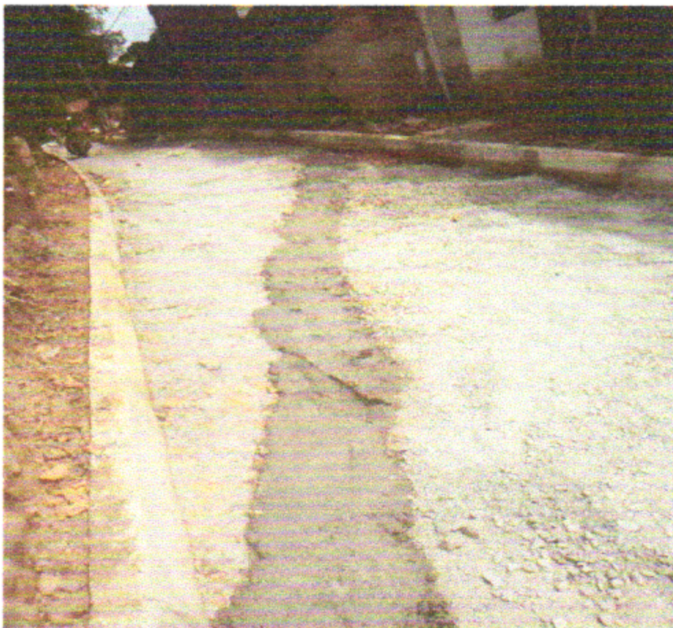
ASSENTAMENTO DE GUIA (MEIO-FIO) EM TRECHO RETO, CONFECCIONADA EM CONCRETO PRÉ-FABRICADO, DIMENSÕES 100X15X13X30 CM (COMPRIMENTO X BASE INFERIOR X BASE SUPERIOR X ALTURA), PARA VIAS URBANAS (USO VIÁRIO). AF_06/2016
