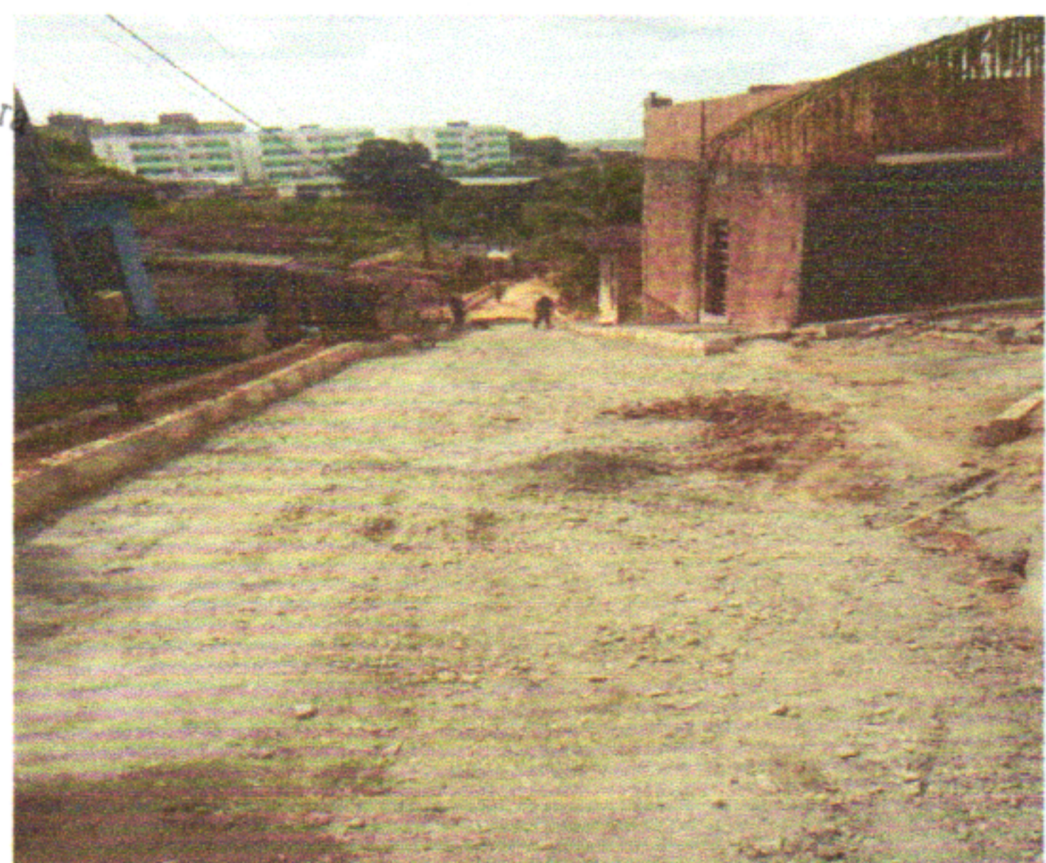
EXECUÇÃO E COMPACTAÇÃO DE BASE E OU SUB BASE PARA PAVIMENTAÇÃO DE BRITA GRADUADA SIMPLES - EXCLUSIVE CARGA E TRANSPORTE. AF_11/2019
