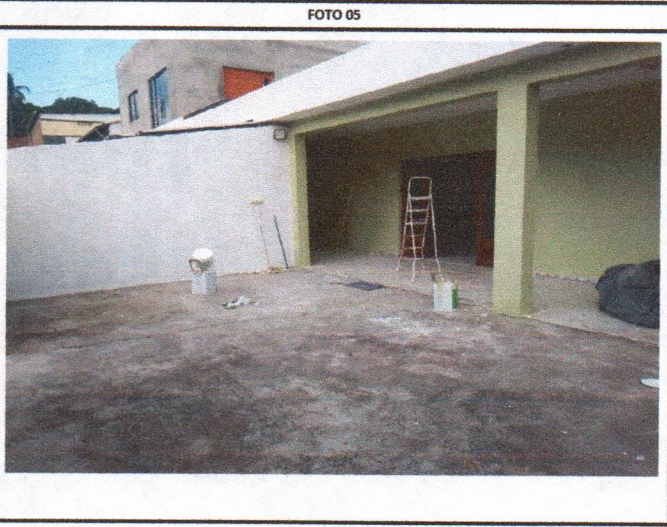
APLICAÇÃO MANUAL DE PINTURA COM TINTA LÁTEX PVA EM PAREDES, DUAS DEMÃOS. AF_06/2014
