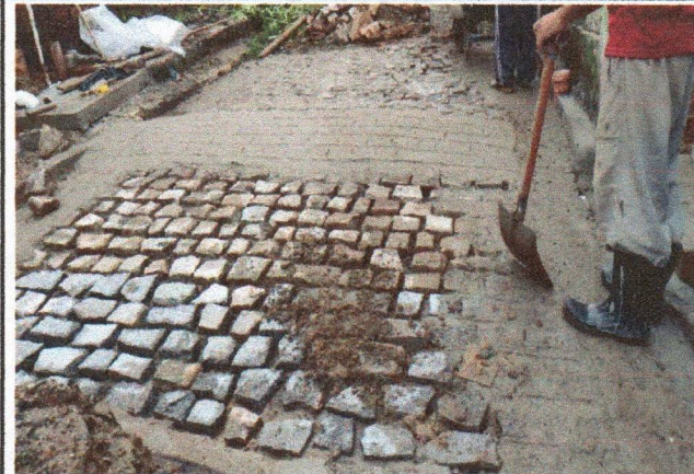
REASSENTAMENTO DE PARALELEPIEDOS, REJUNTAMENTO COM ARGAMASSA, COM REAPROVEITAMENTO DOS PARALELEPIEDOS. AF_12/2020
