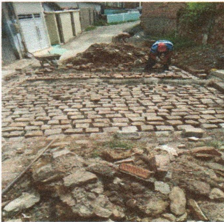
DEMOLIÇÃO DE PAVIMENTAÇÃO EM PARALELEPIEDOS SOBRE AREIA
