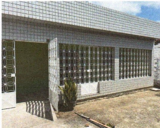
PINTURA DAS ESQUADRIAS METÁLICAS
