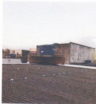
LIMPEZA DA CAIXA D'ÁGUA
