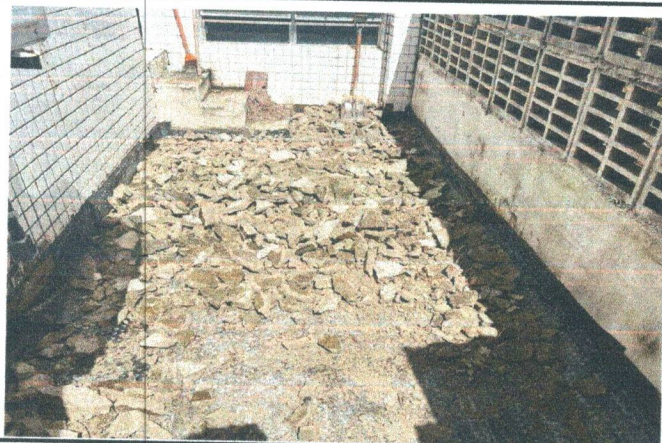
DEMOLIÇÃO E REMOÇÃO DA MANTA LAJE 1º ANDAR SECRETARIA DE SAÚDE
