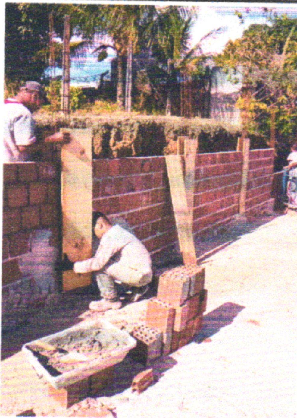
FABRICAÇÃO DE FORMA PARA PILAR
