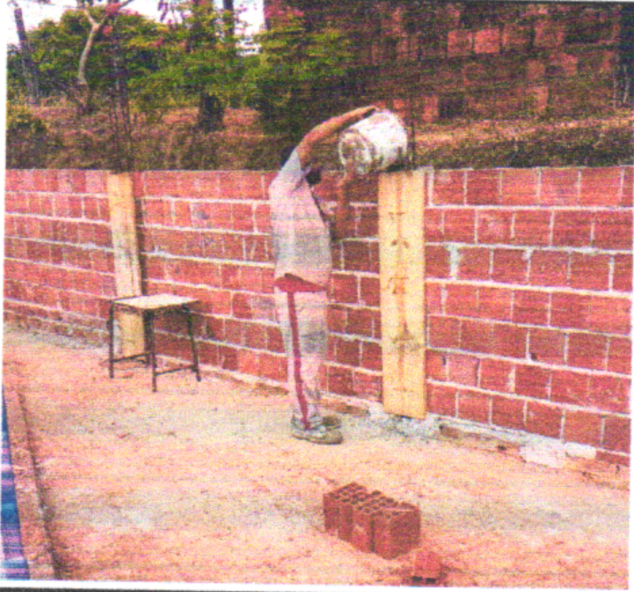
LANÇAMENTO DE CONCRETO
