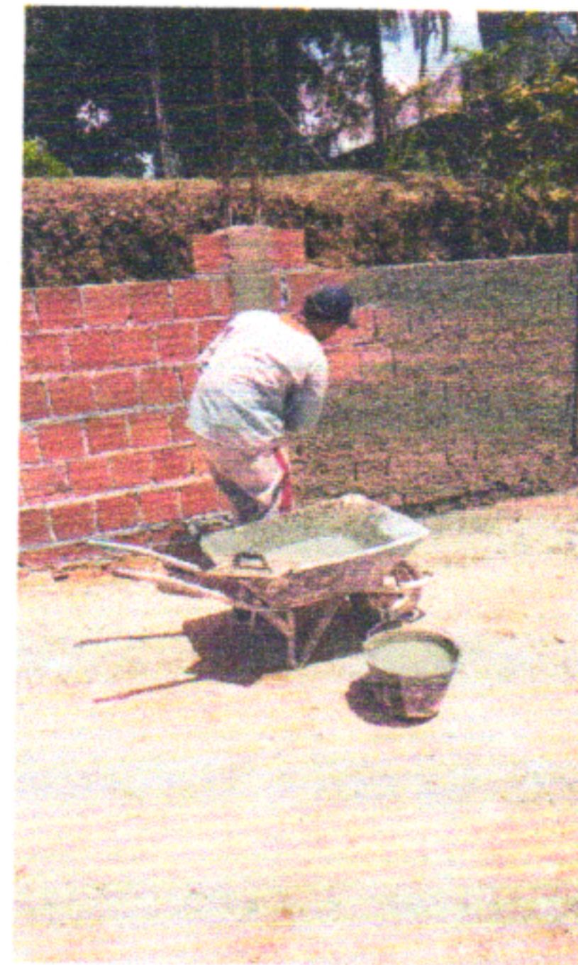
ALVENARIA E CHAPISCO
