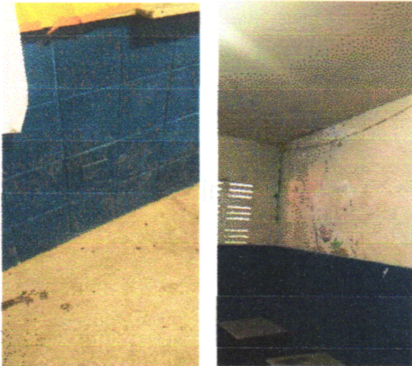
REMOÇÃO DE REVESTIMENTO CERÂMICO E ARGAMASSA DA PAREDE
