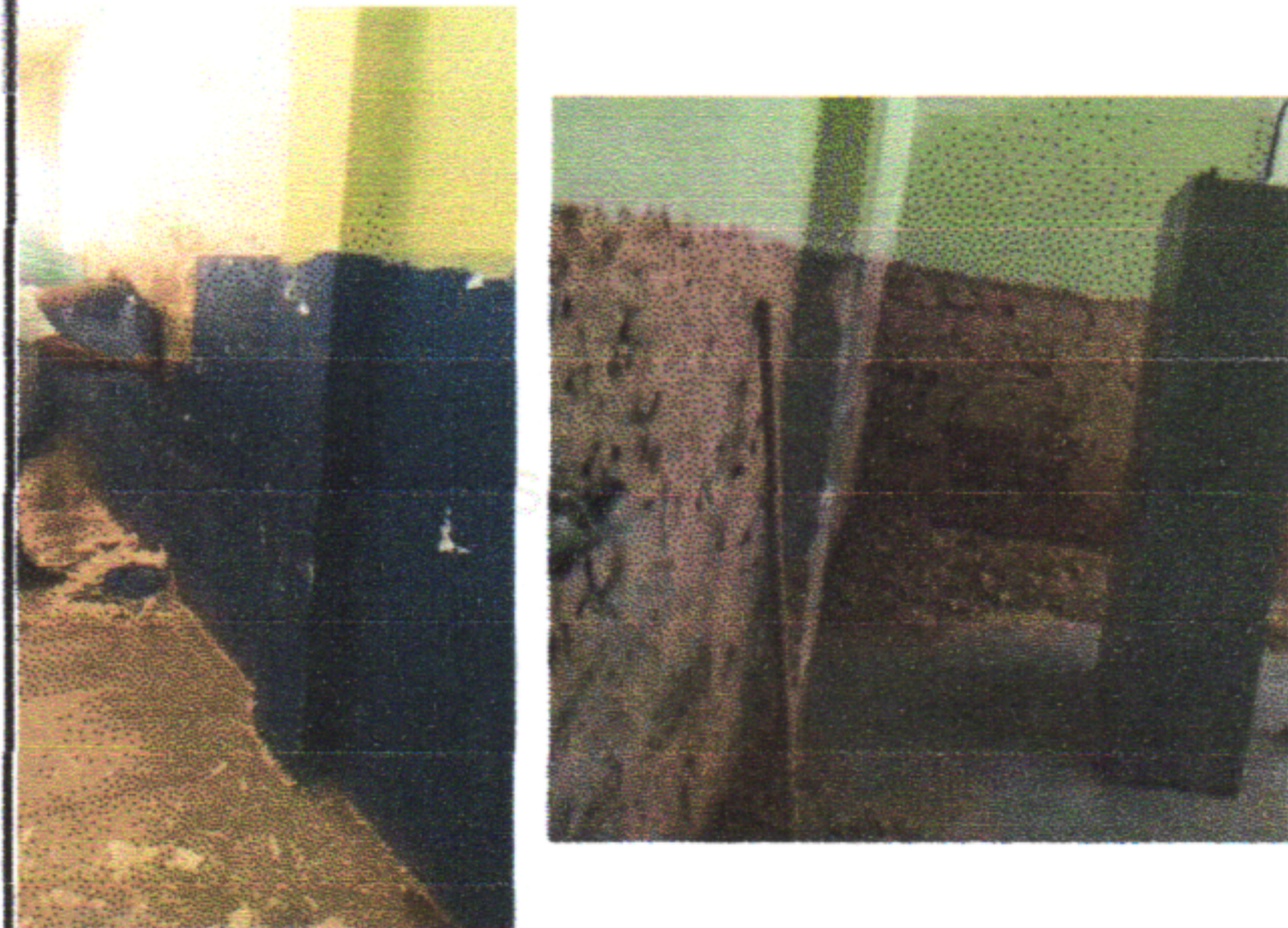
EXECUÇÃO DA REMOÇÃO DO REVESTIMENTO E ARGAMASSA
