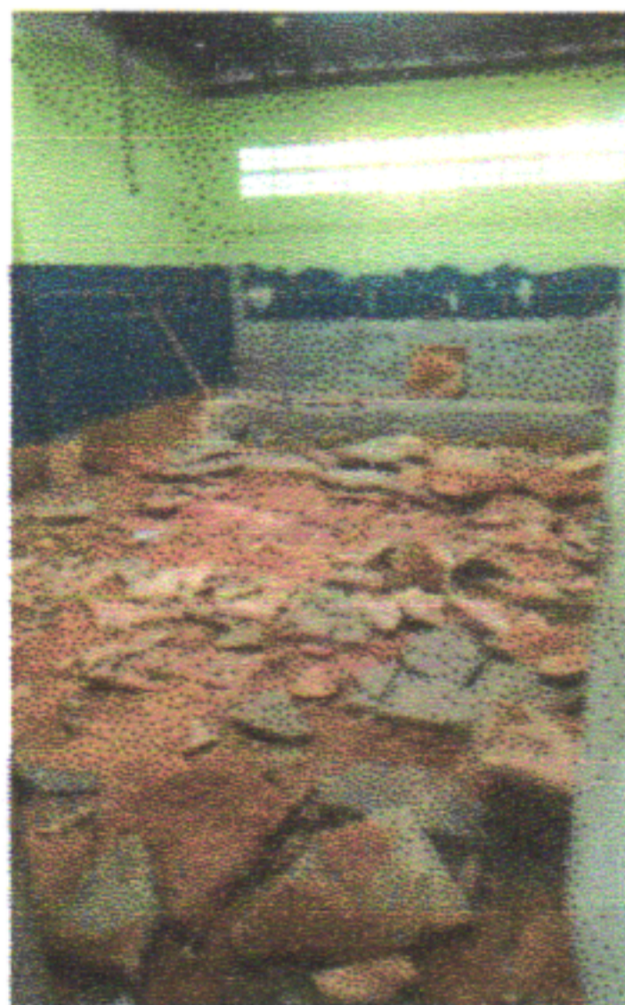
DEMOLIÇÃO DE PISO E LAJOTA
