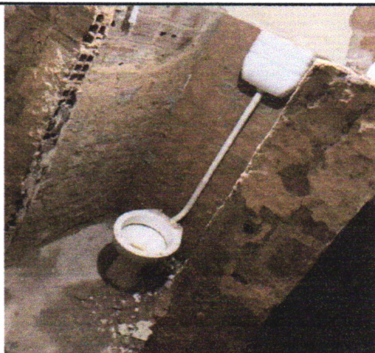
DEMOLIÇÃO DE ARGAMASSAS
