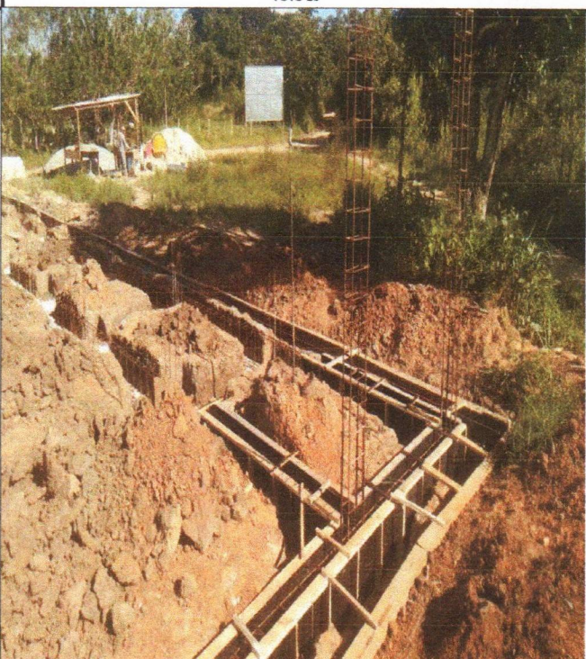
ARMAÇÃO FÔRMA E CONCRETAGEM
