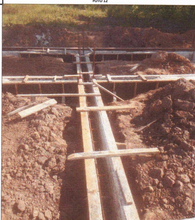
ARMAÇÃO FÔRMA E CONCRETAGEM
