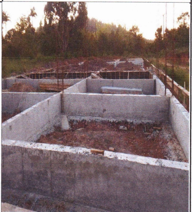
ARMAÇÃO FÔRMA E CONCRETAGEM
