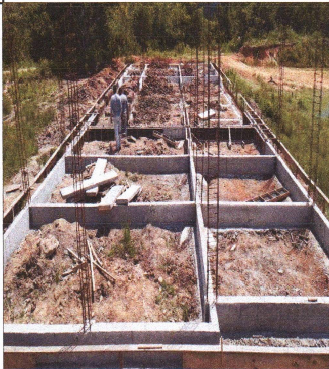
ARMAÇÃO FÔRMA E CONCRETAGEM
