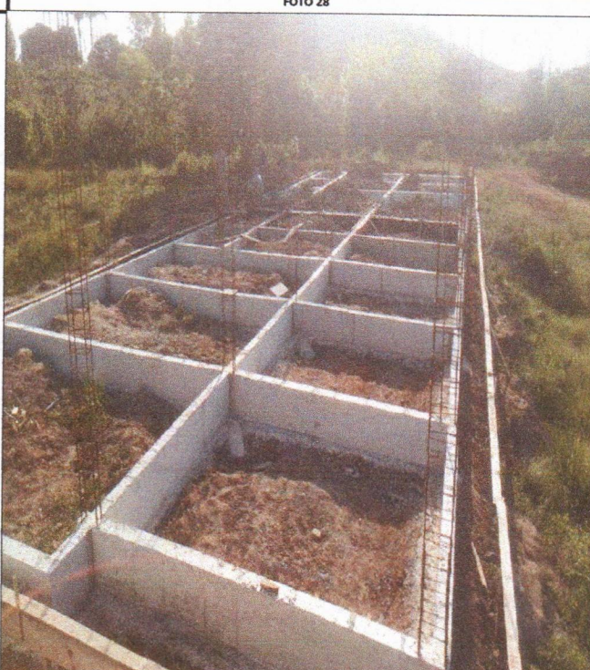
ARMAÇÃO FÔRMA E CONCRETAGEM
