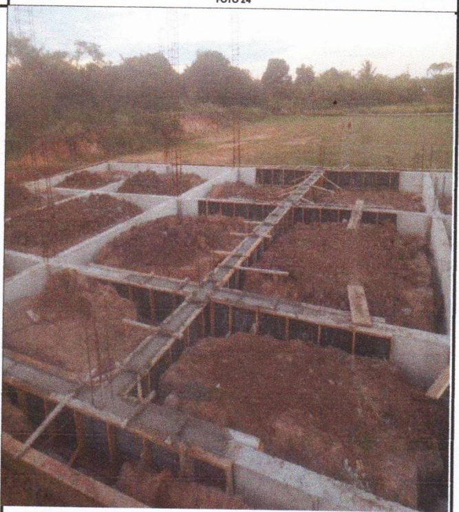
ARMAÇÃO FÔRMA E CONCRETAGEM
