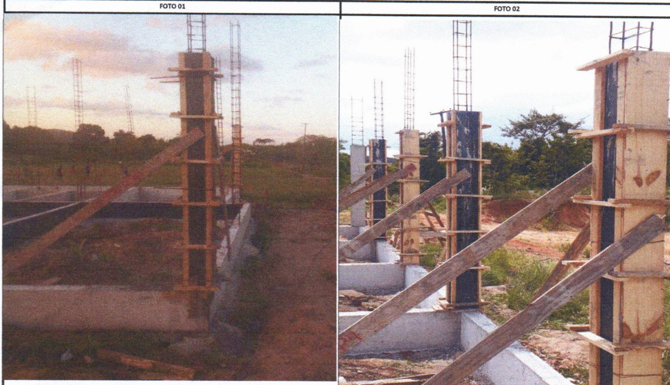
CONCRETO SUPERESTRUTURA CONCRETO SUPERESTRUTURA
