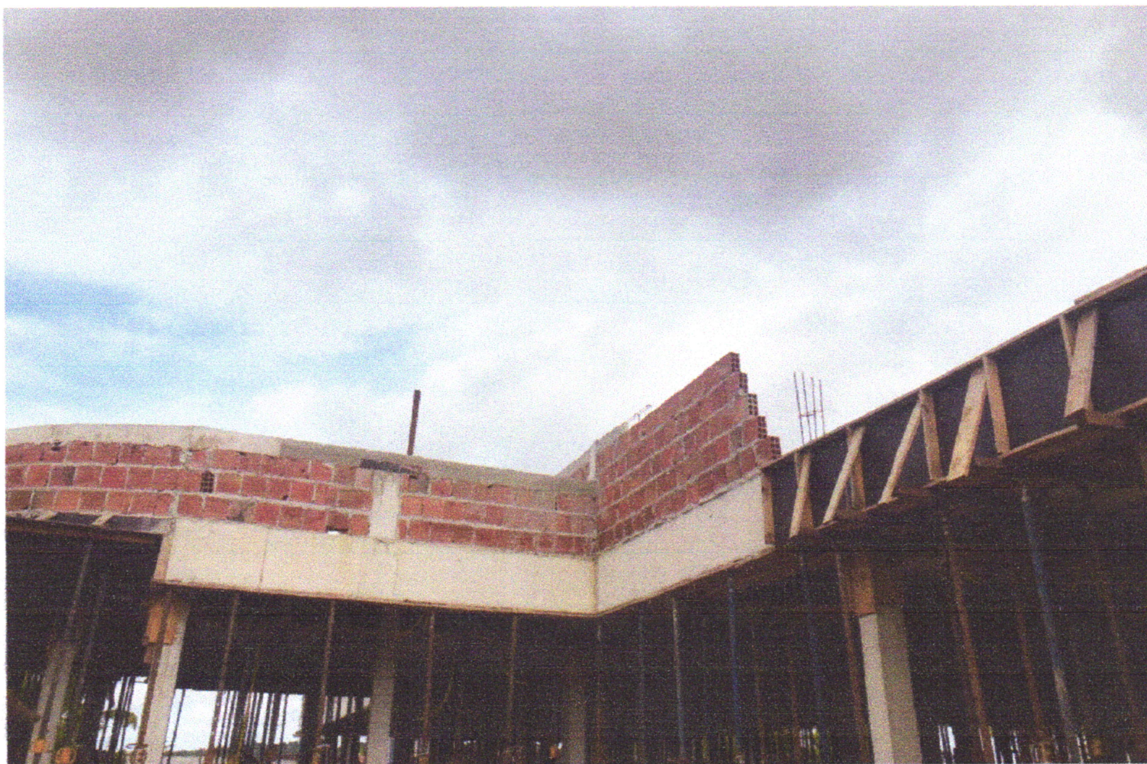
FOTO 08 (EXECUÇÃO DE PILARES E ALVENARIA DA PLATIBANDA, FORMA E ESCORAMENTO DA SEGUUNDA ETAPA DA CONCRETAGEM)
