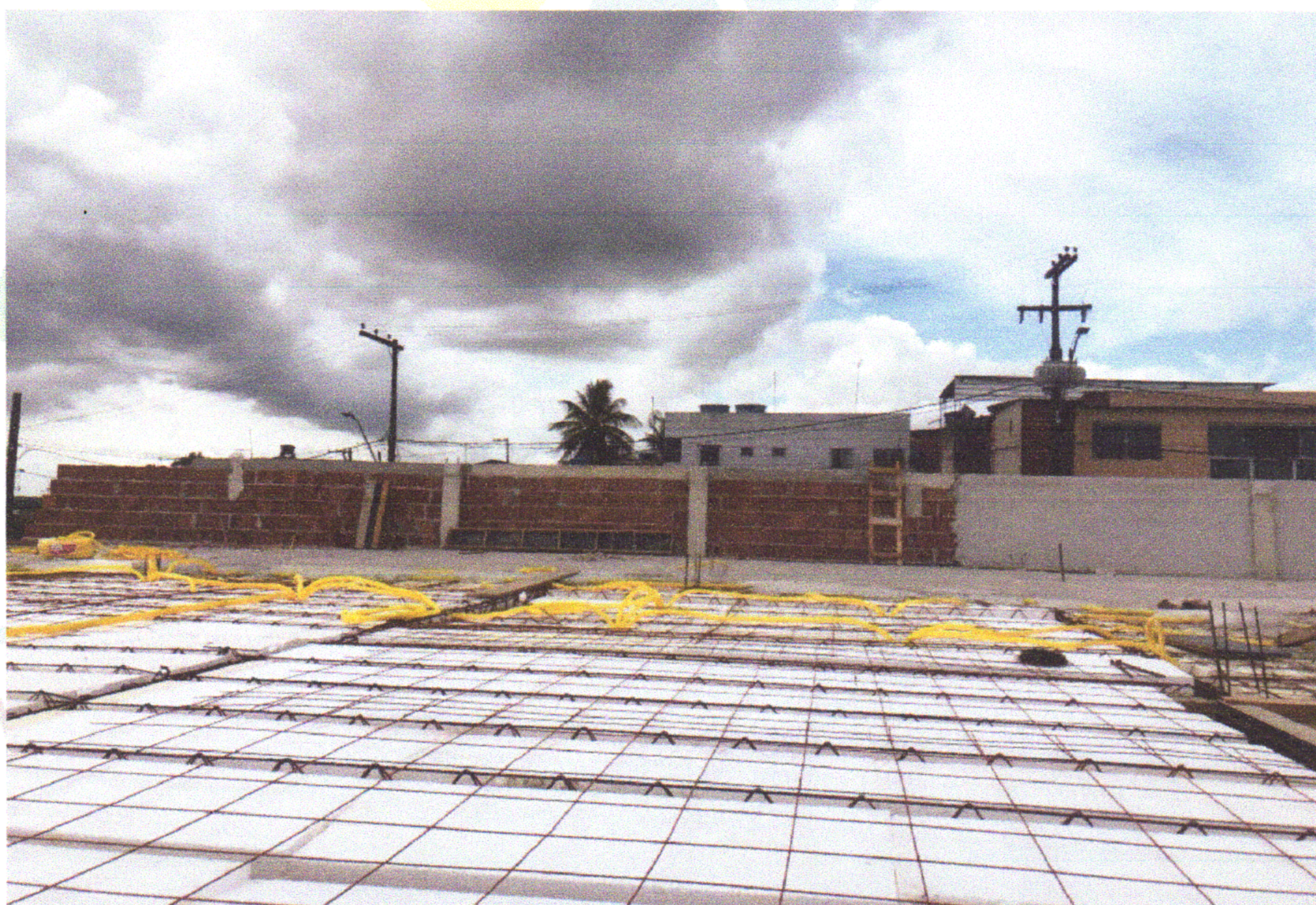
FOTO 03 (EXECUÇÃO DE PILARES E ALVENARIA DA PLATIBANDA)
