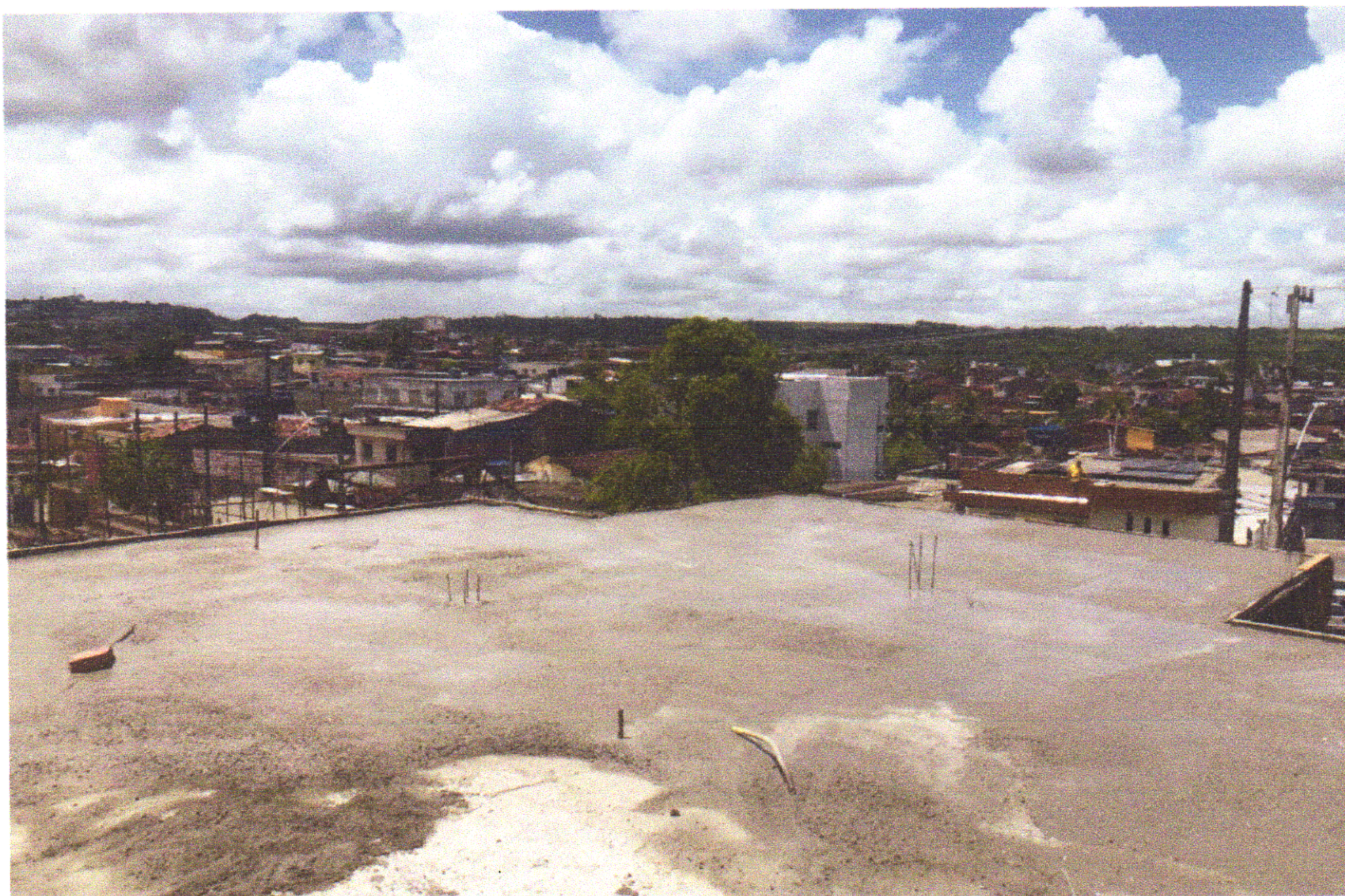
FOTO 10 (CONCRETAGEM DE VIGAS E LAJE)
