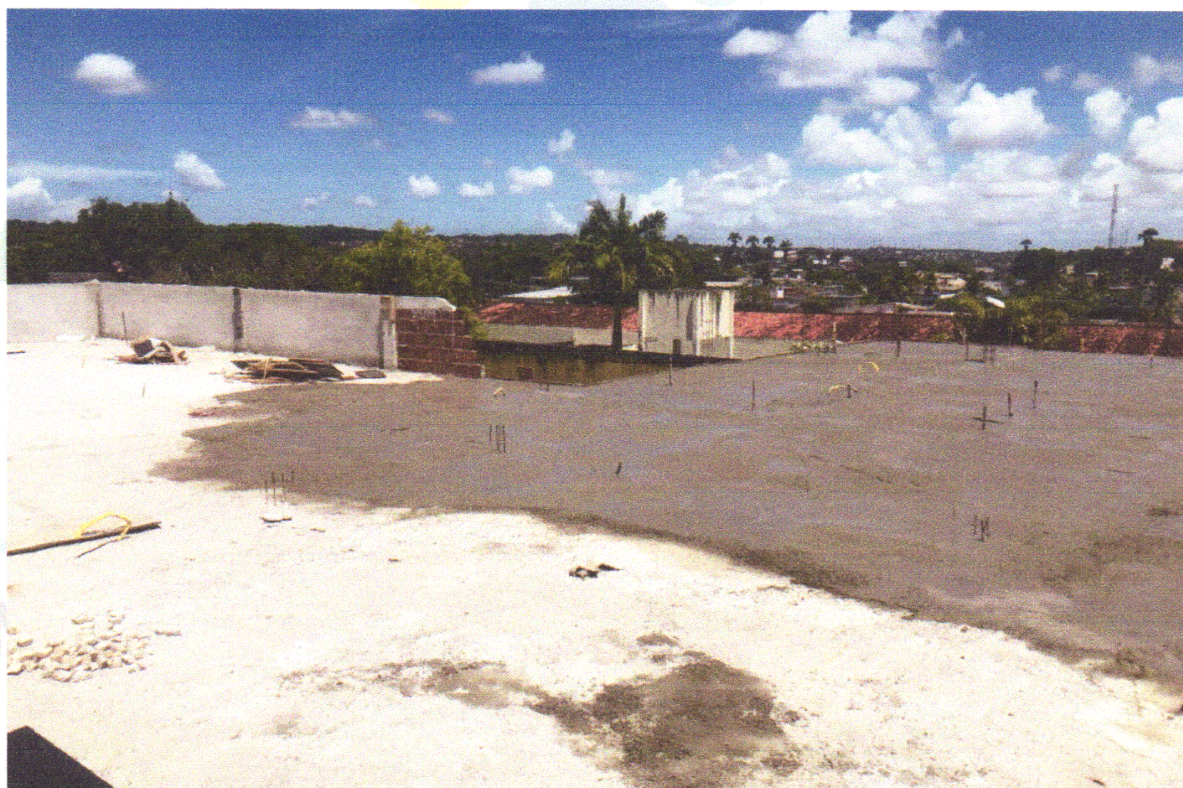
FOTO 13 (CONCRETAGEM DE VIGAS E LAJE)
