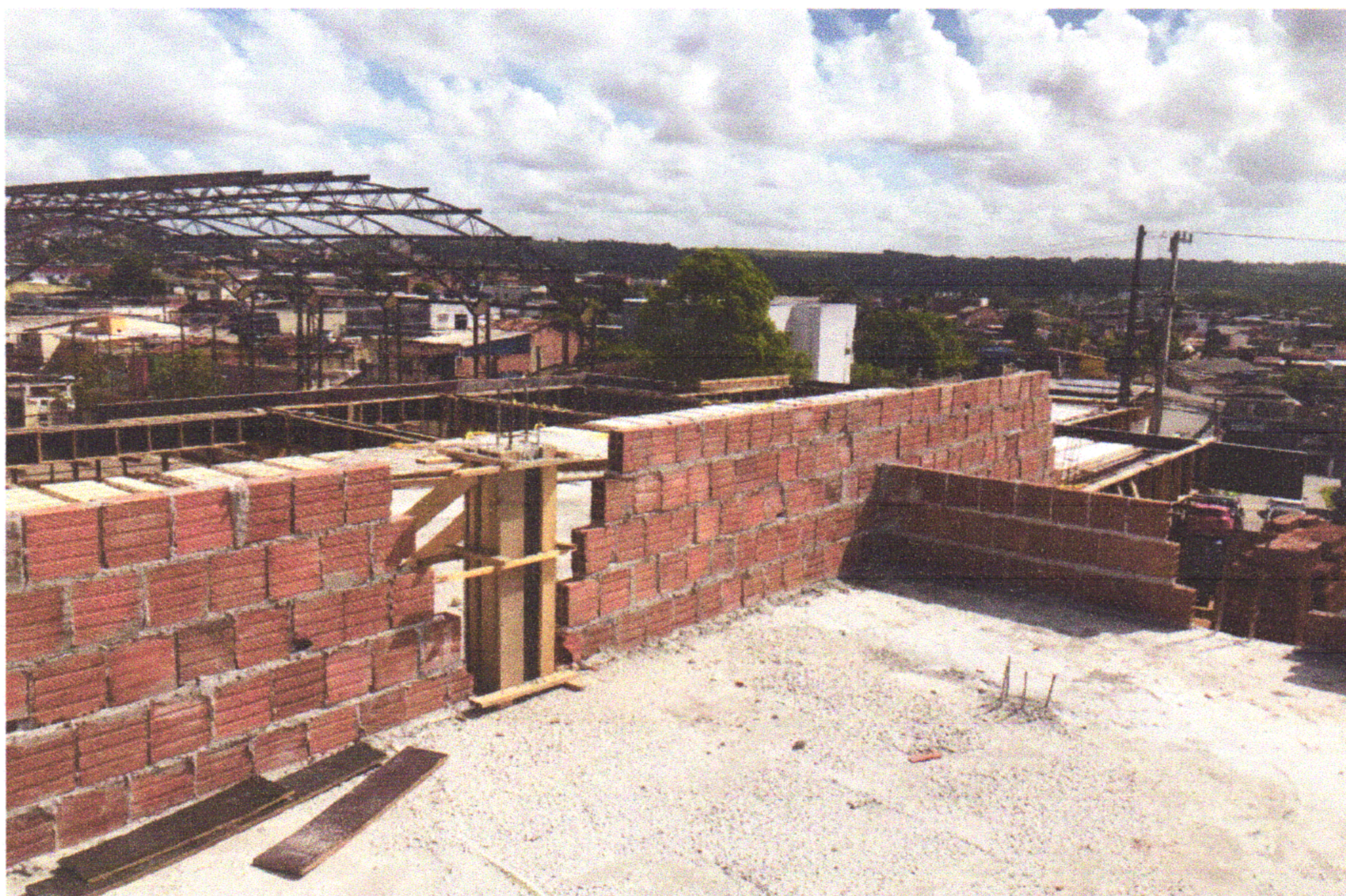
FOTO 02 (EXECUÇÃO DE PILARES E ALVENARIA DA PLATIBANDA)
