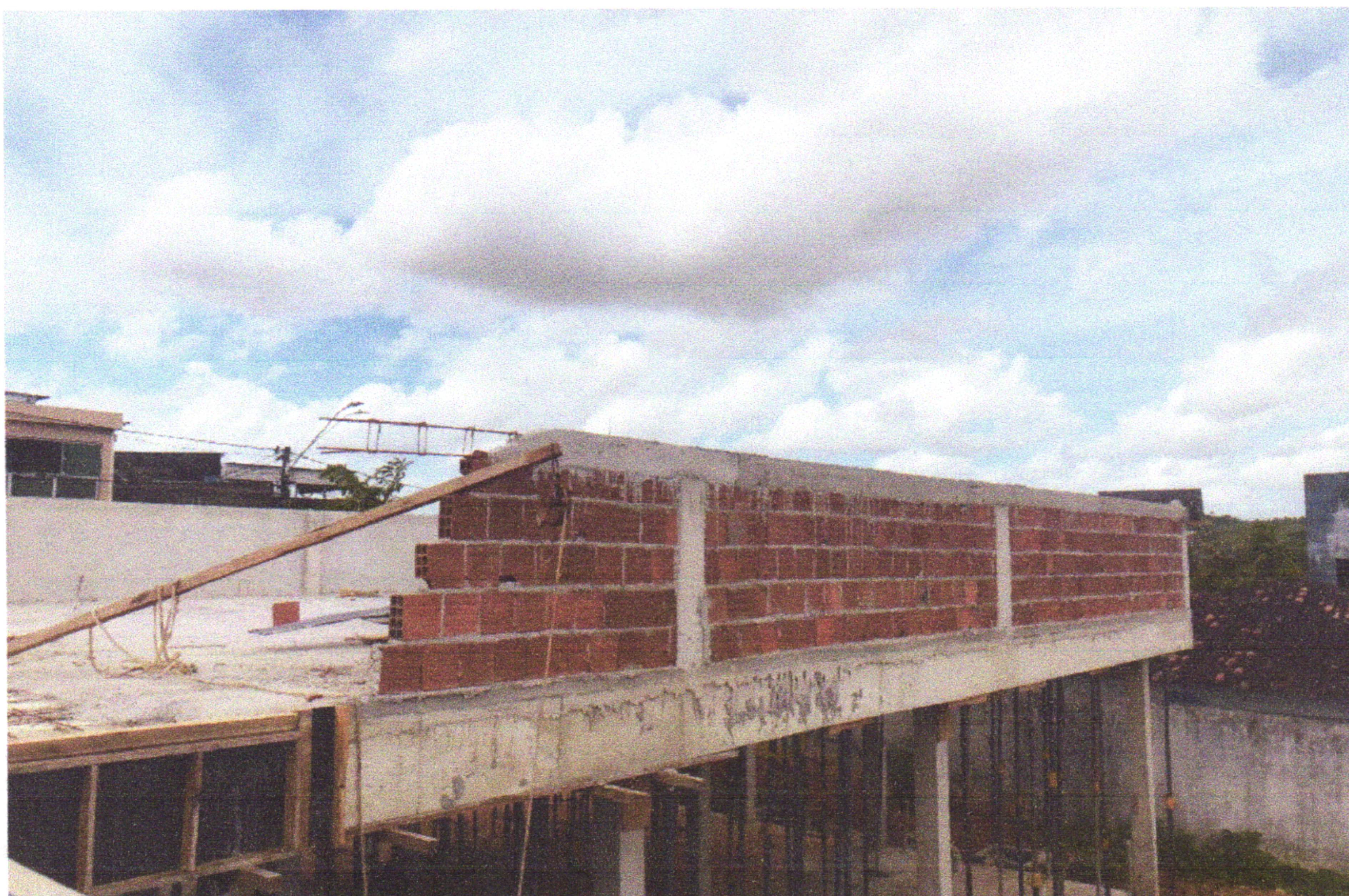
FOTO 04 (EXECUÇÃO DE PILARES E ALVENARIA DA PLATIBANDA)
