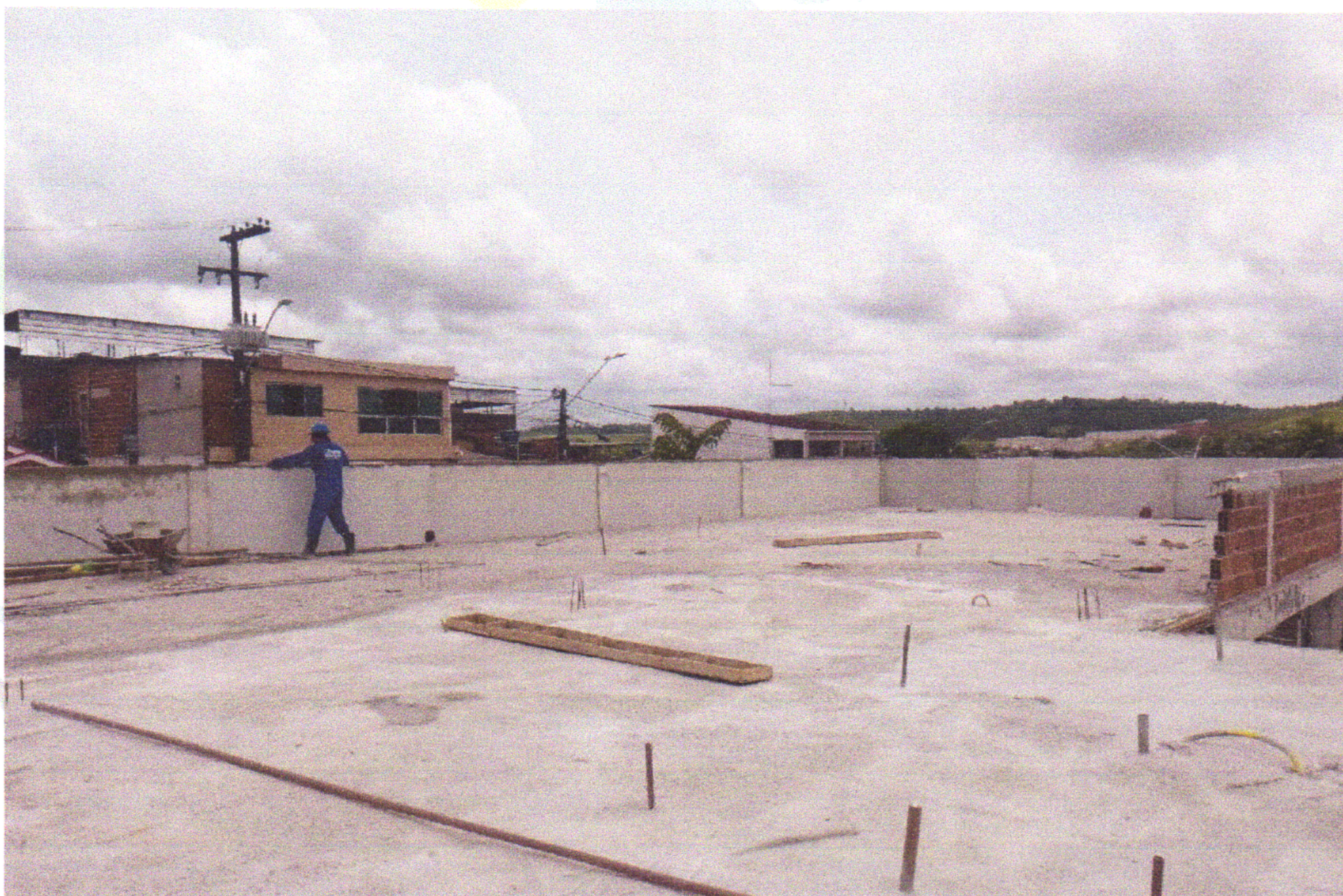
FOTO 17 (REVESTIMENTO INTERNO DA PLATIBANDA)
