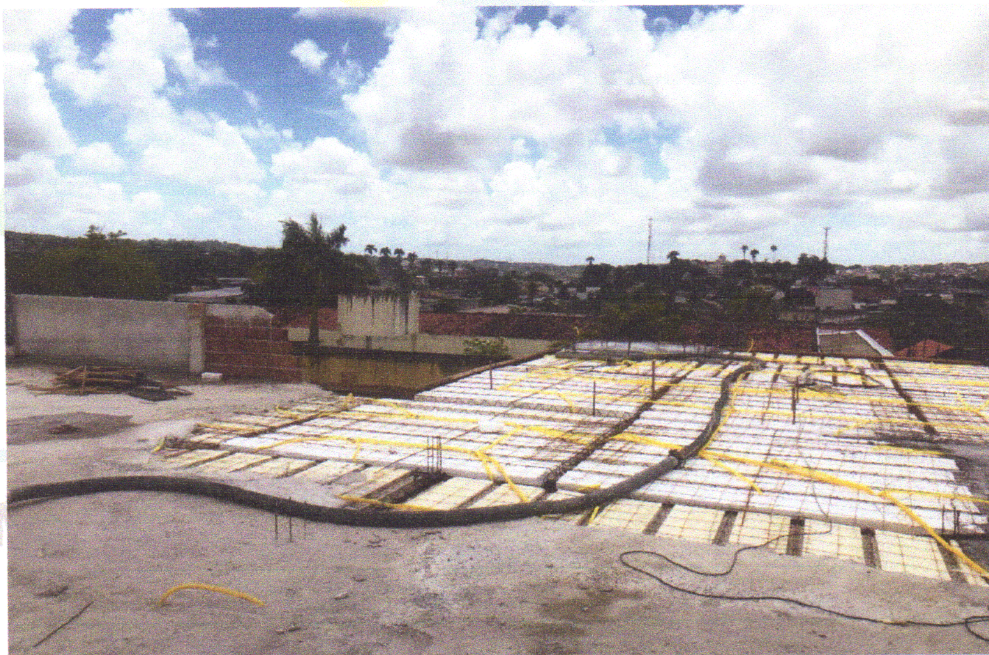
FOTO 11 (CONCRETAGEM DE VIGAS E LAJE)
