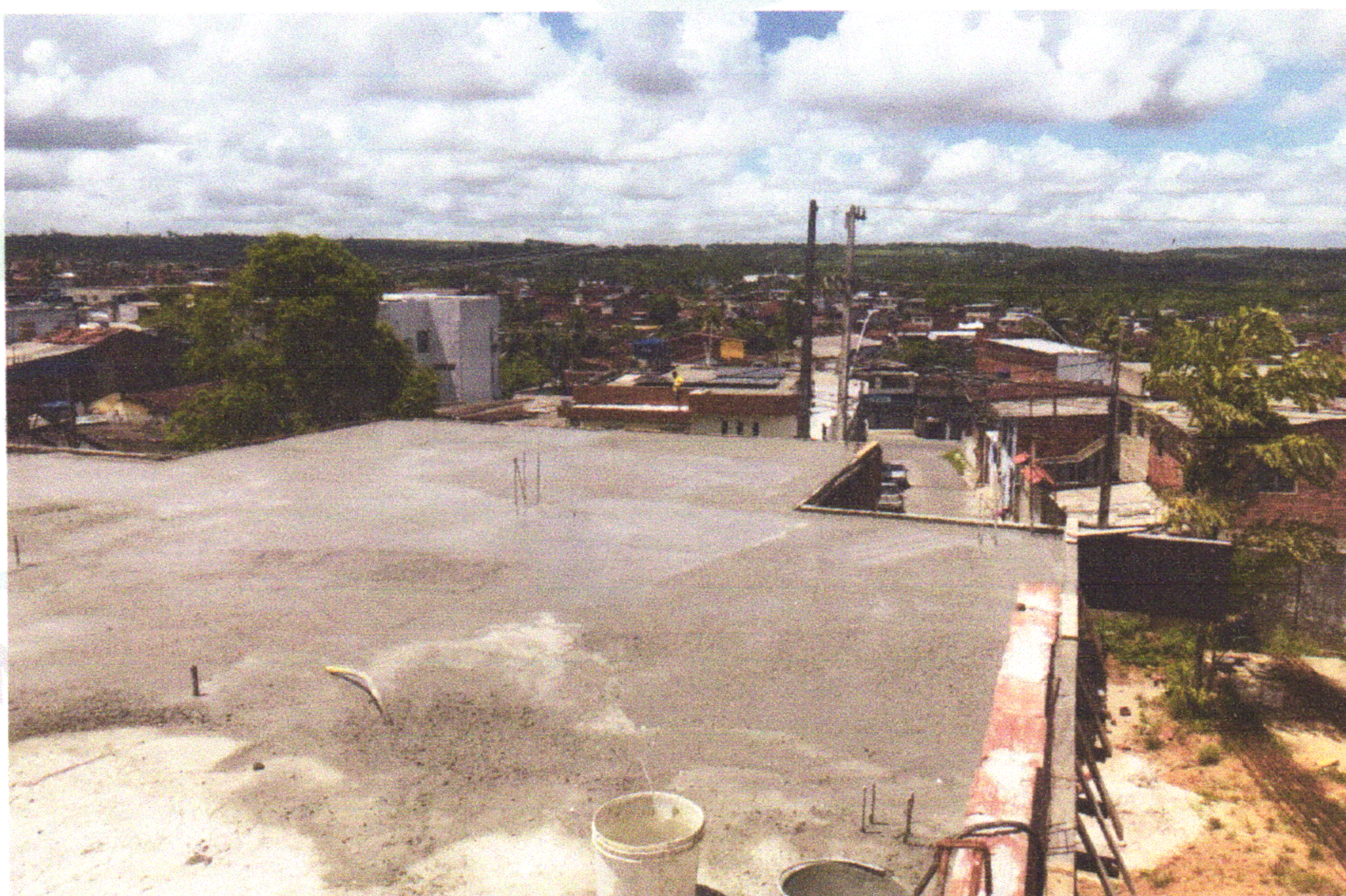
FOTO 09 (CONCRETAGEM DE VIGAS E LAJE)
