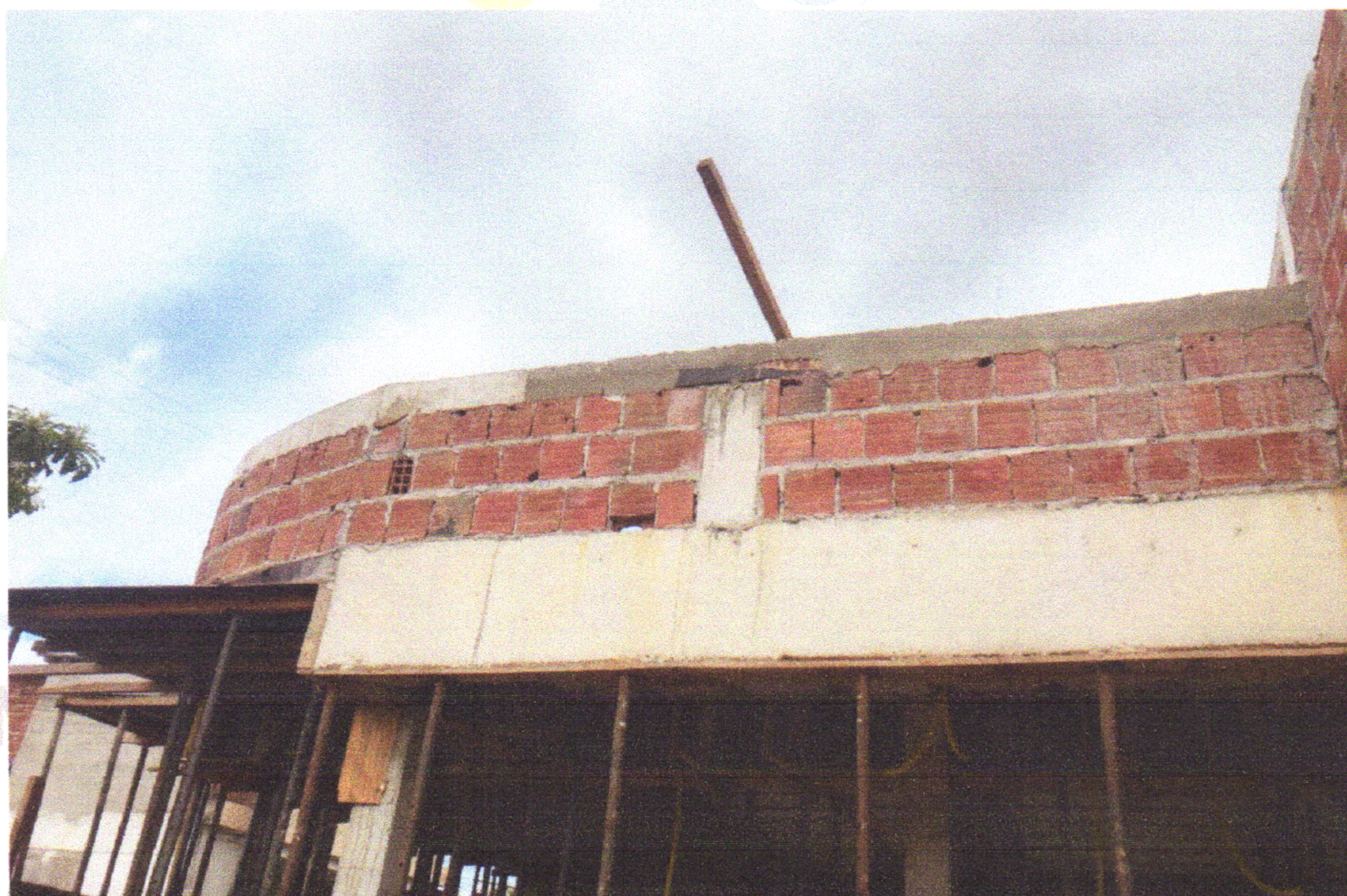
FOTO 07 (EXECUÇÃO DE PILARES E ALVENARIA DA PLATIBANDA)
