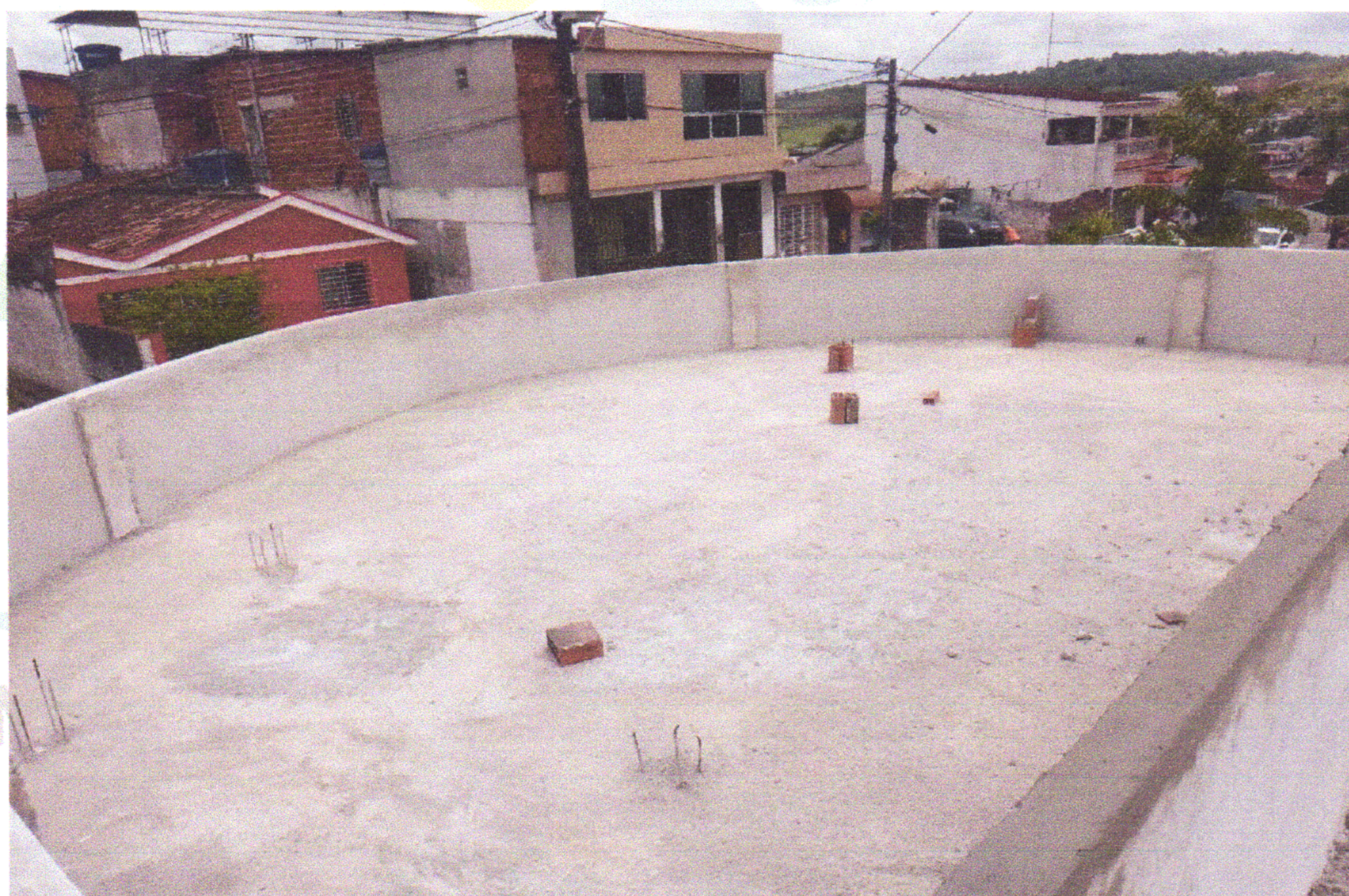
FOTO 15 (REVESTIMENTO INTERNO DA PLATIBANDA)
