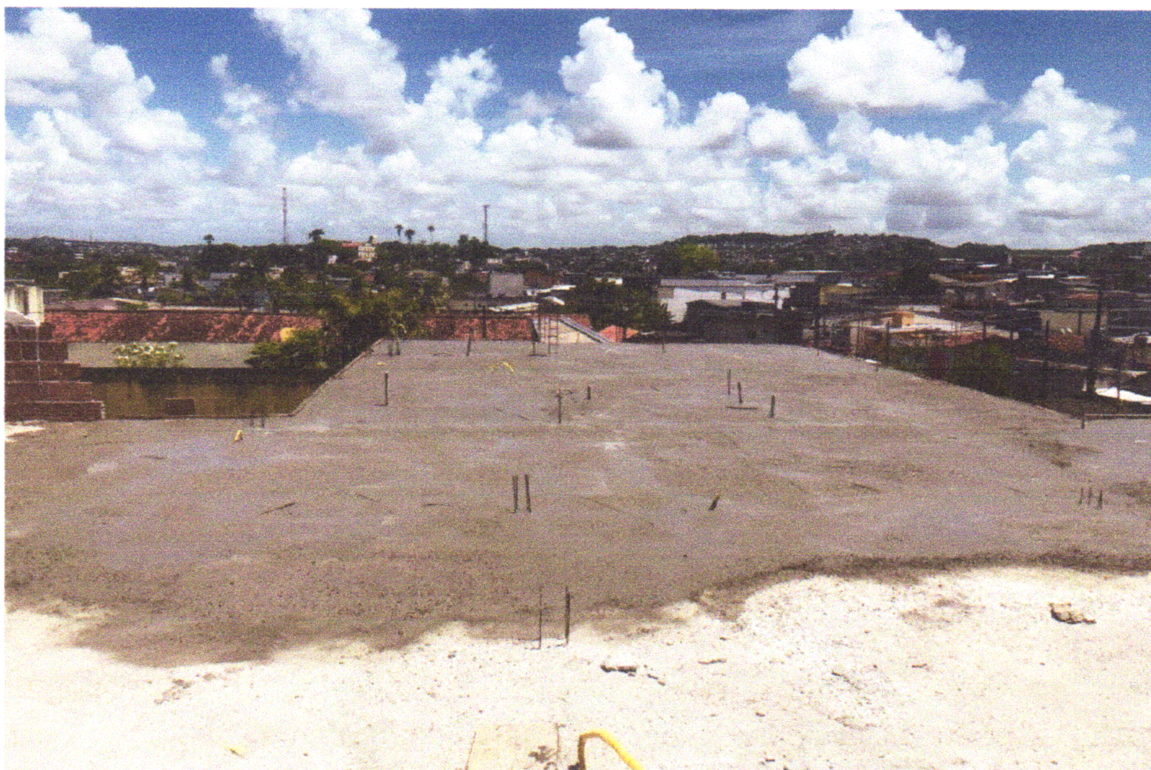
FOTO 12 (CONCRETAGEM DE VIGAS E LAJE)
