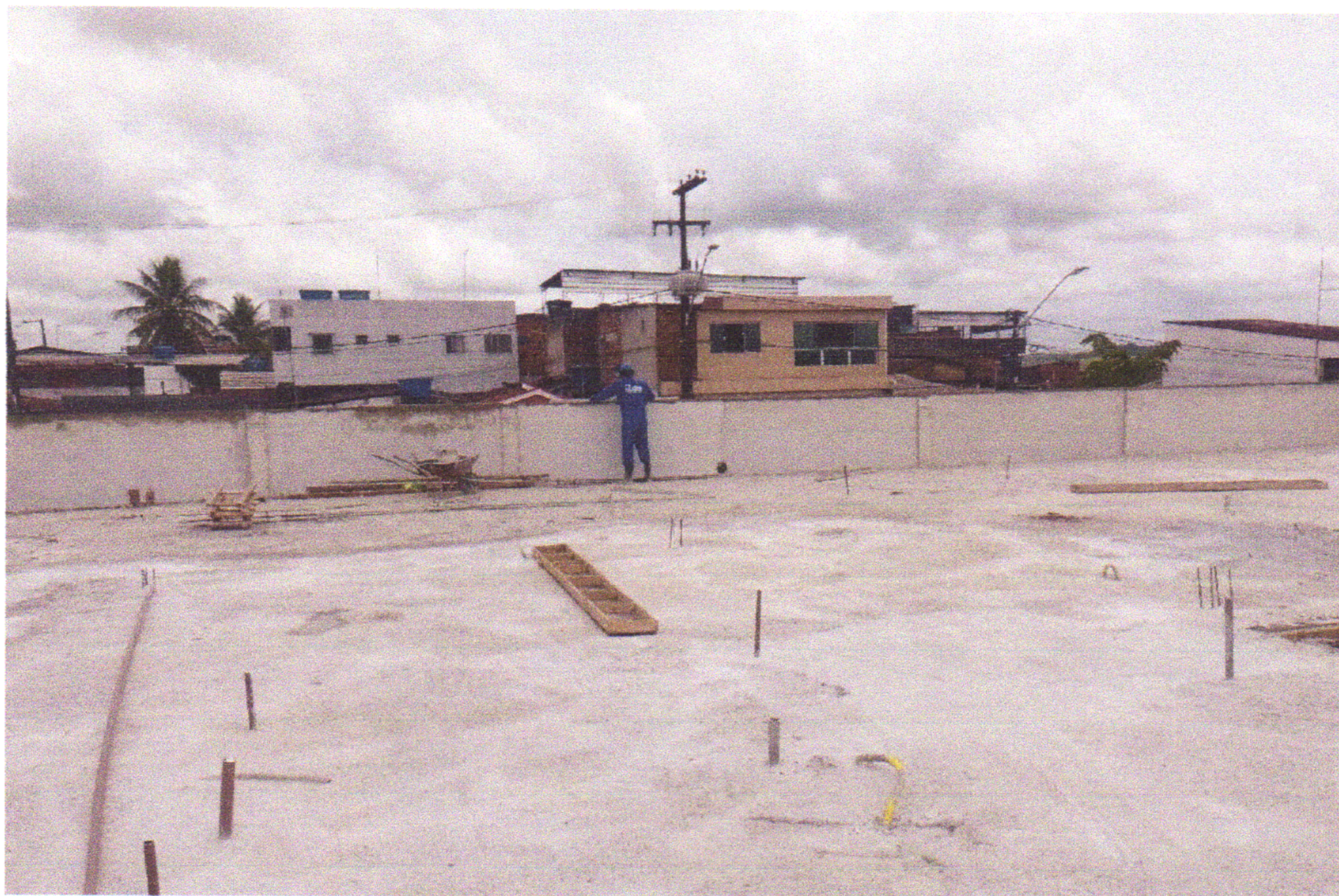
FOTO 16 (REVESTIMENTO INTERNO DA PLATIBANDA)
