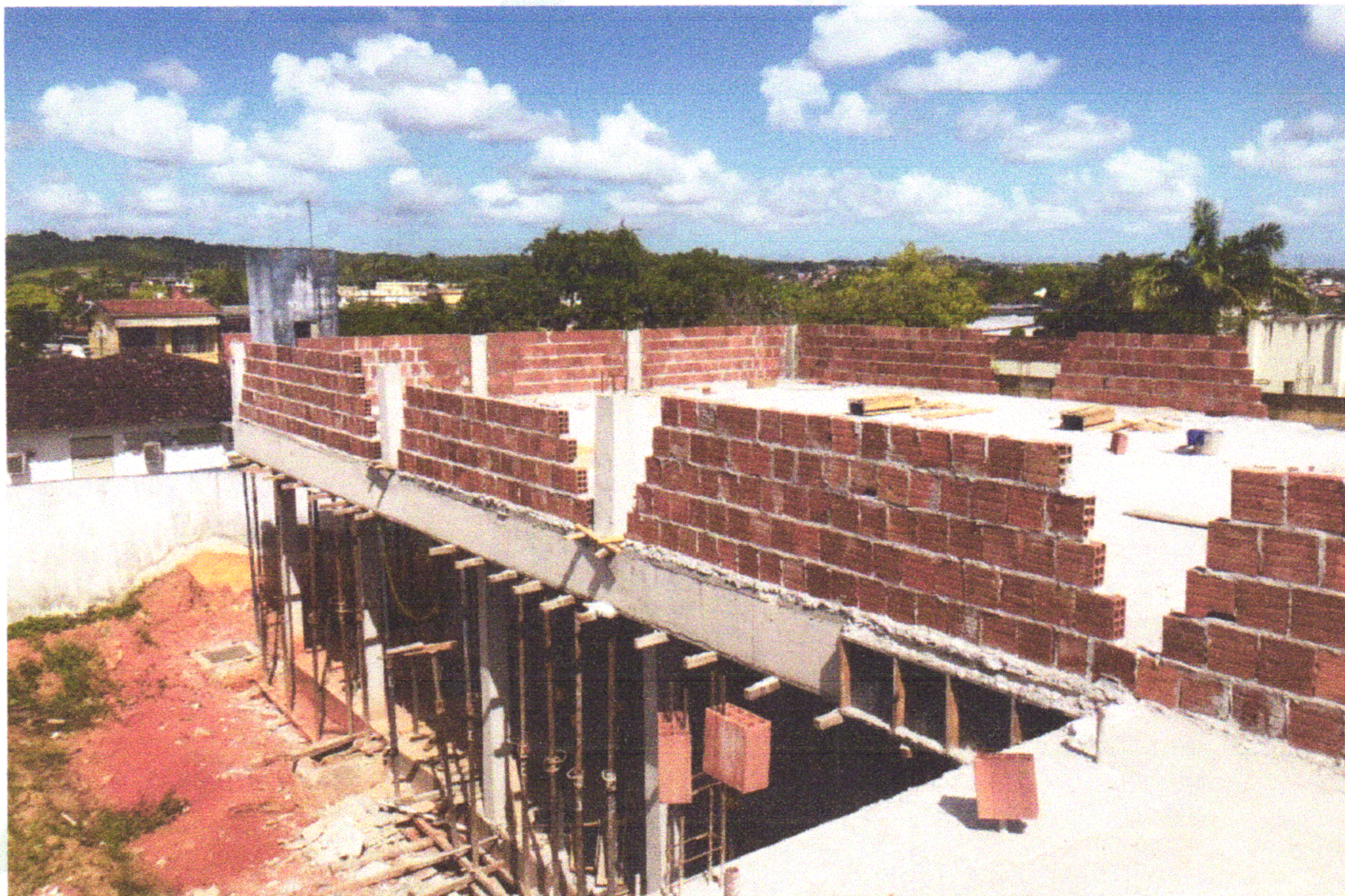
FOTO 01 (EXECUÇÃO DE PILARES E ALVENARIA DA PLATIBANDA)
