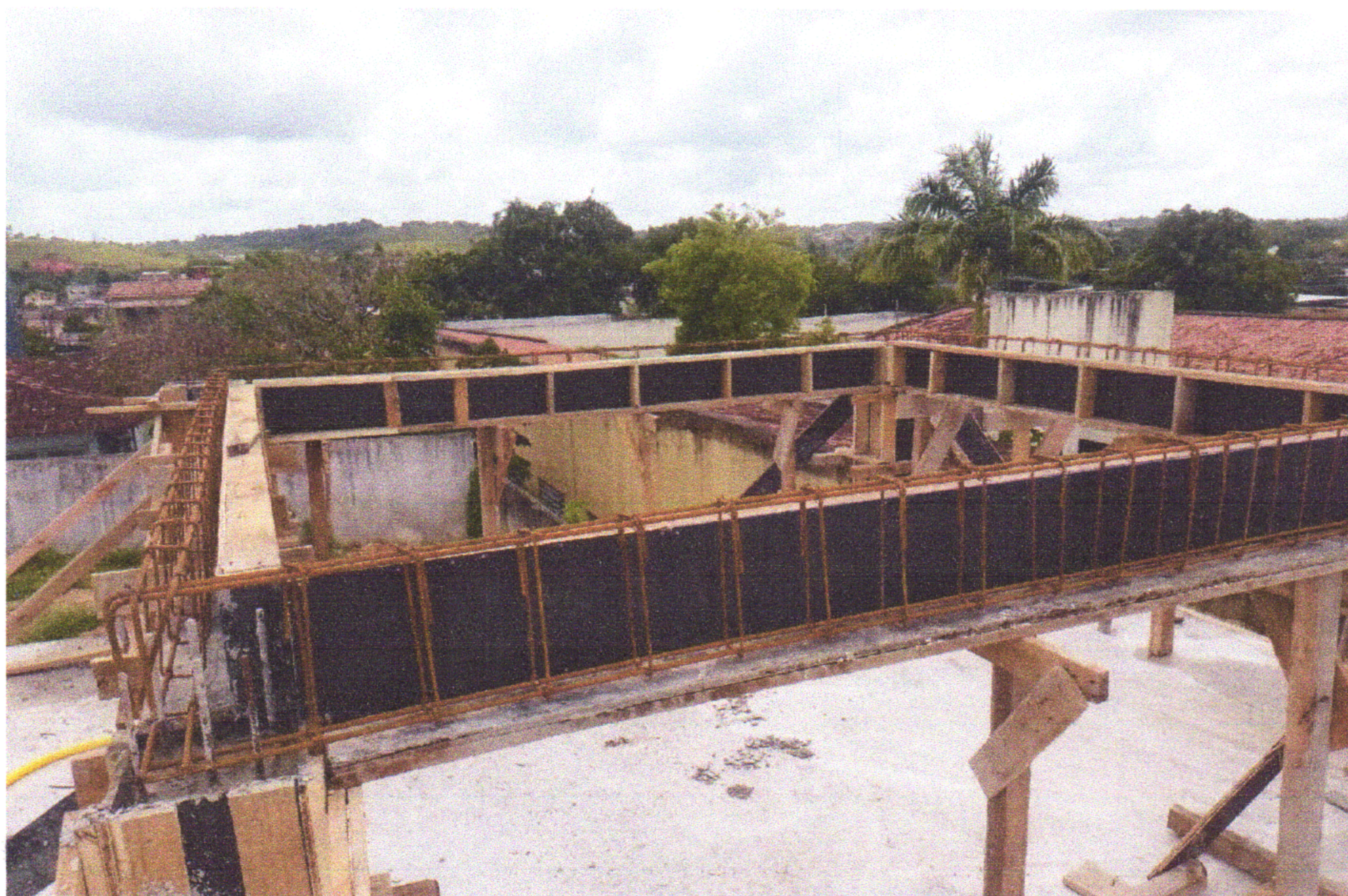
FOTO 14 (FÔRMA E ARMAÇÃO DA LAJE DAS VIGAS DO RESERVATÓRIO SUPERIOR)
