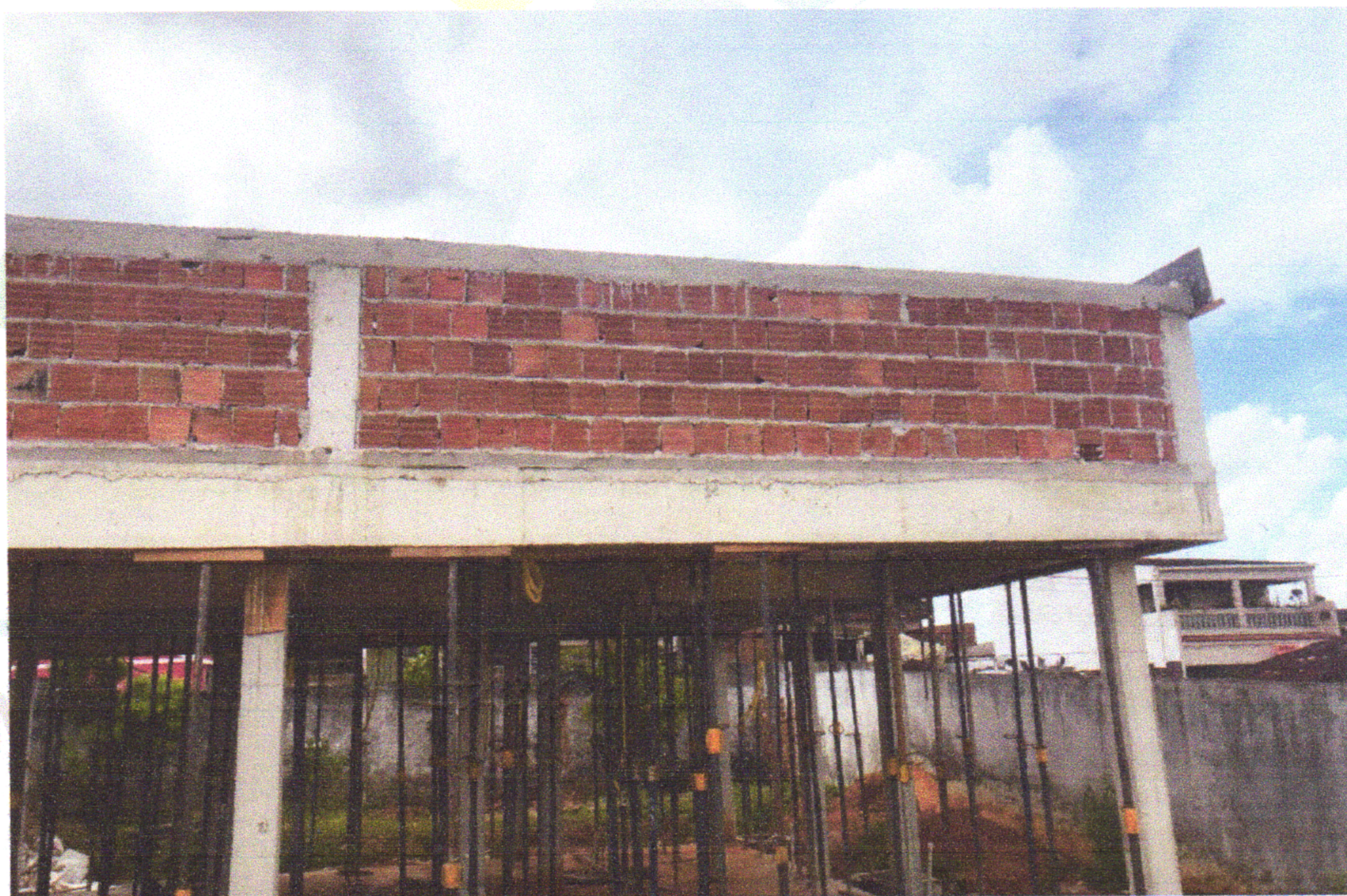
FOTO 05 (EXECUÇÃO DE PILARES E ALVENARIA DA PLATIBANDA)
