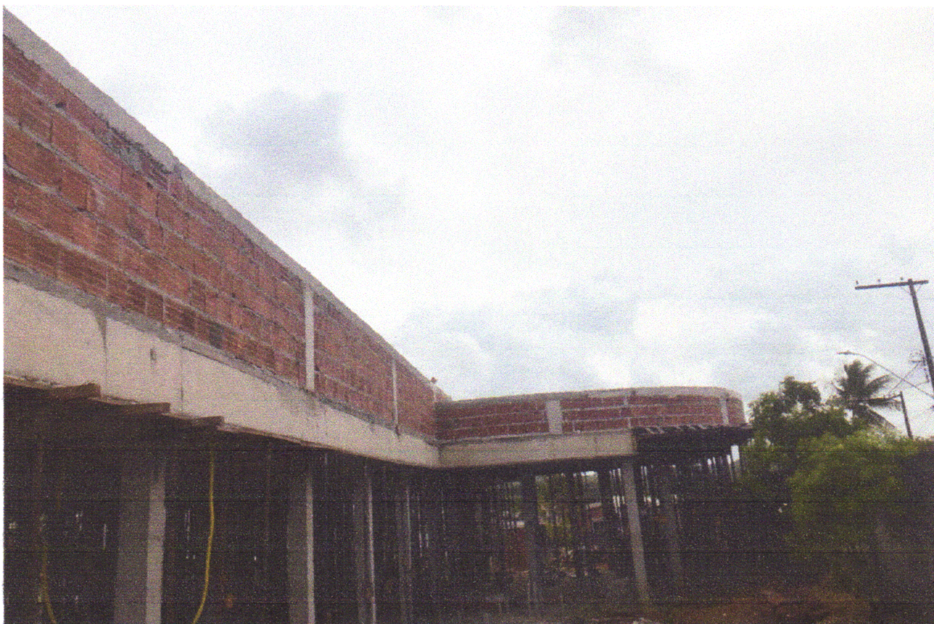
FOTO 06 (EXECUÇÃO DE PILARES E ALVENARIA DA PLATIBANDA)
