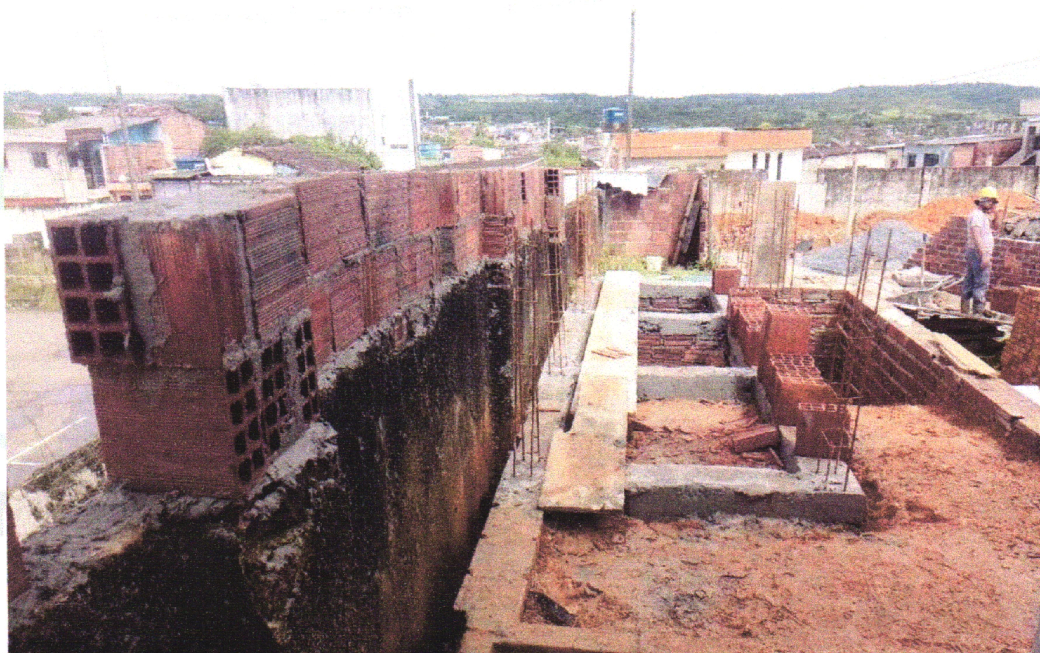
FOTO 11 (EXECUÇÃO DO ABRIDO DE RESÍDUOS - VIGA BALDRAME)
