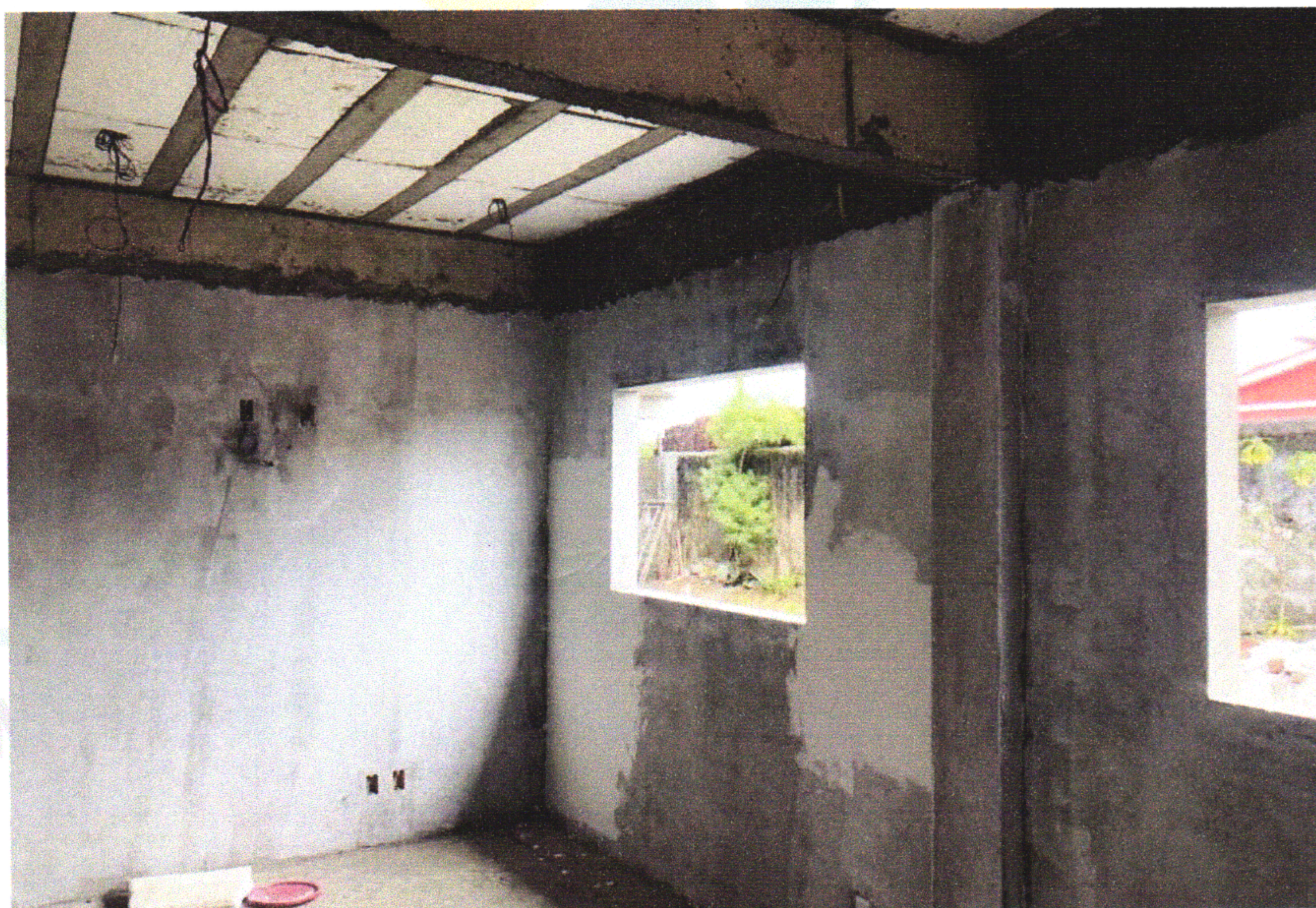
FOTO 03 (APLICAÇÃO DE SELADOR EM PAREDES INTERNAS)
