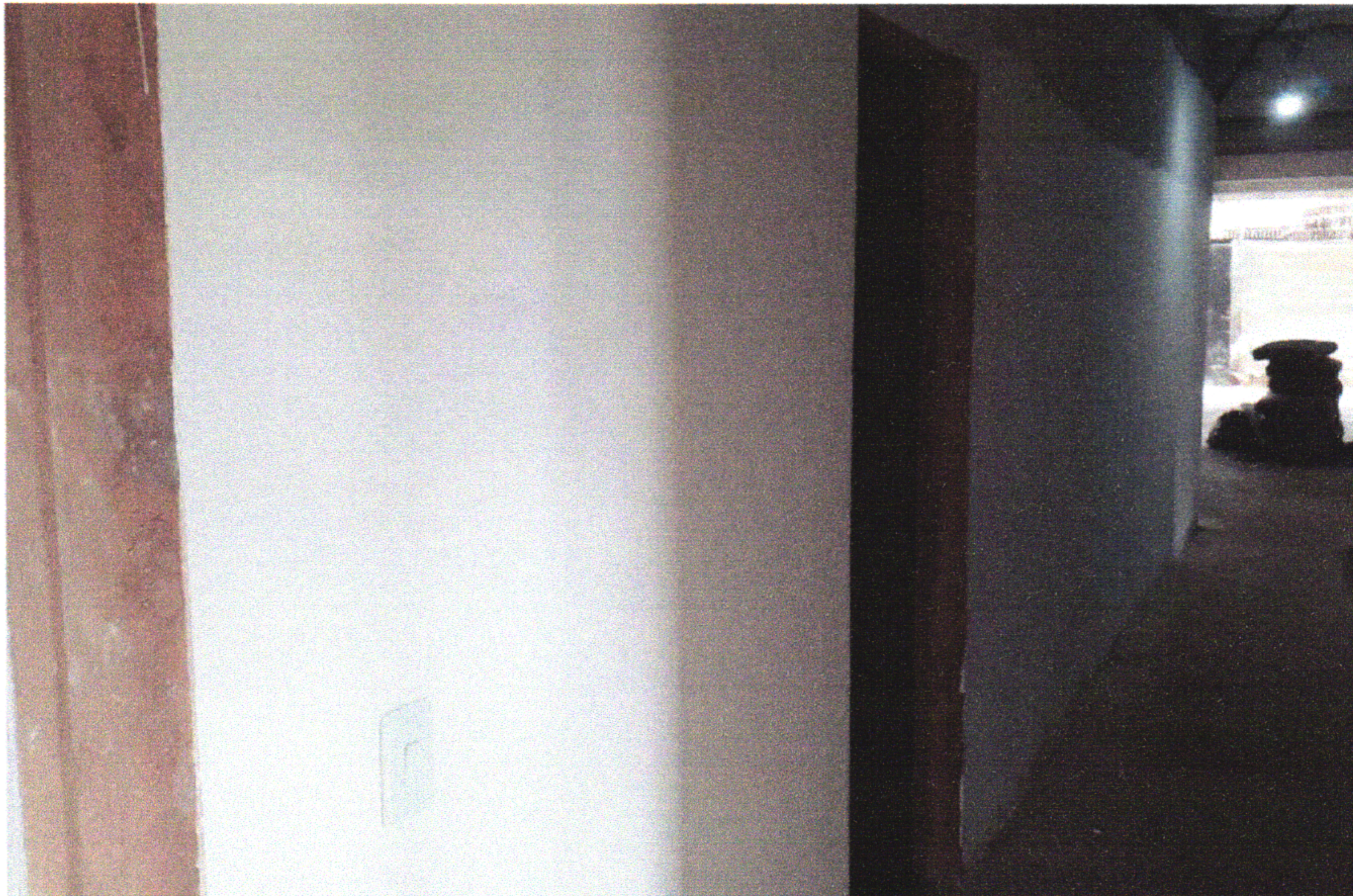
FOTO 20 (EMASSAMENTO DE PAREDES INTERNAS)
