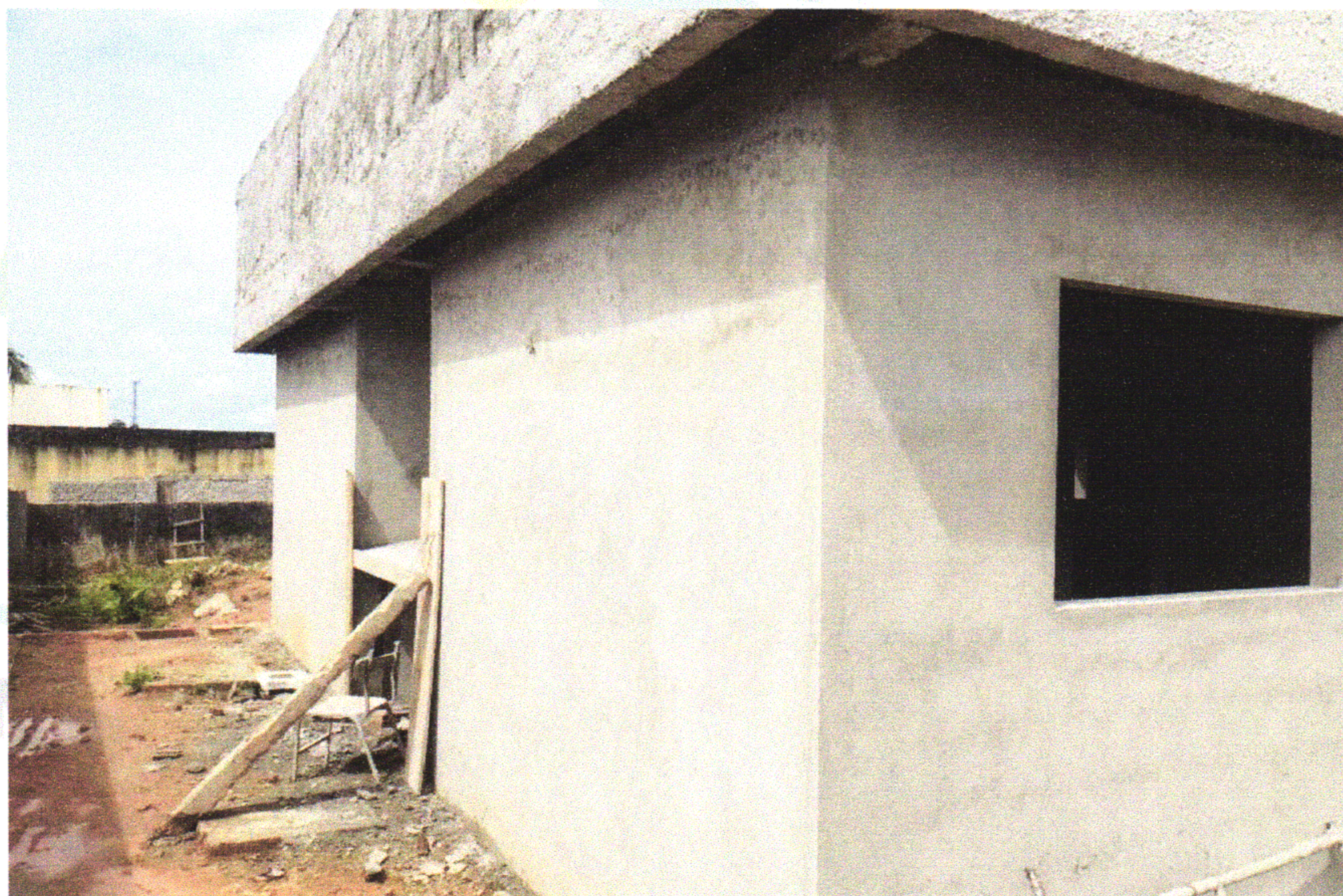
FOTO 17 (EXECUÇÃO DE CHAPISCO DA PLATIBANDA)
