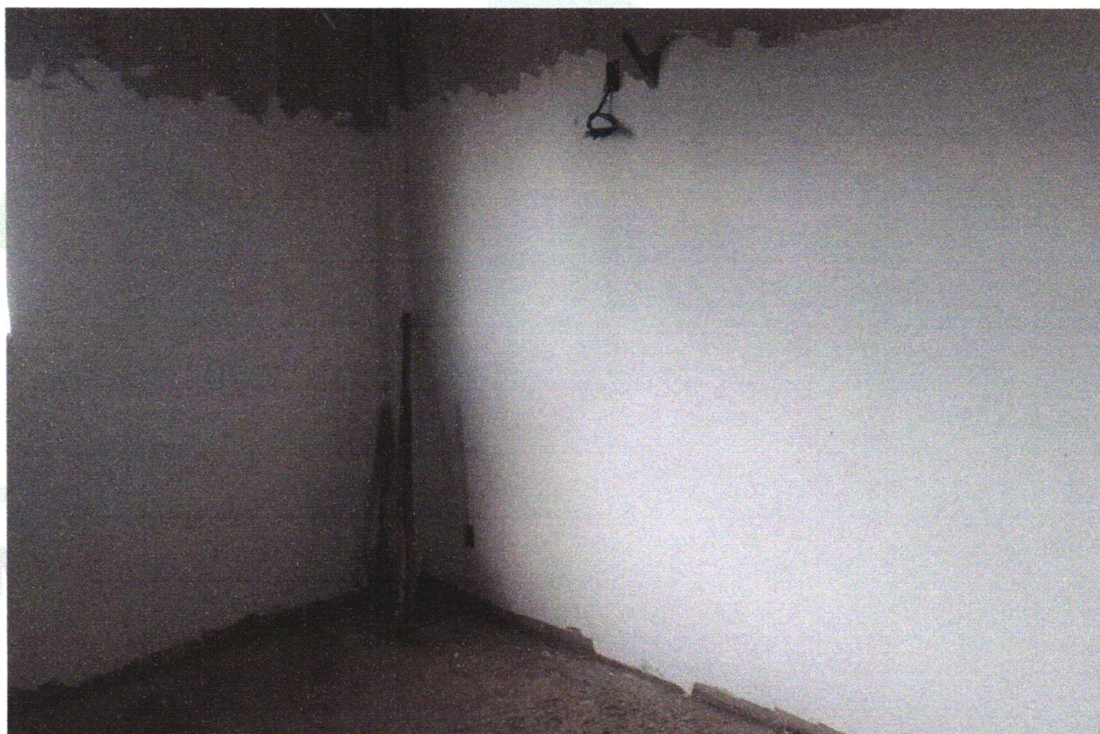
FOTO 23 (EMASSAMENTO DE PAREDES INTERNAS)
