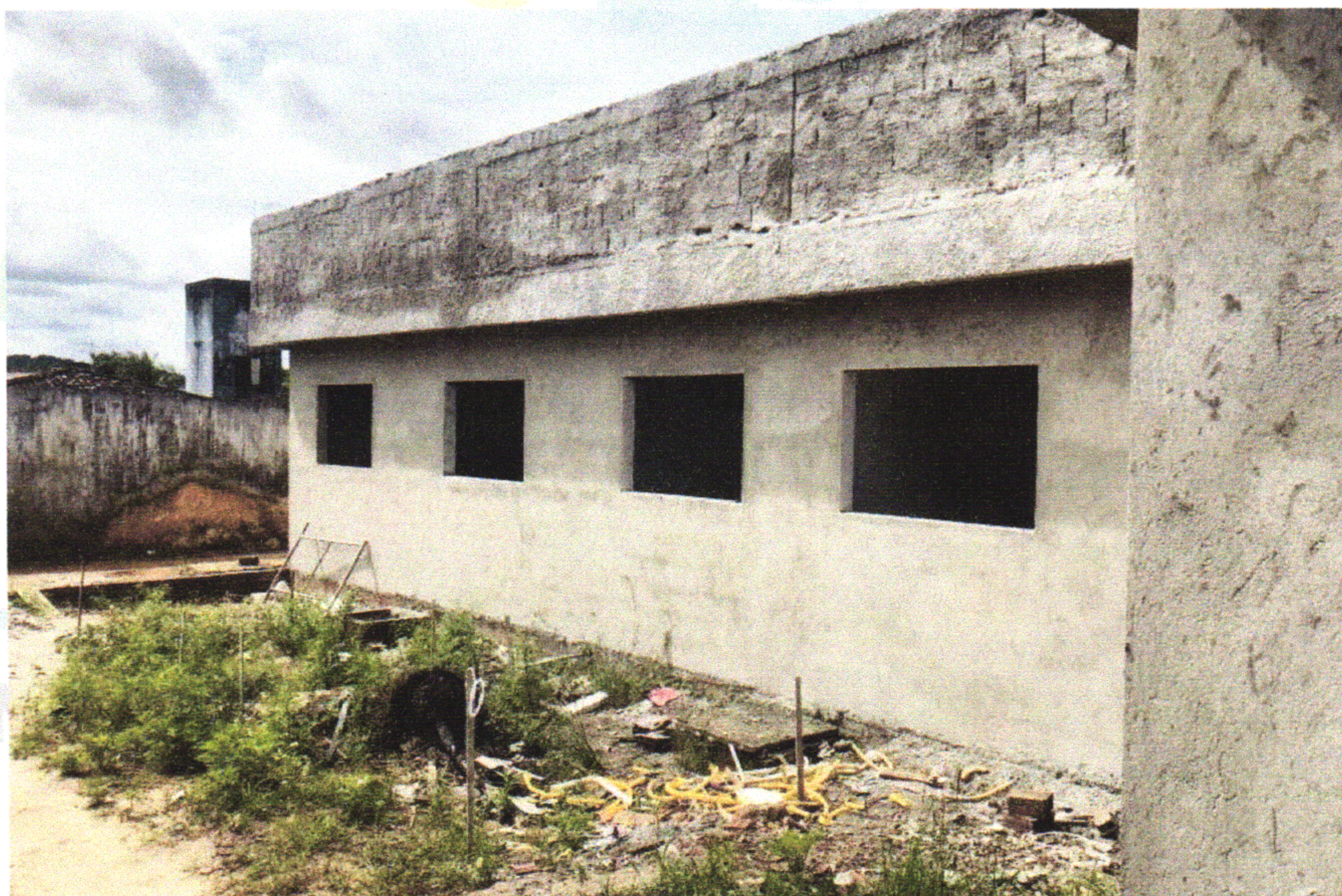
FOTO 15 (EXECUÇÃO DE CHAPISCO DA PLATIBANDA)
