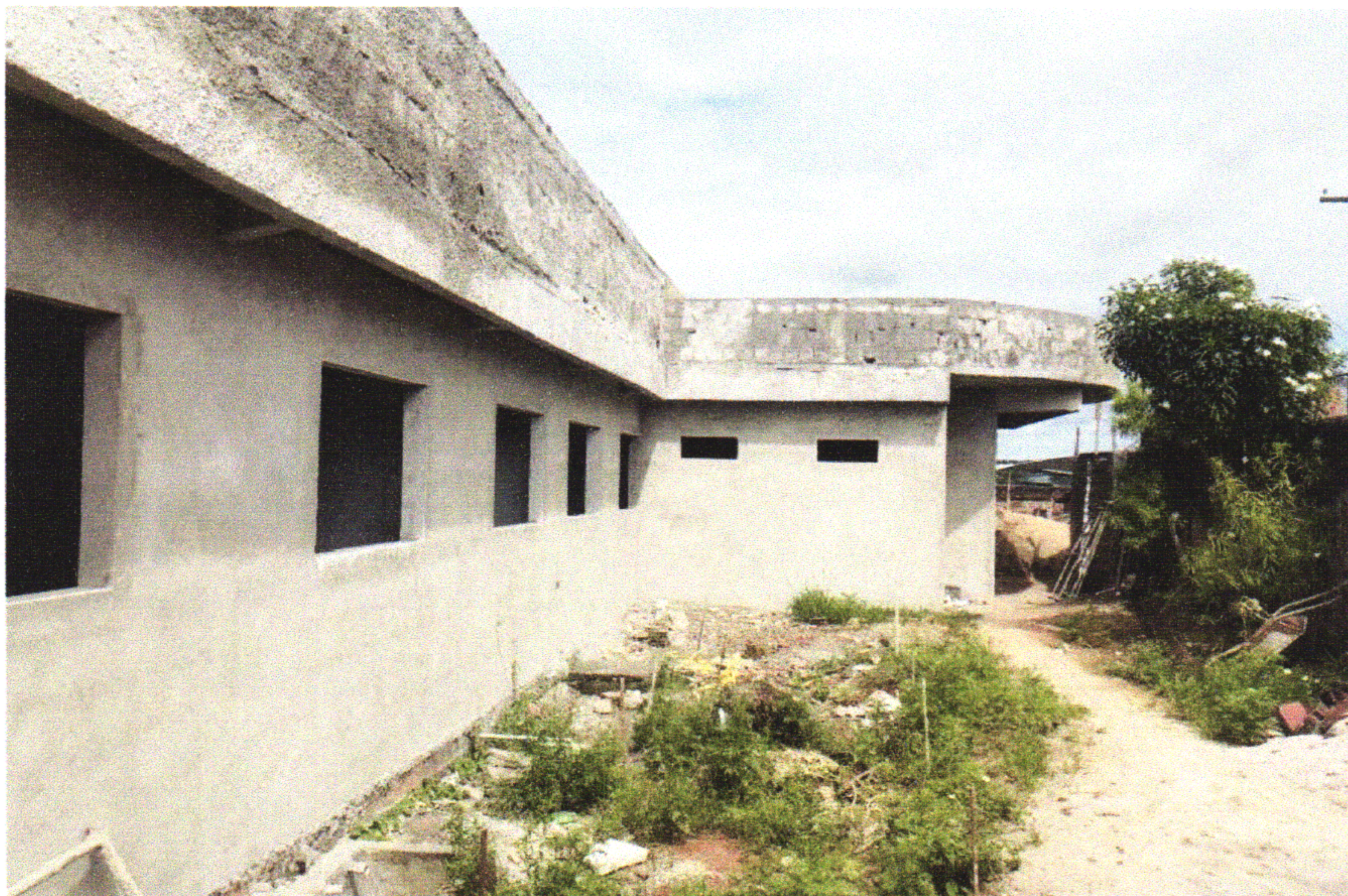
FOTO 16 (EXECUÇÃO DE CHAPISCO DA PLATIBANDA)
