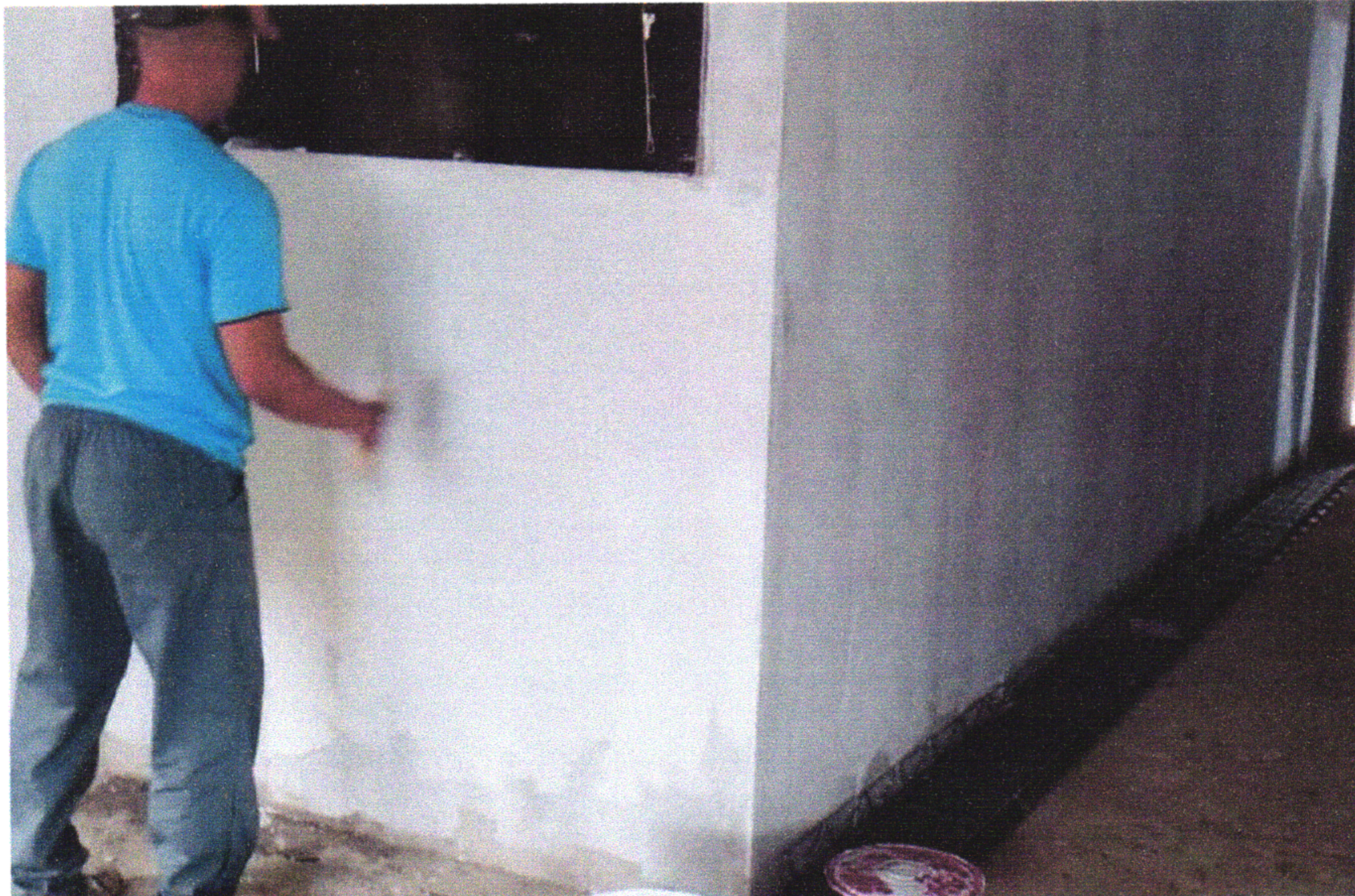
FOTO 06 (EMASSAMENTO EM PAREDES INTERNAS)
