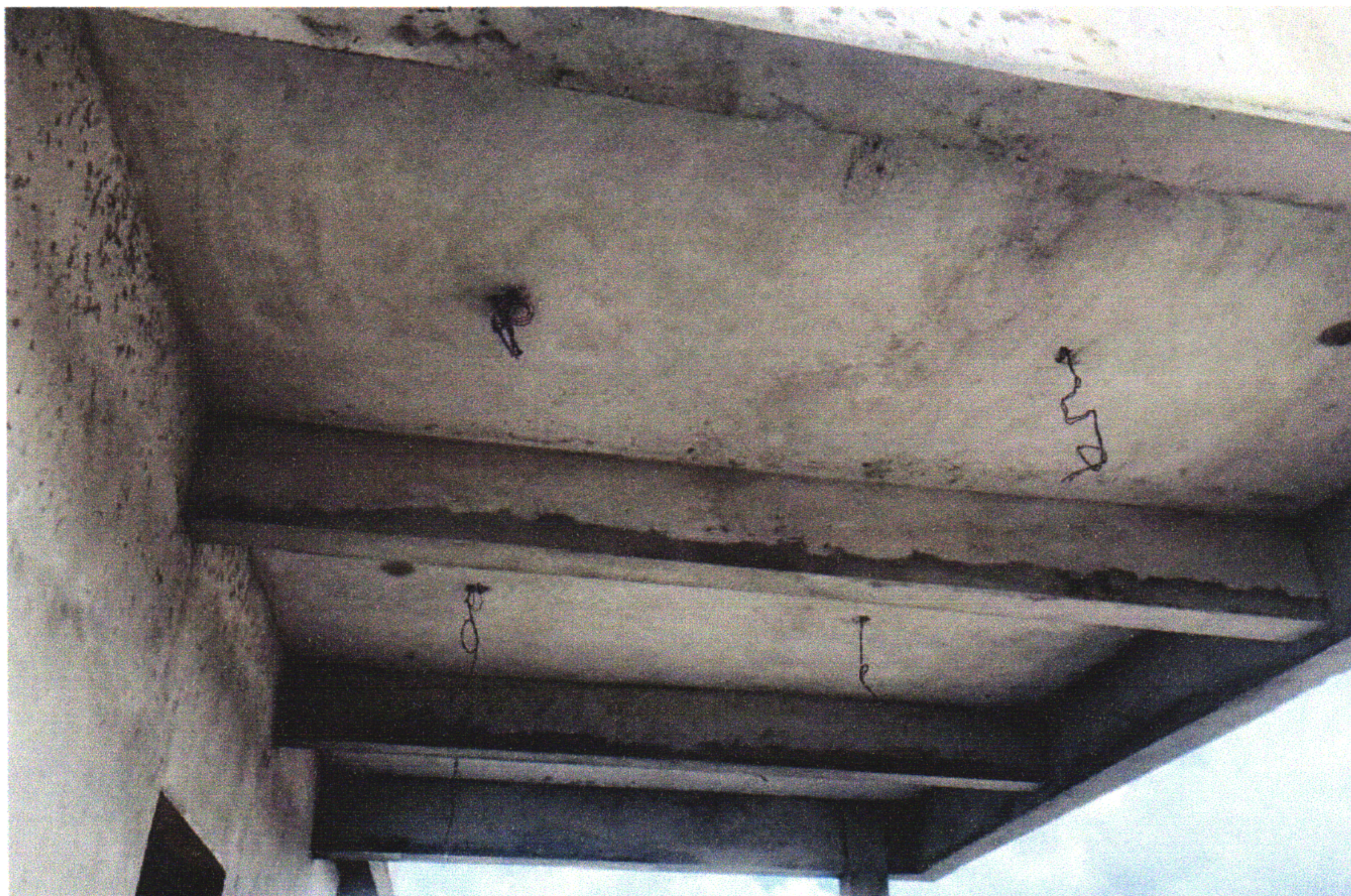
FOTO 14 (EXECUÇÃO DE EMBOÇO/MASSA ÚNICA EM TETO)
