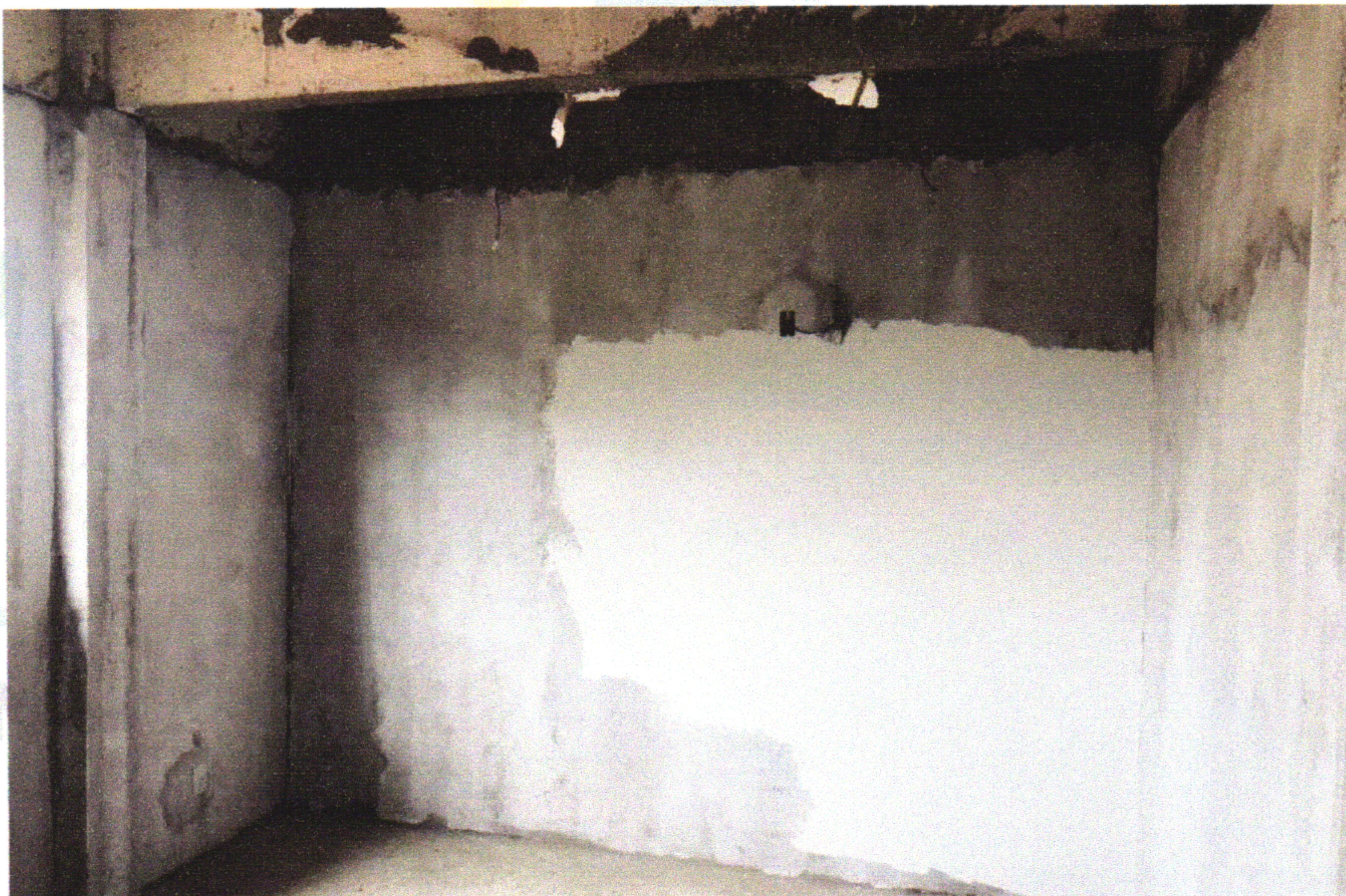
FOTO 07 (APLICAÇÃO DE SELADOR EM PAREDES INTERNAS)
