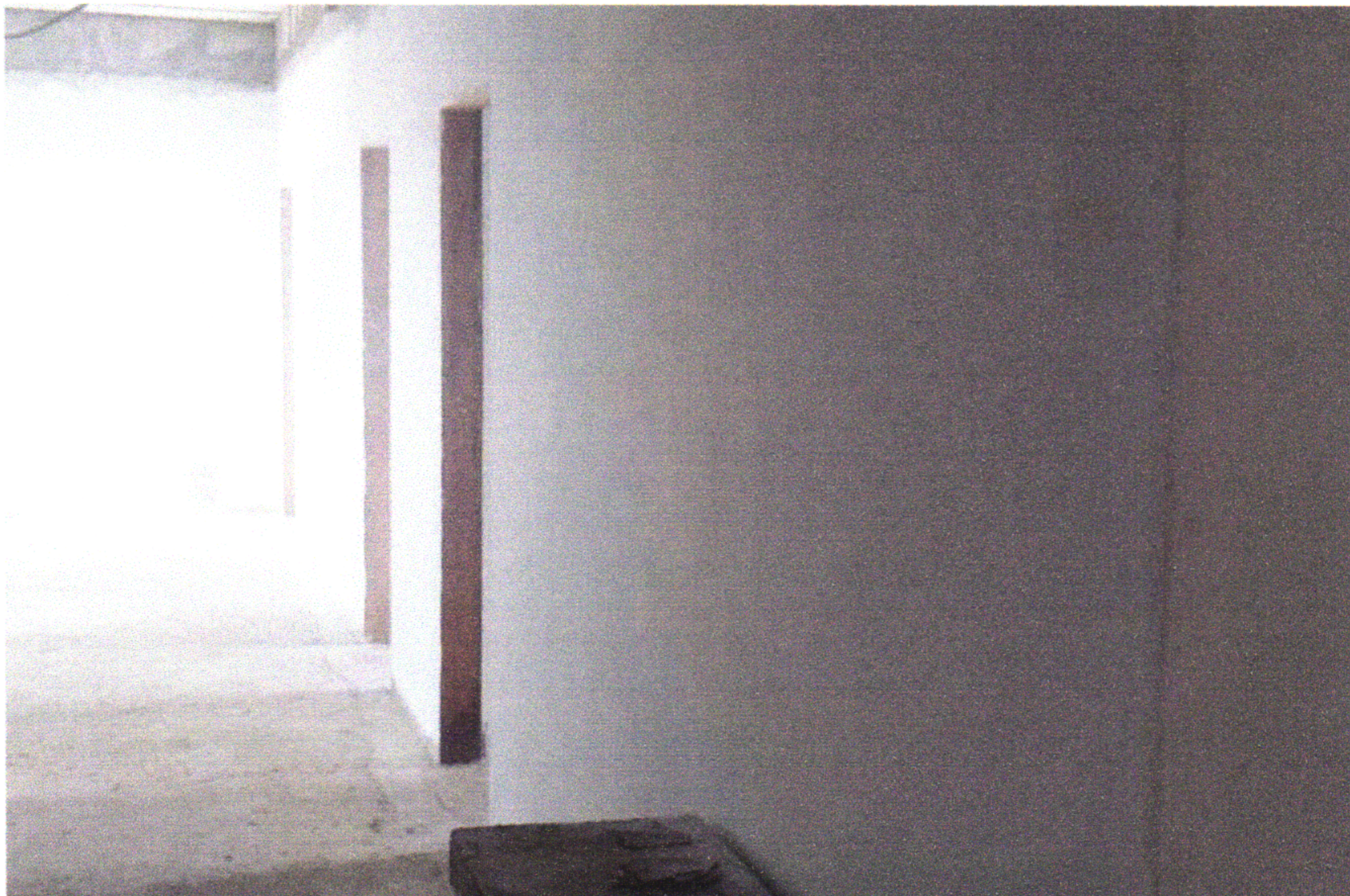
FOTO 22 (EMASSAMENTO DE PAREDES INTERNAS)
