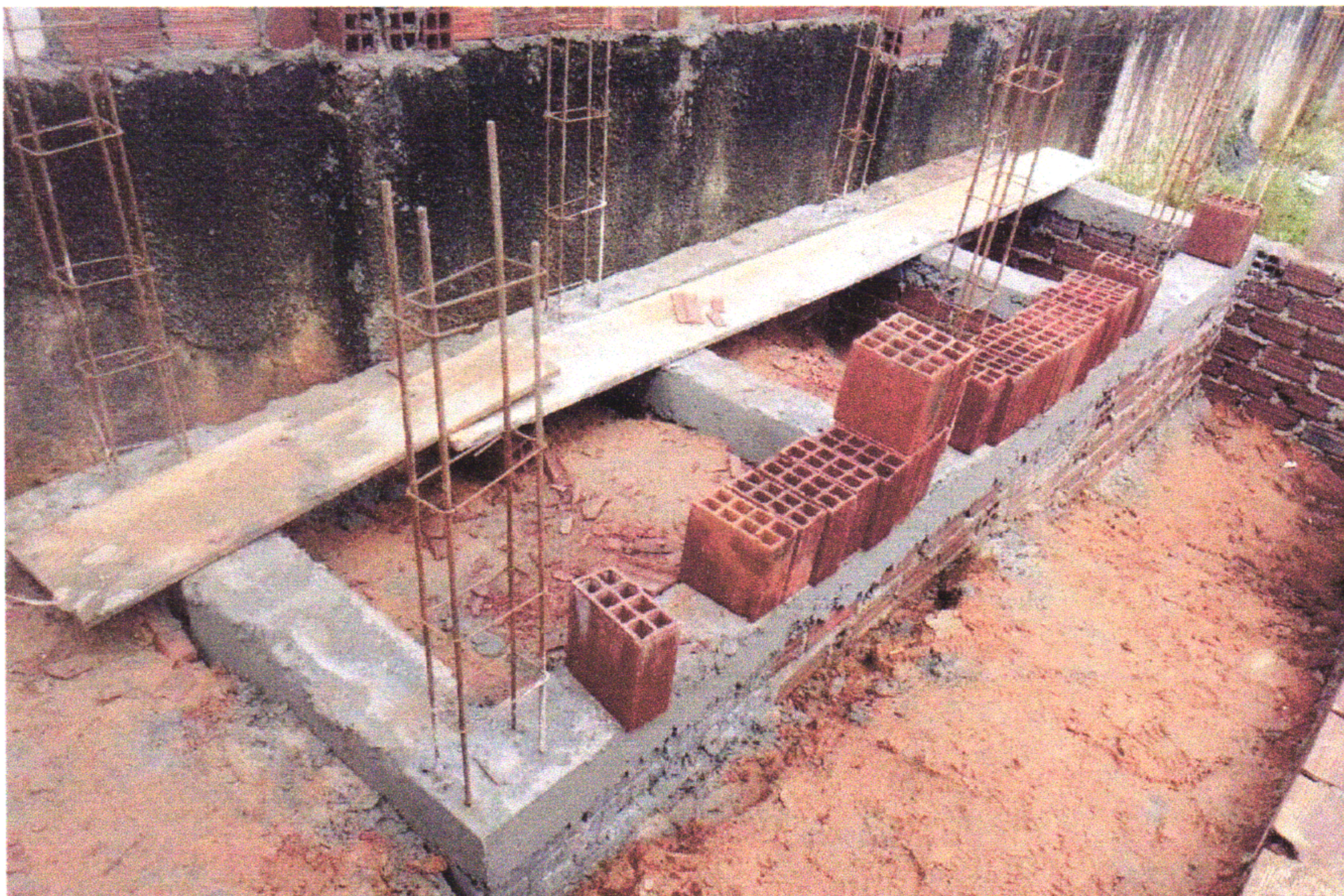
FOTO 12 (EXECUÇÃO DO ABRIDO DE RESÍDUOS - VIGA BALDRAME, ALV. DE EMBASAMENTO)
