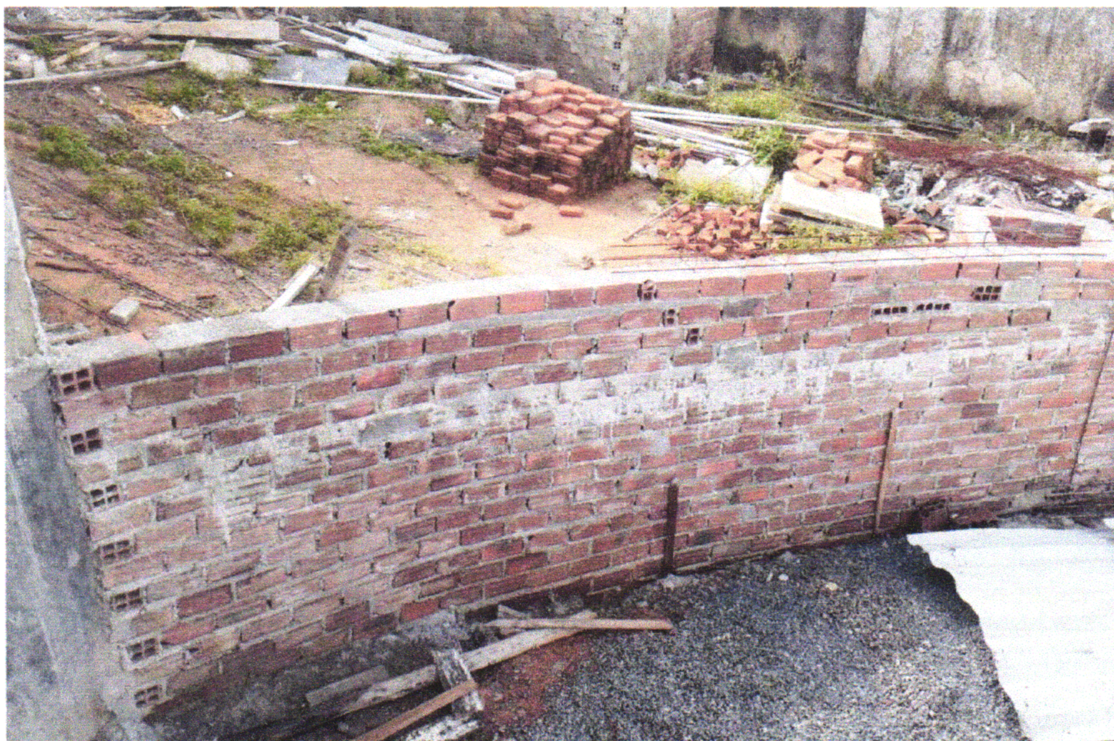
FOTO 18 (CONTENÇÃO DE ATERRO EM ALVENARIA DE 1 VEZ)
