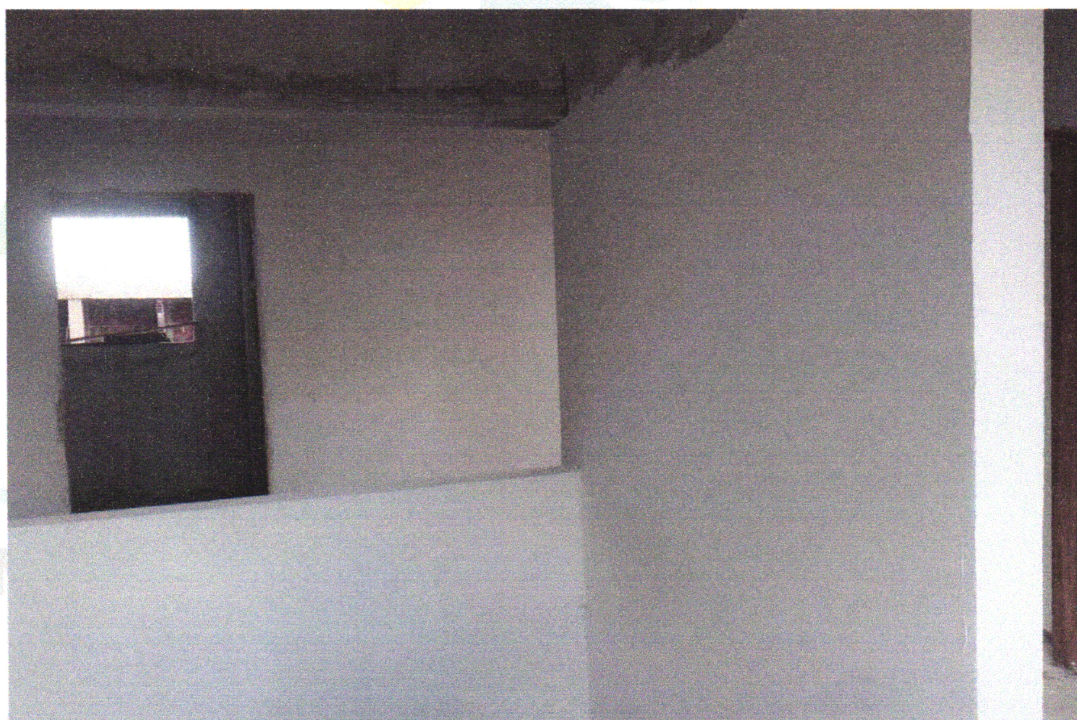
FOTO 25 (EMASSAMENTO DE PAREDES INTERNAS)
