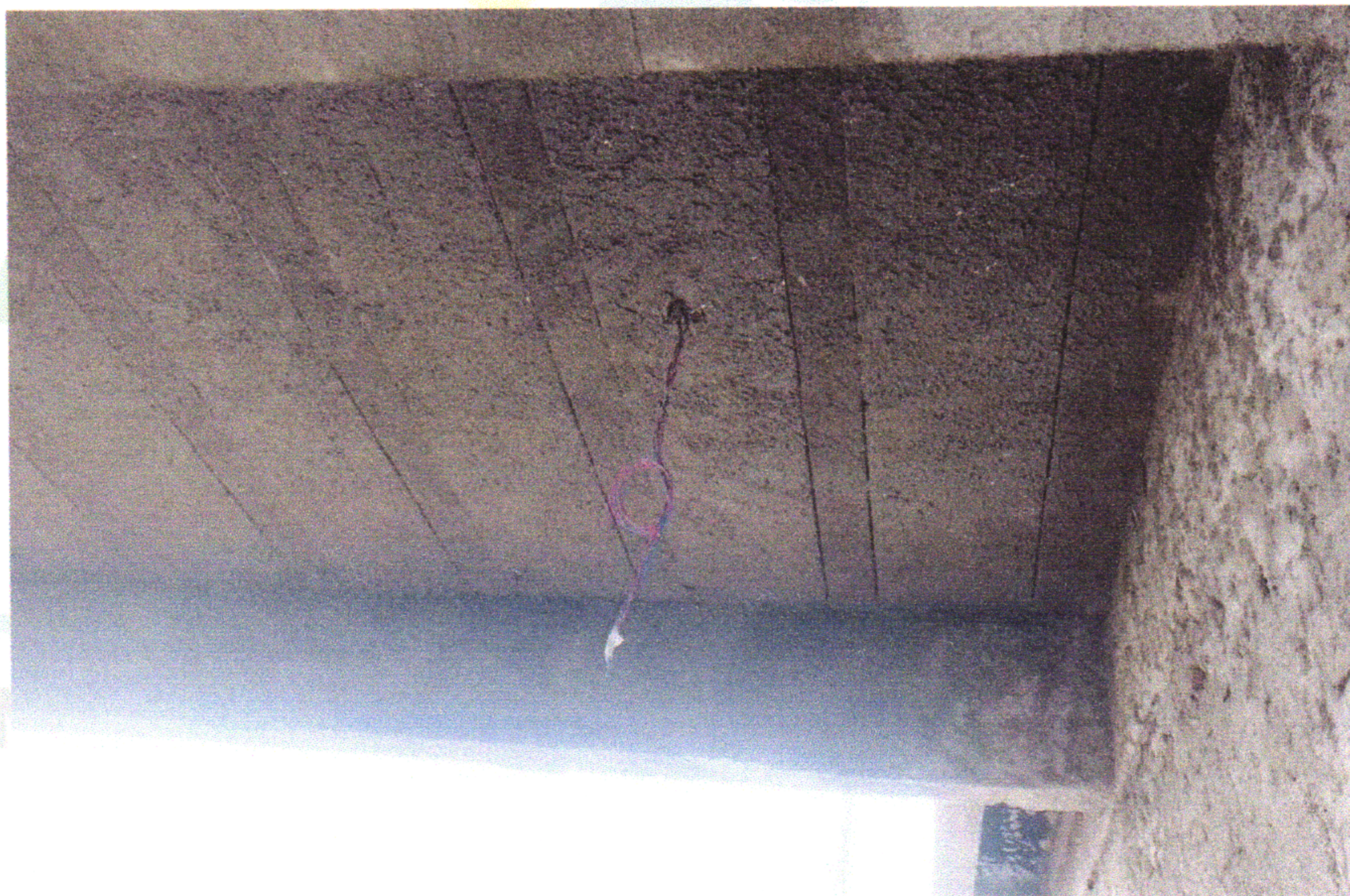
FOTO 09 (EXECUÇÃO DE CHAPISCO APLICADO EM TETO)
