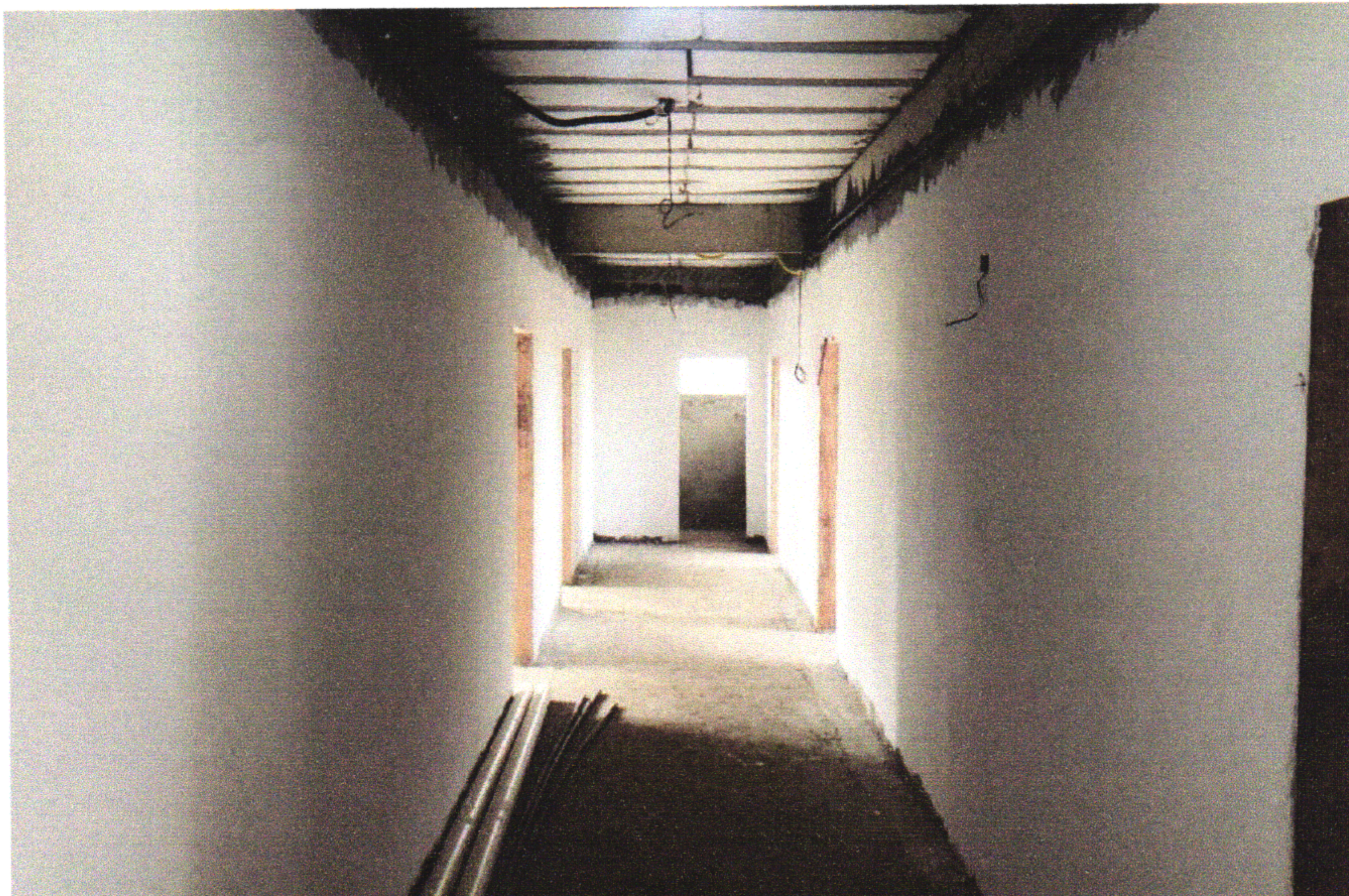
FOTO 08 (EMASSAMENTO EM PAREDES INTERNAS)
