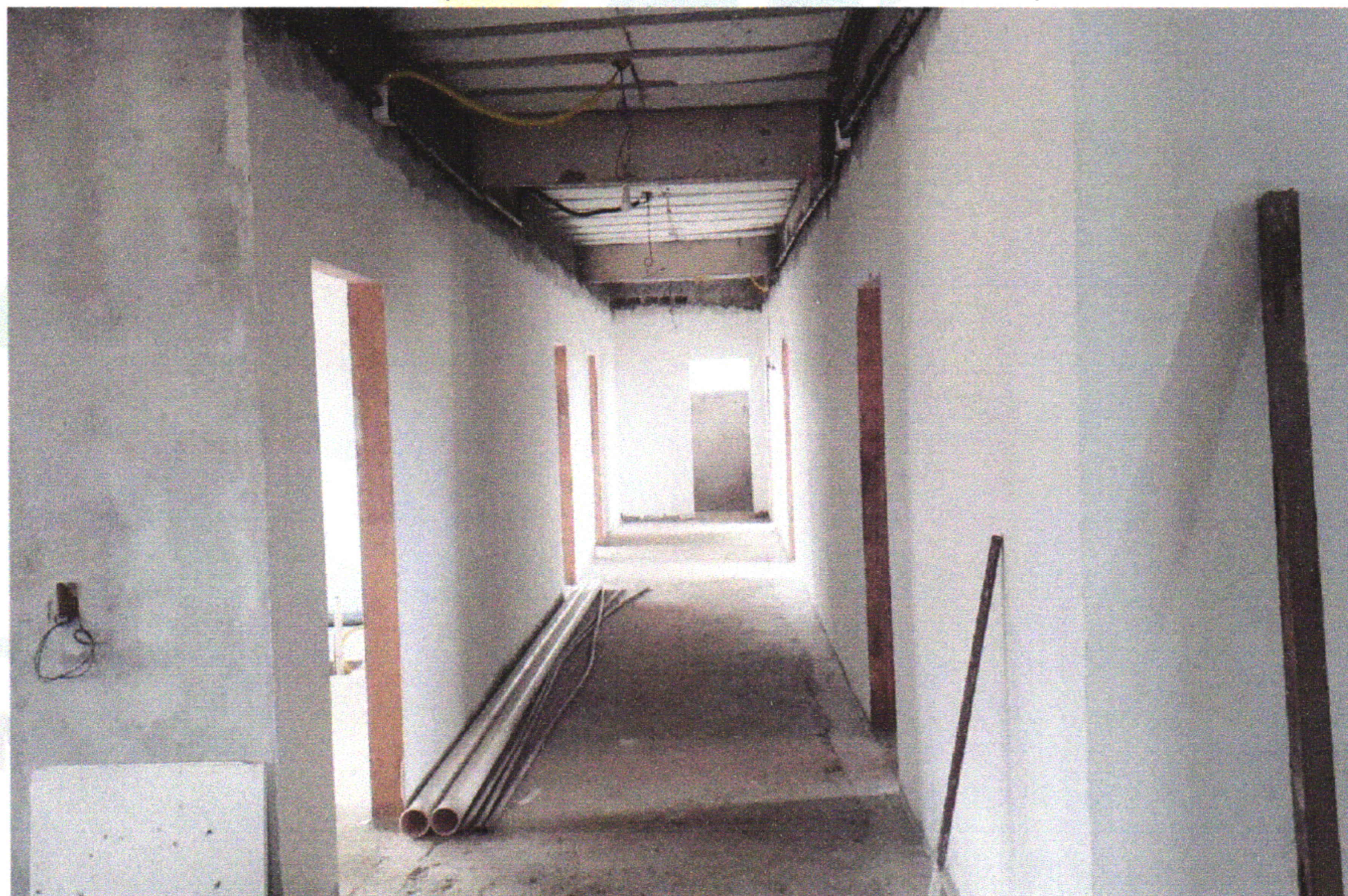
FOTO 21 (EMASSAMENTO DE PAREDES INTERNAS)
