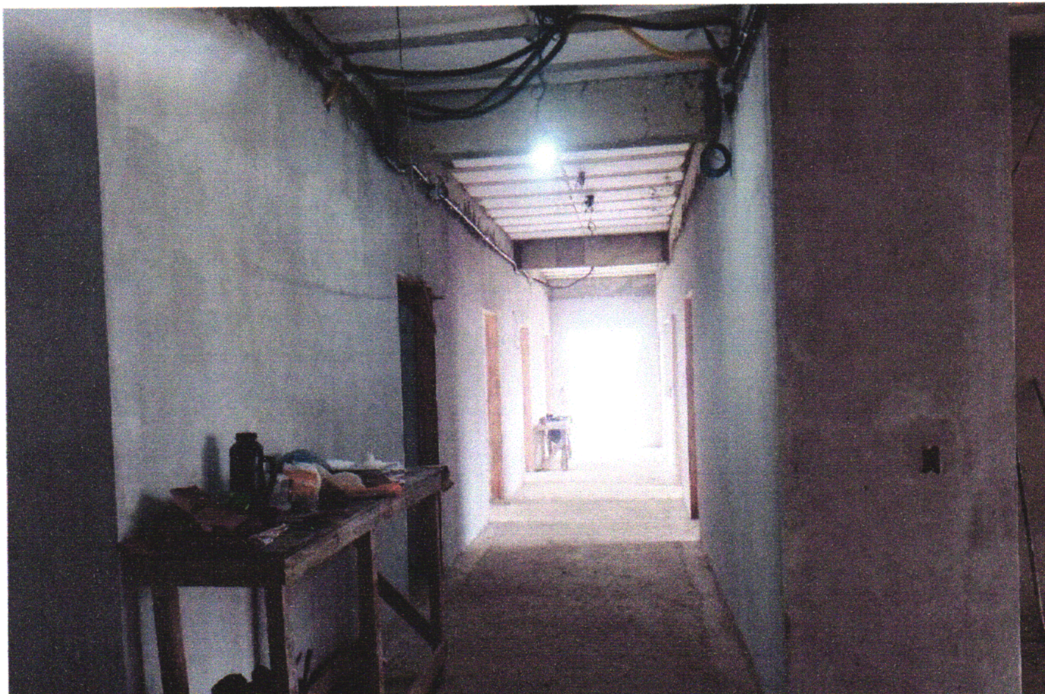
FOTO 02 (APLICAÇÃO DE SELADOR EM PAREDES INTERNAS)
