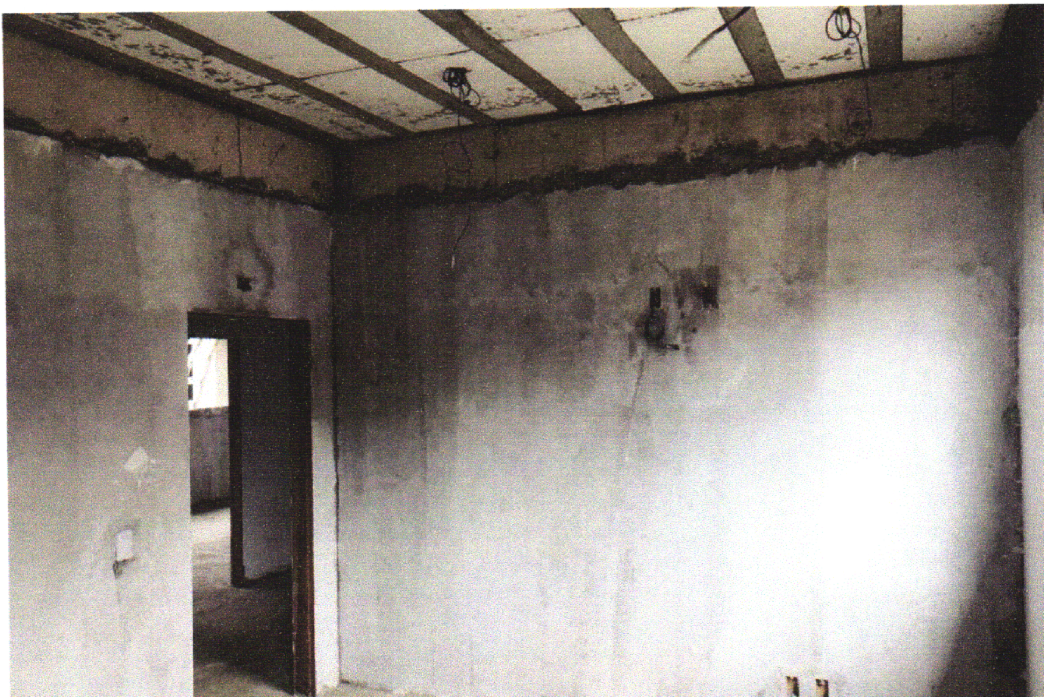
FOTO 04 (APLICAÇÃO DE SELADOR EM PAREDES INTERNAS)
