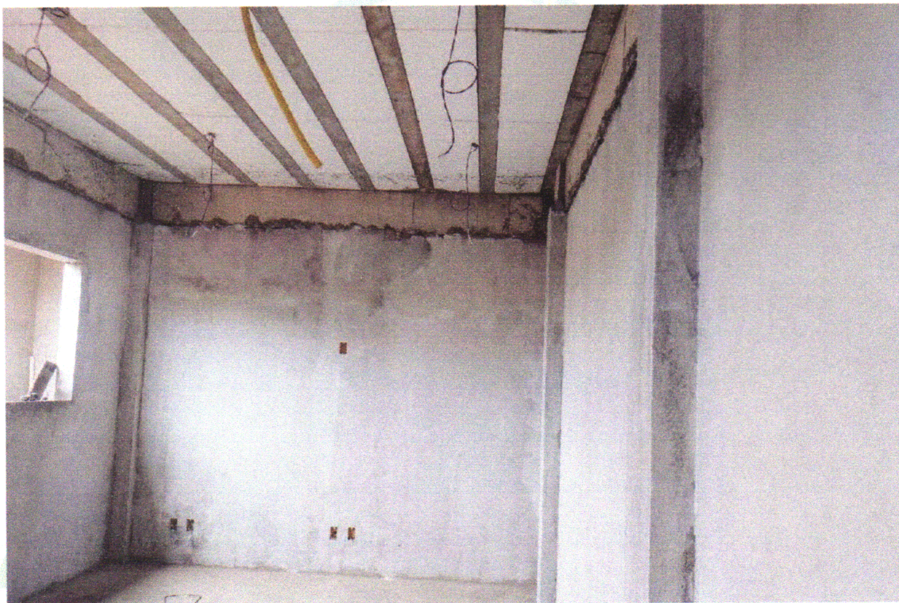
FOTO 01 (APLICAÇÃO DE SELADOR EM PAREDES INTERNAS)
