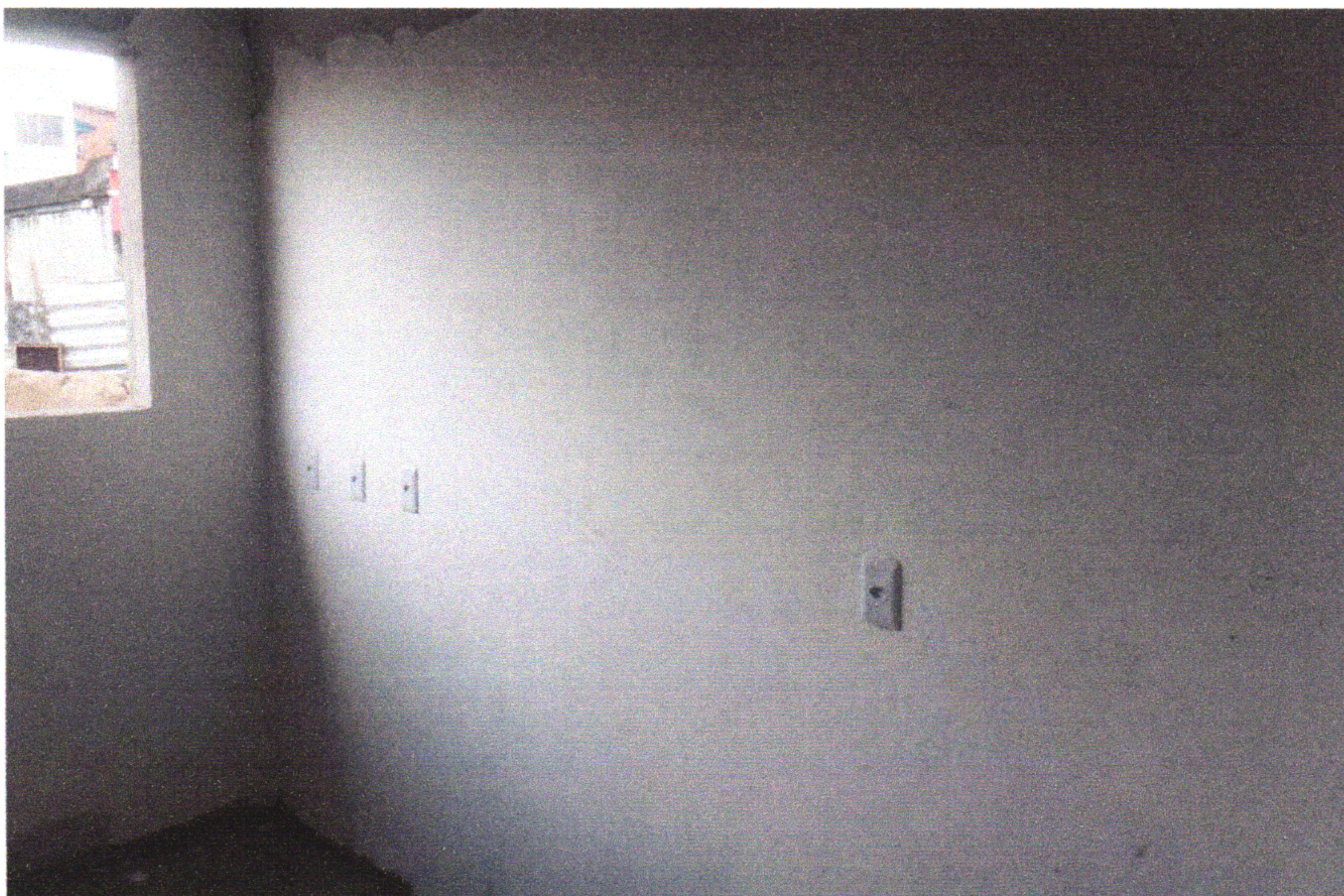
FOTO 24 (EMASSAMENTO DE PAREDES INTERNAS)
