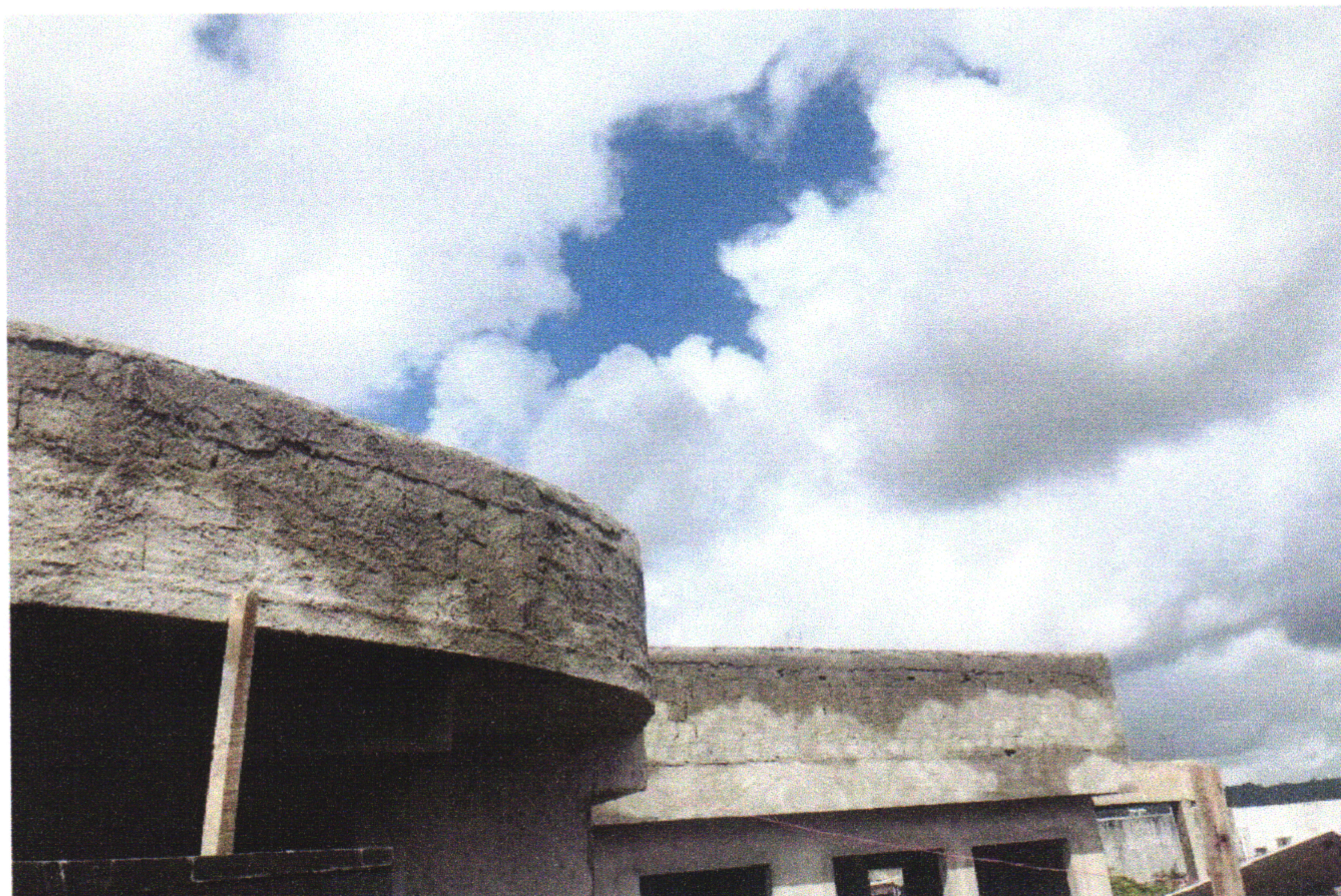
FOTO 10 (EXECUÇÃO DE CHAPISCO DA PLATIBANDA)
