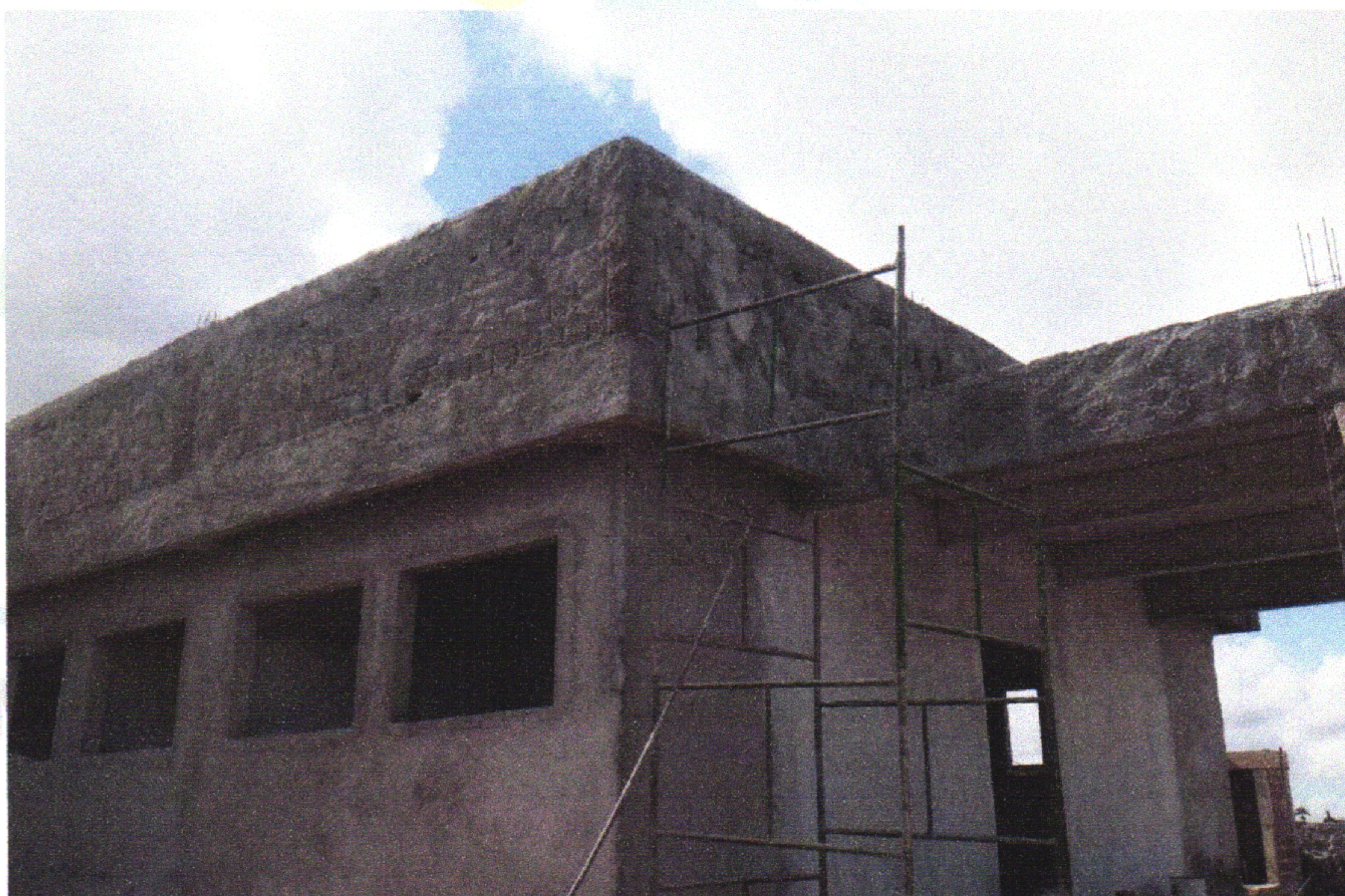
FOTO 19 (EXECUÇÃO DE CHAPISCO DA PLATIBANDA)
