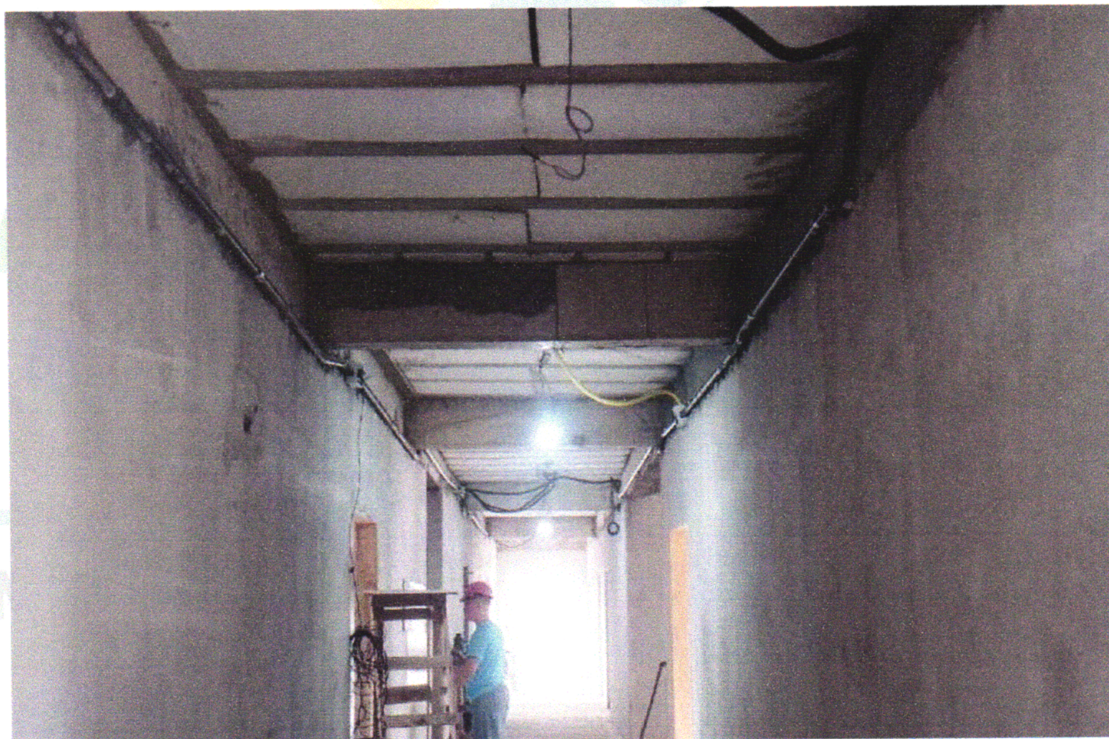
FOTO 05 (APLICAÇÃO DE SELADOR EM PAREDES INTERNAS)
