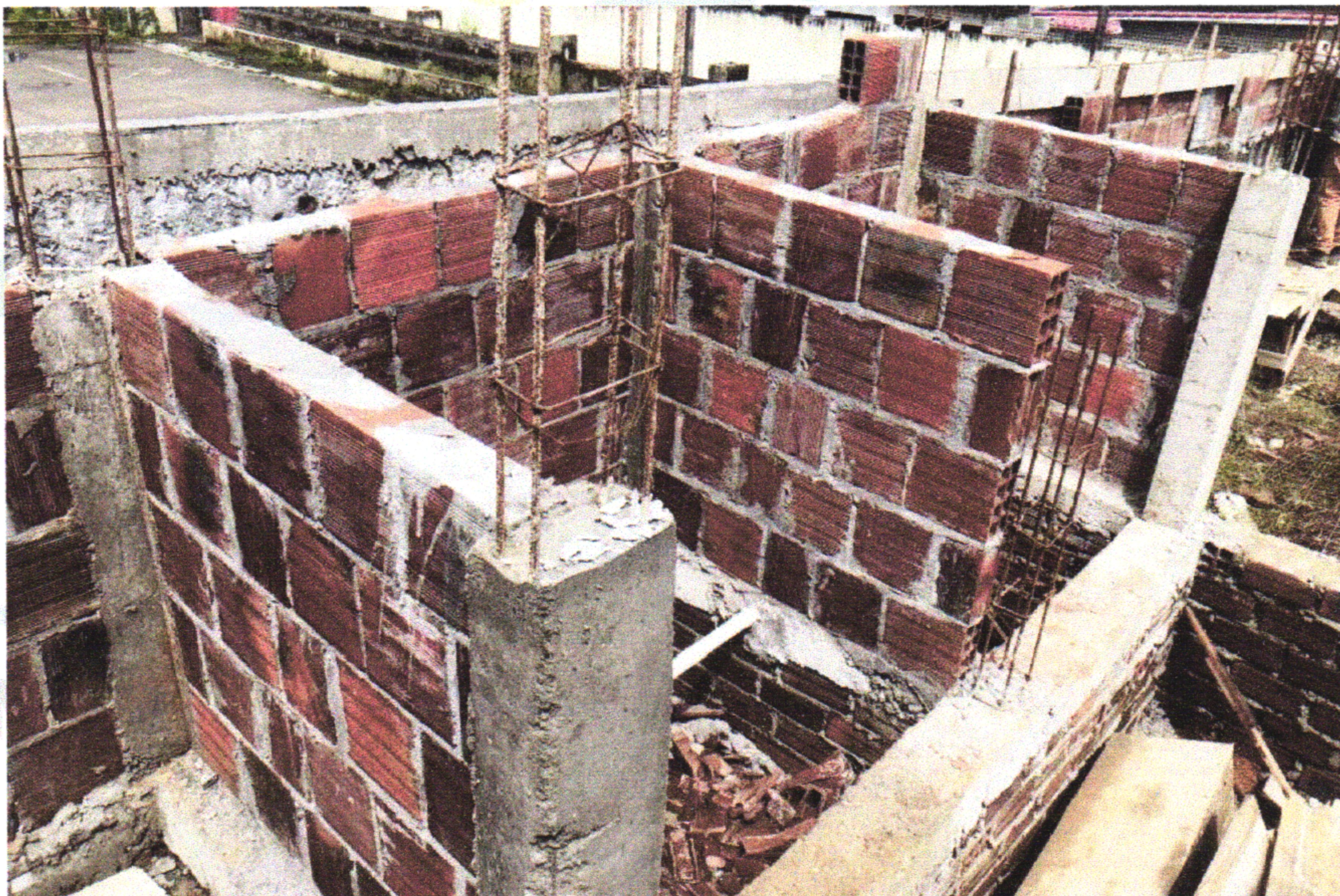
FOTO 13 (EXECUÇÃO DO ABRIDO DE RESÍDUOS - VIGA BALDRAME, PILARES, ALVENARIA DE VEDAÇÃO)
