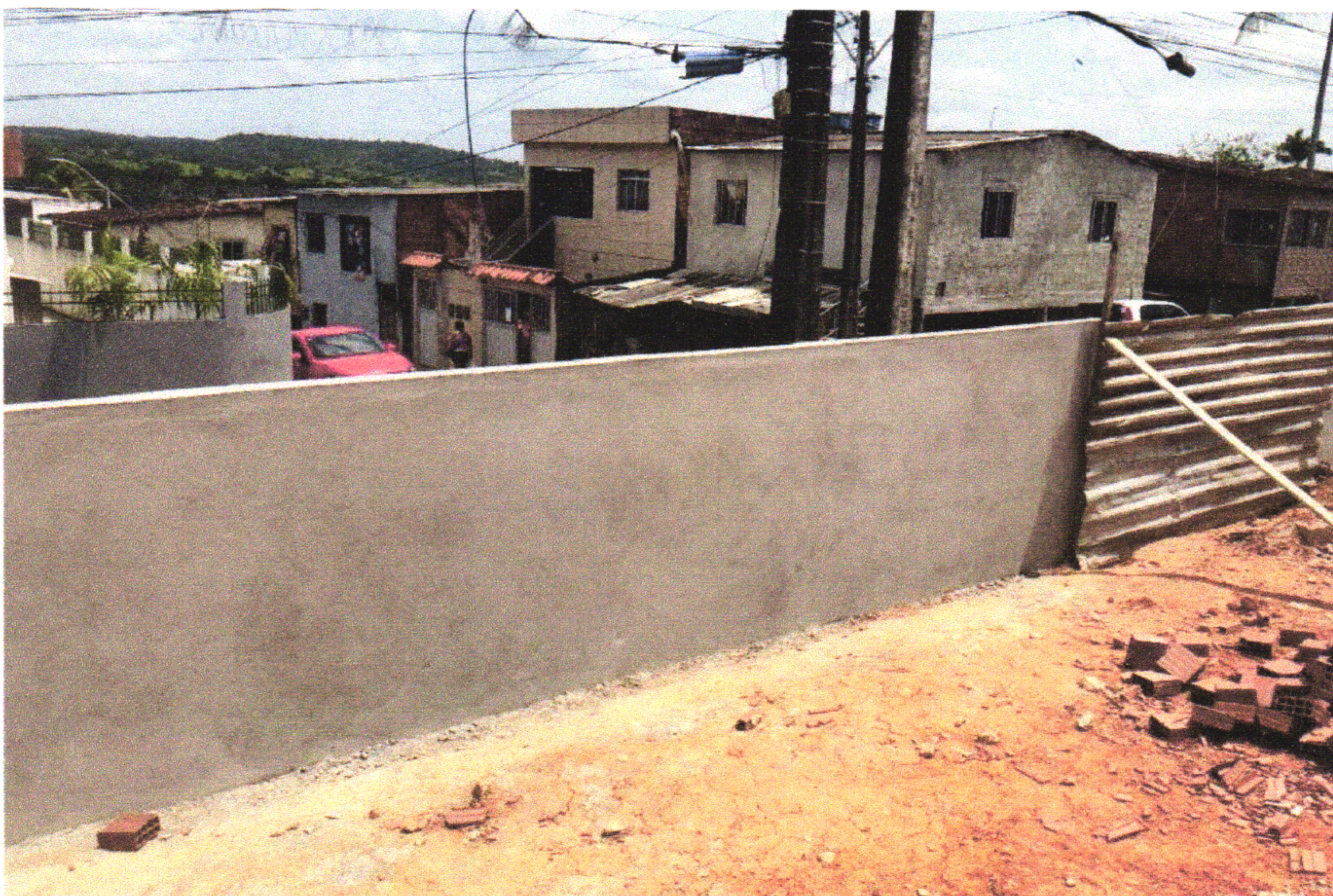
FOTO 08 (EXECUÇÃO DE MASSA ÚNICA)
