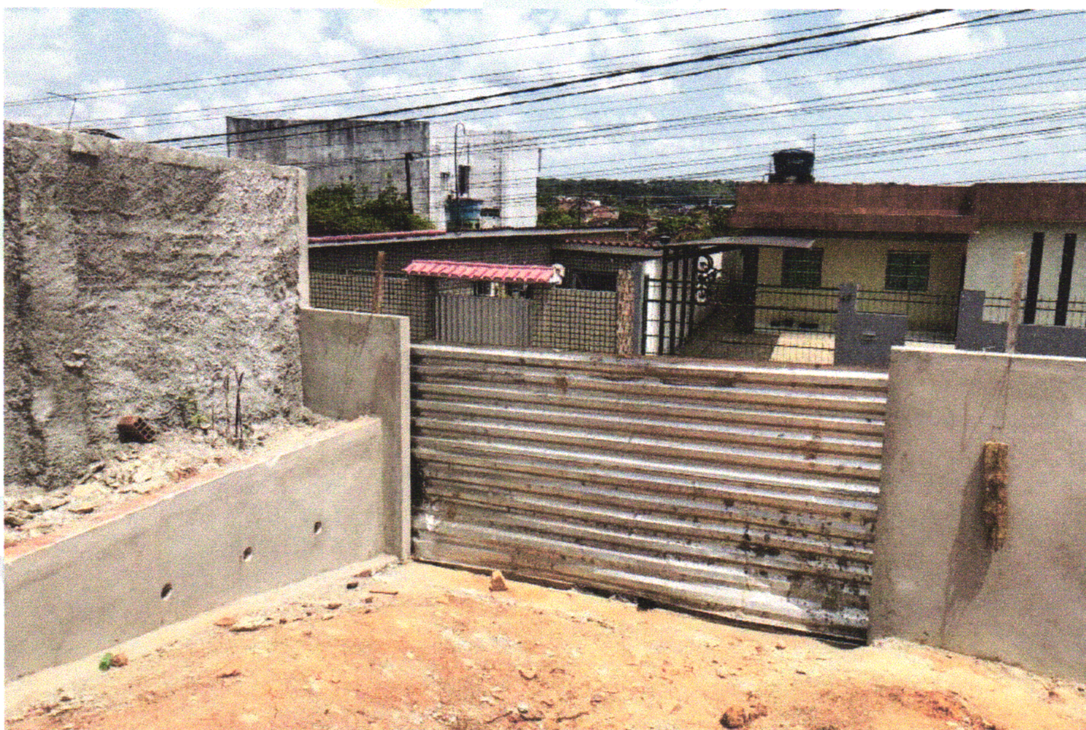
FOTO 09 (MURO ESTACIONAMENTO/CONTENÇÃO- EXECUÇÃO DE MASSA ÚNICA)
