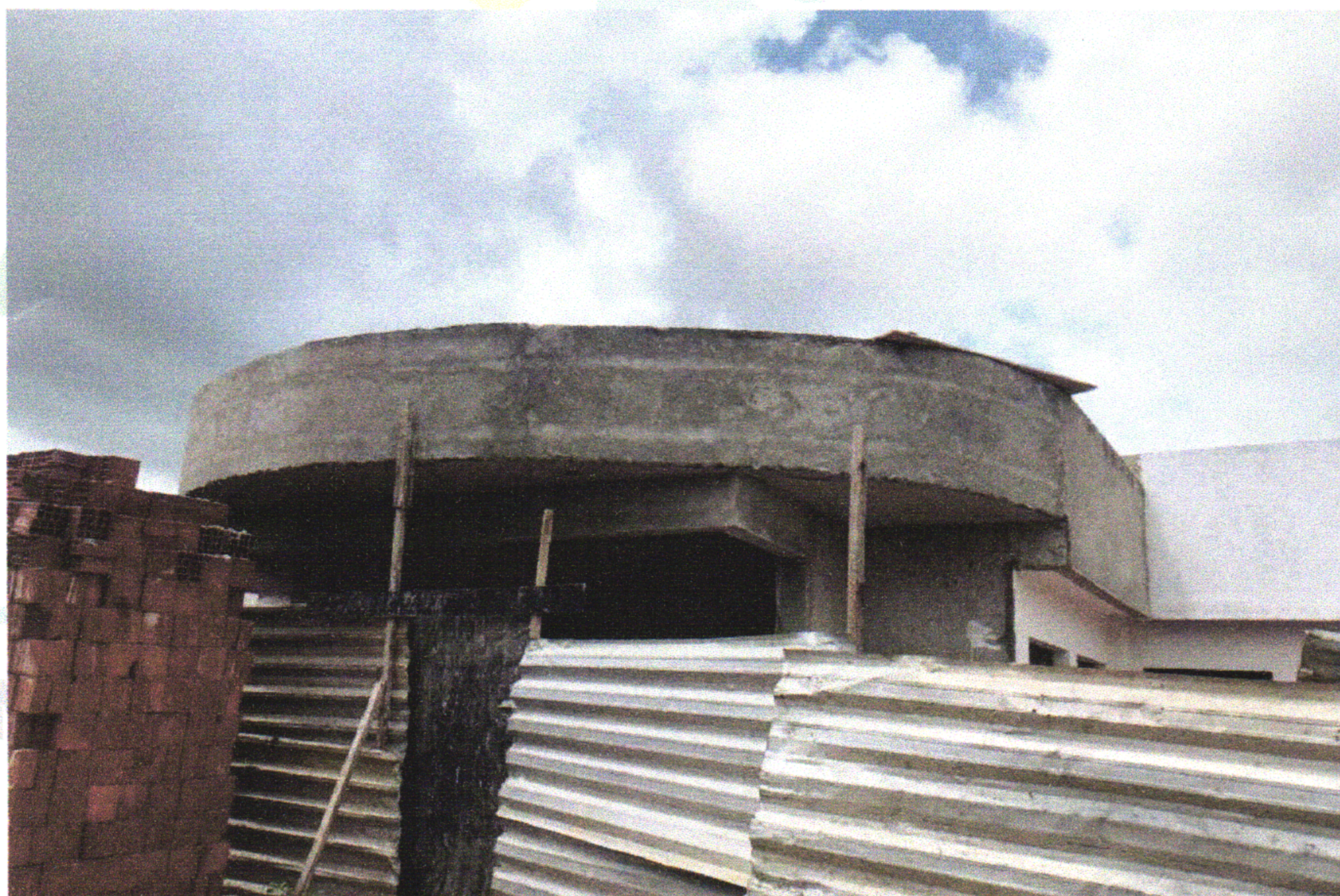
FOTO 19 (EMASSAMENTO DE PAREDES DA FACHADA E EMBOÇO PLATIBANDA E EM TETO)
