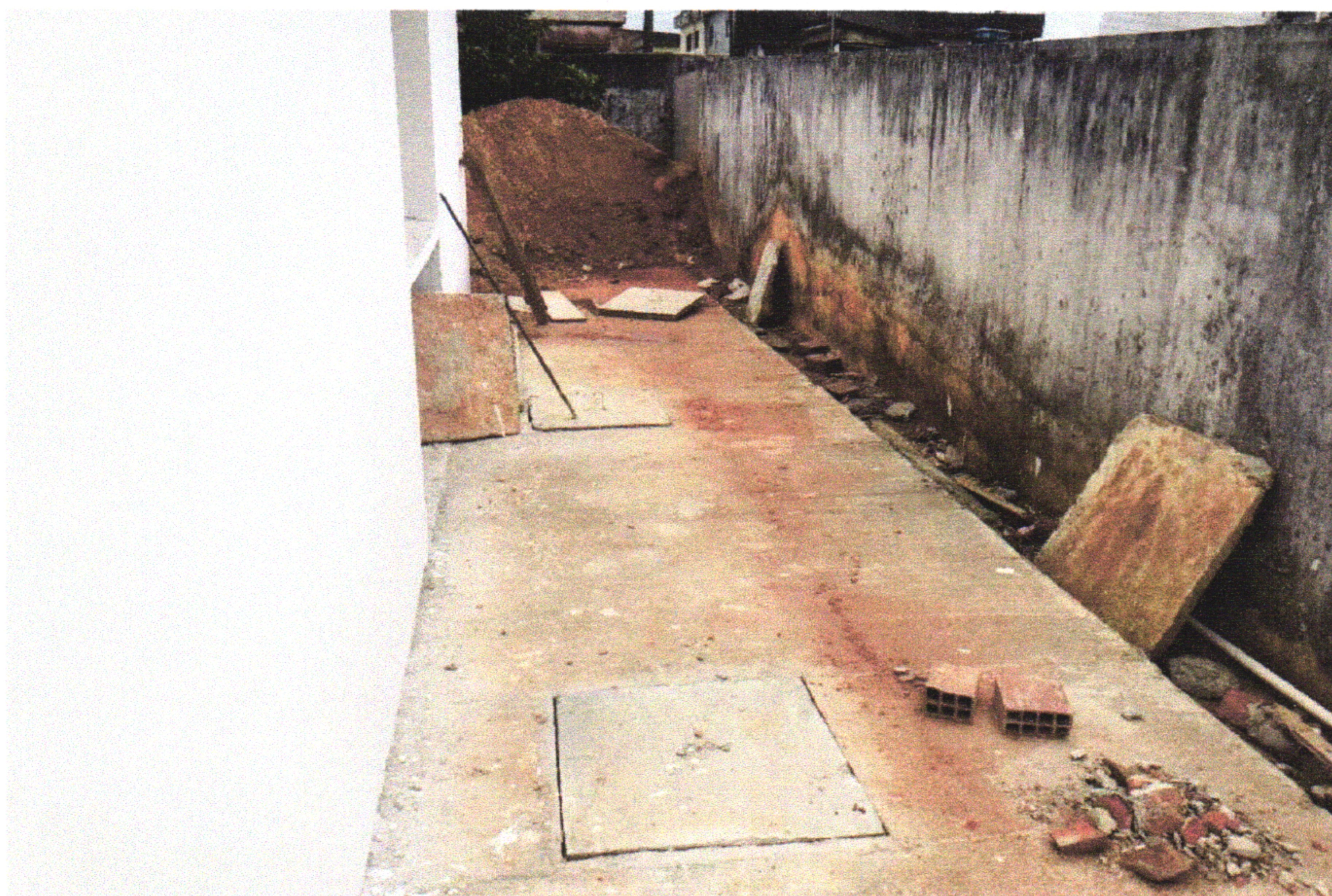
FOTO 02 (PASSEIO EM CONCRETO)
