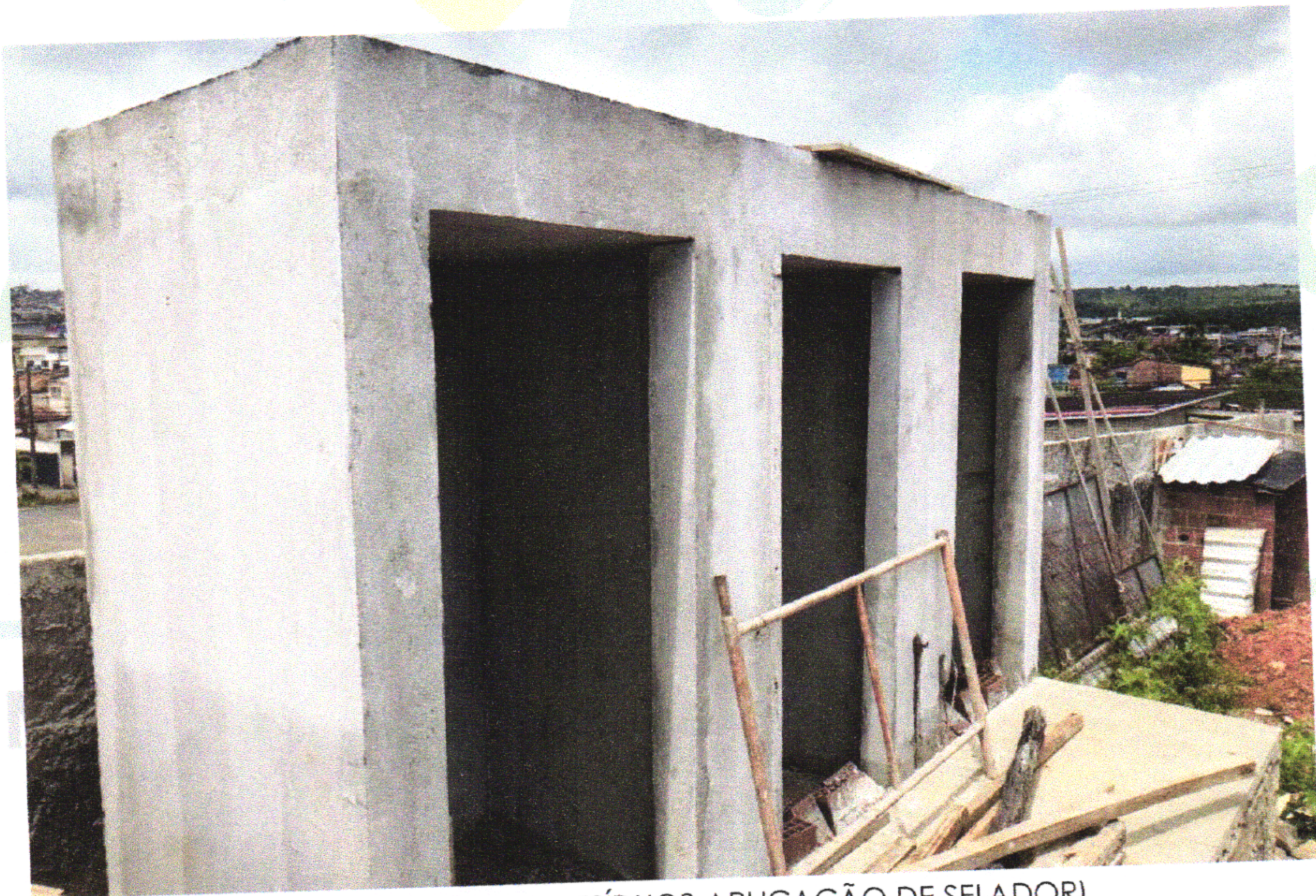
FOTO 10 (MURO ESTACIONAMENTO- EXECUÇÃO DE MASSA ÚNICA)
