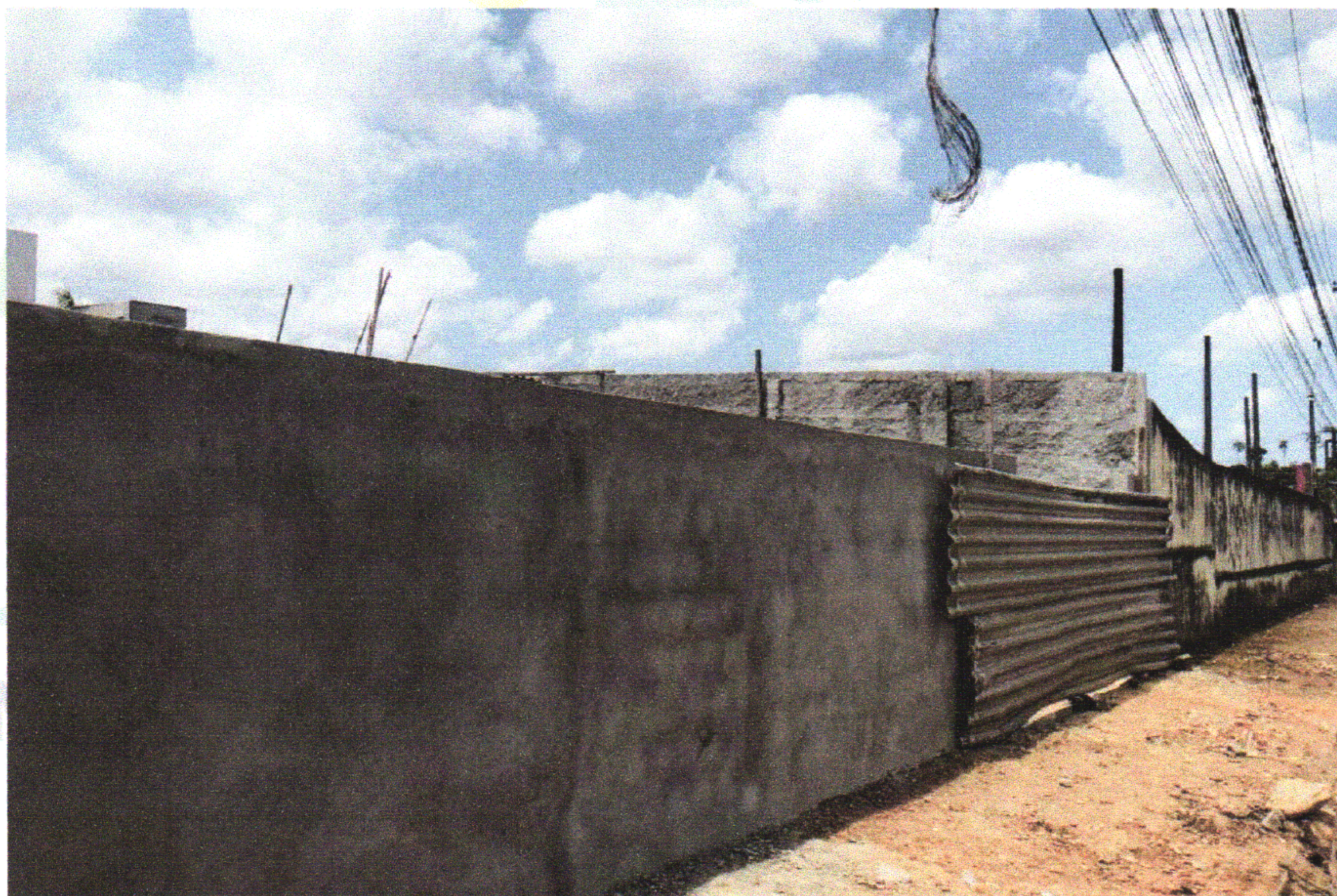
FOTO 07 (EXECUÇÃO DE MASA ÚNICA)
