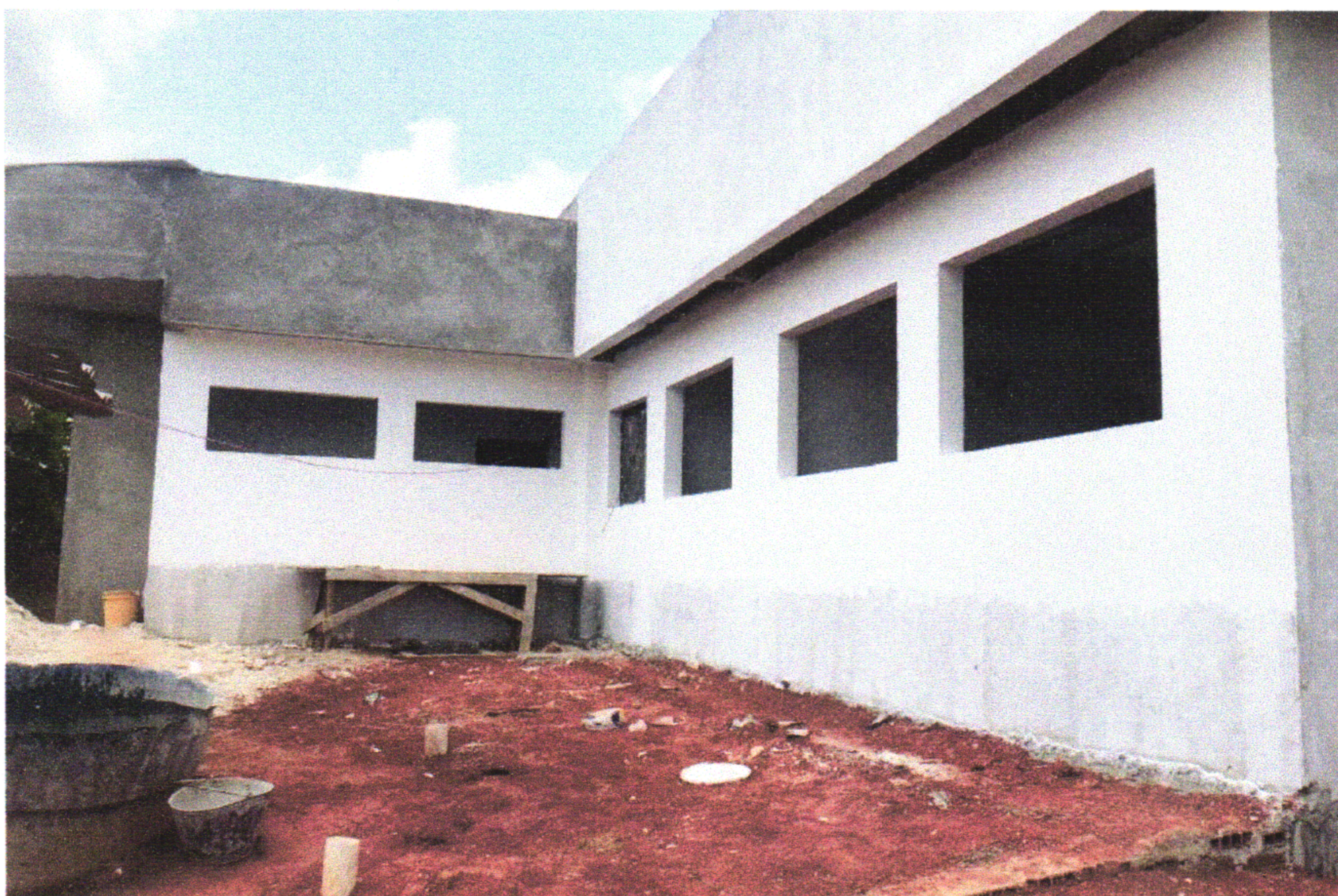
FOTO 16 (EMASSAMENTO DE PAREDES DA FACHADA E EMBOÇO PLATIBANDA)
