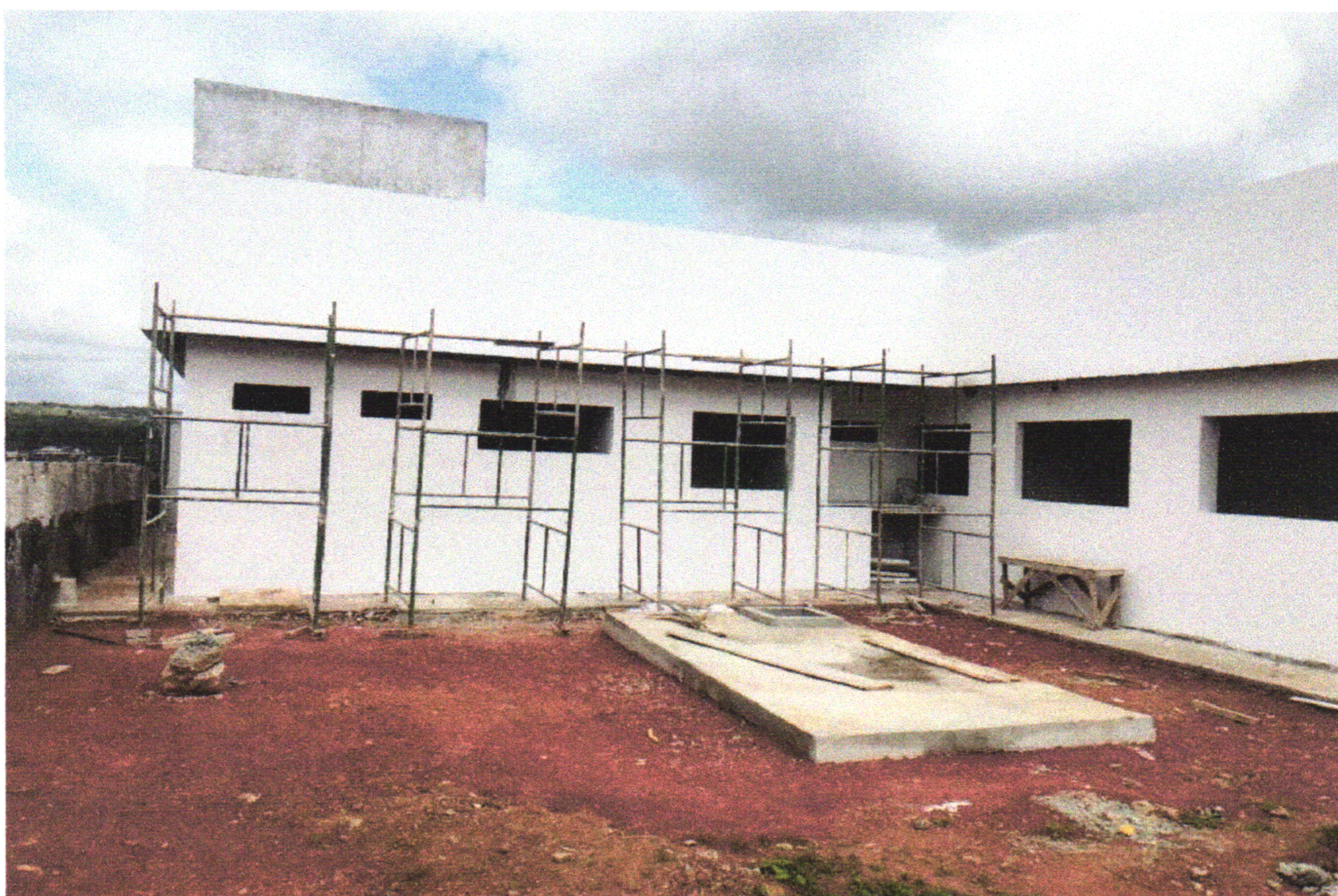
FOTO 18 (EMASSAMENTO DE PAREDES DA FACHADA)
