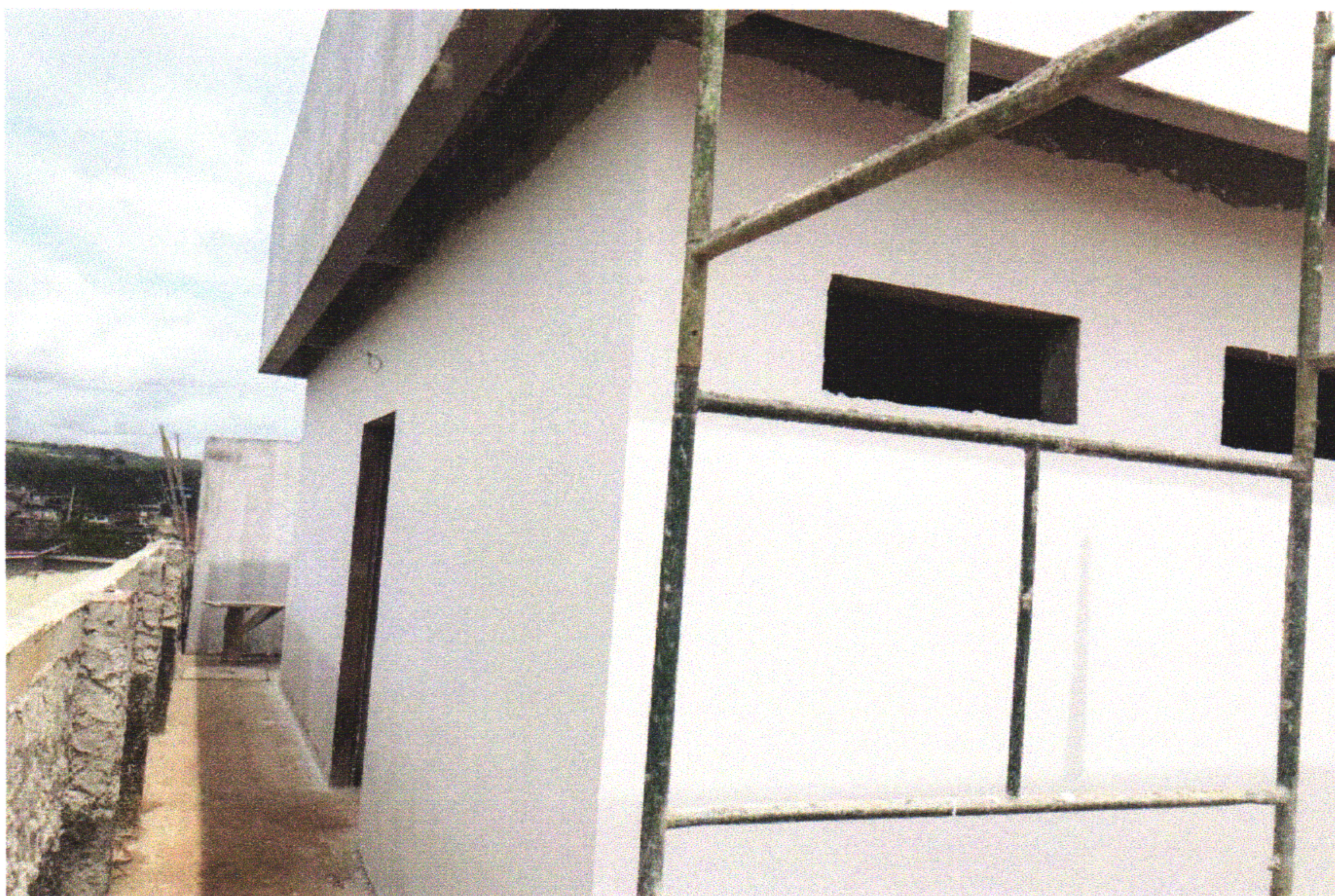
FOTO 14 (EMASSAMENTO DE PAREDES DA FACHADA)
