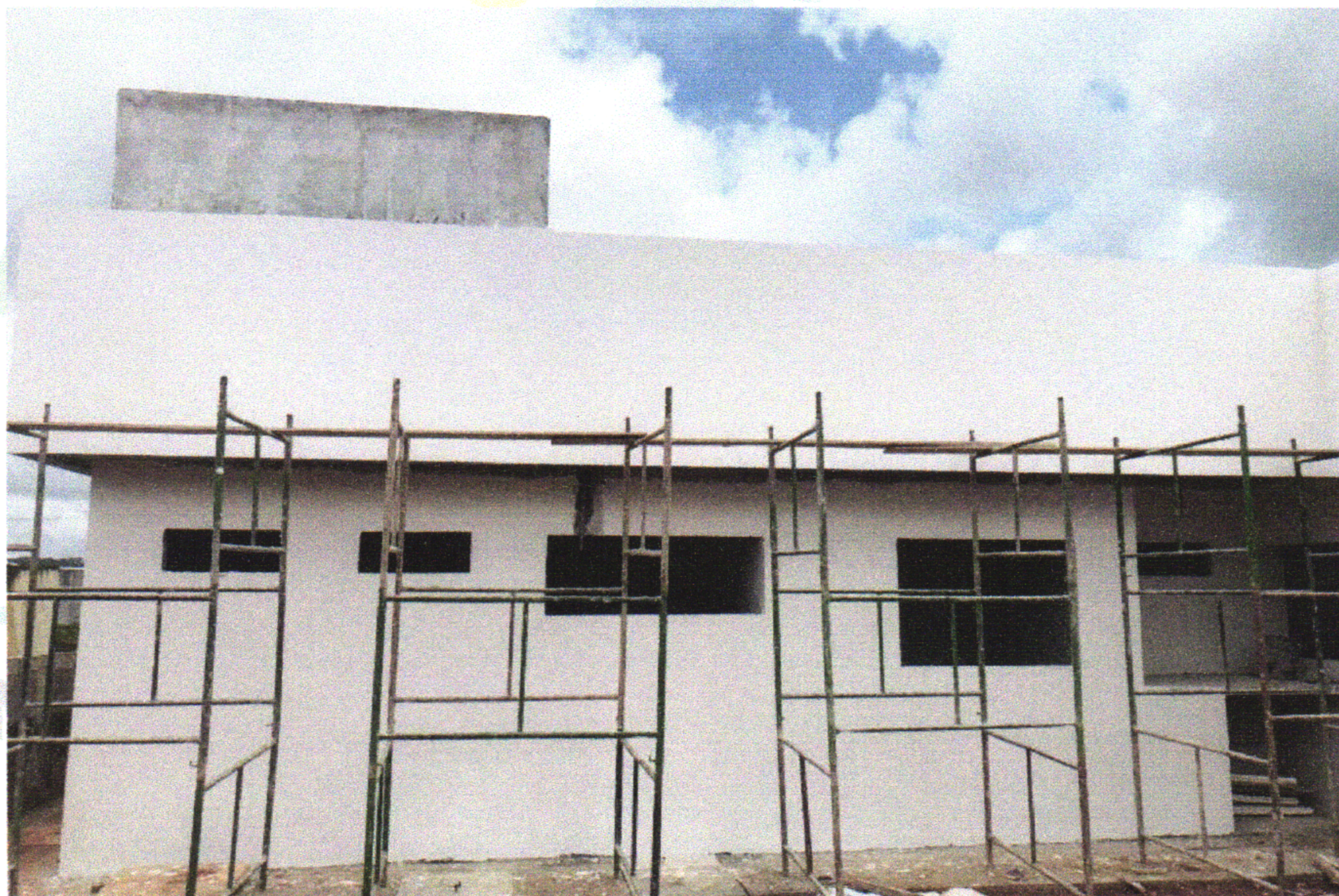
FOTO 13 (EMASSAMENTO DE PAREDES DA FACHADA)
