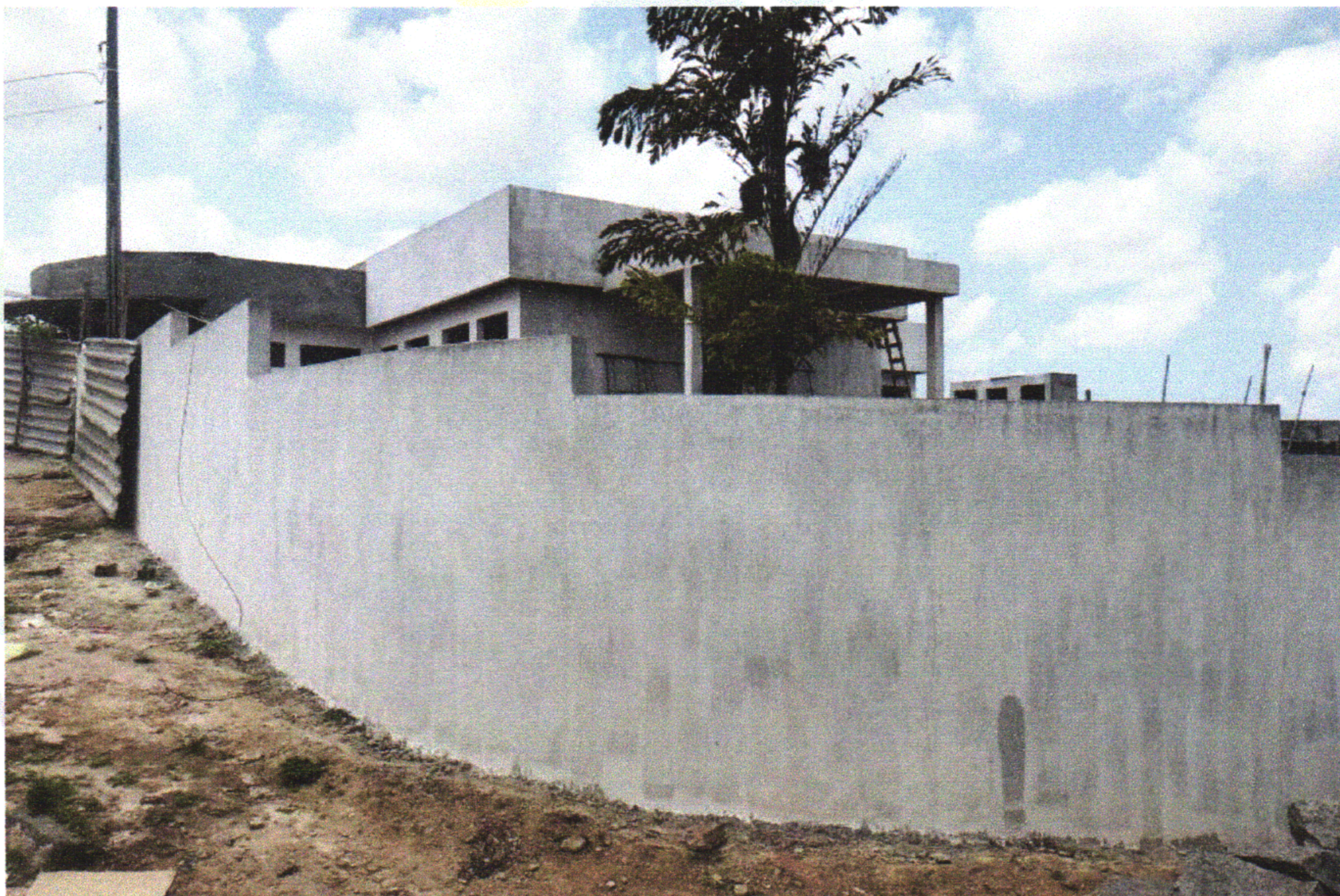
FOTO 05 (APLICAÇÃO DE SELADOR)
