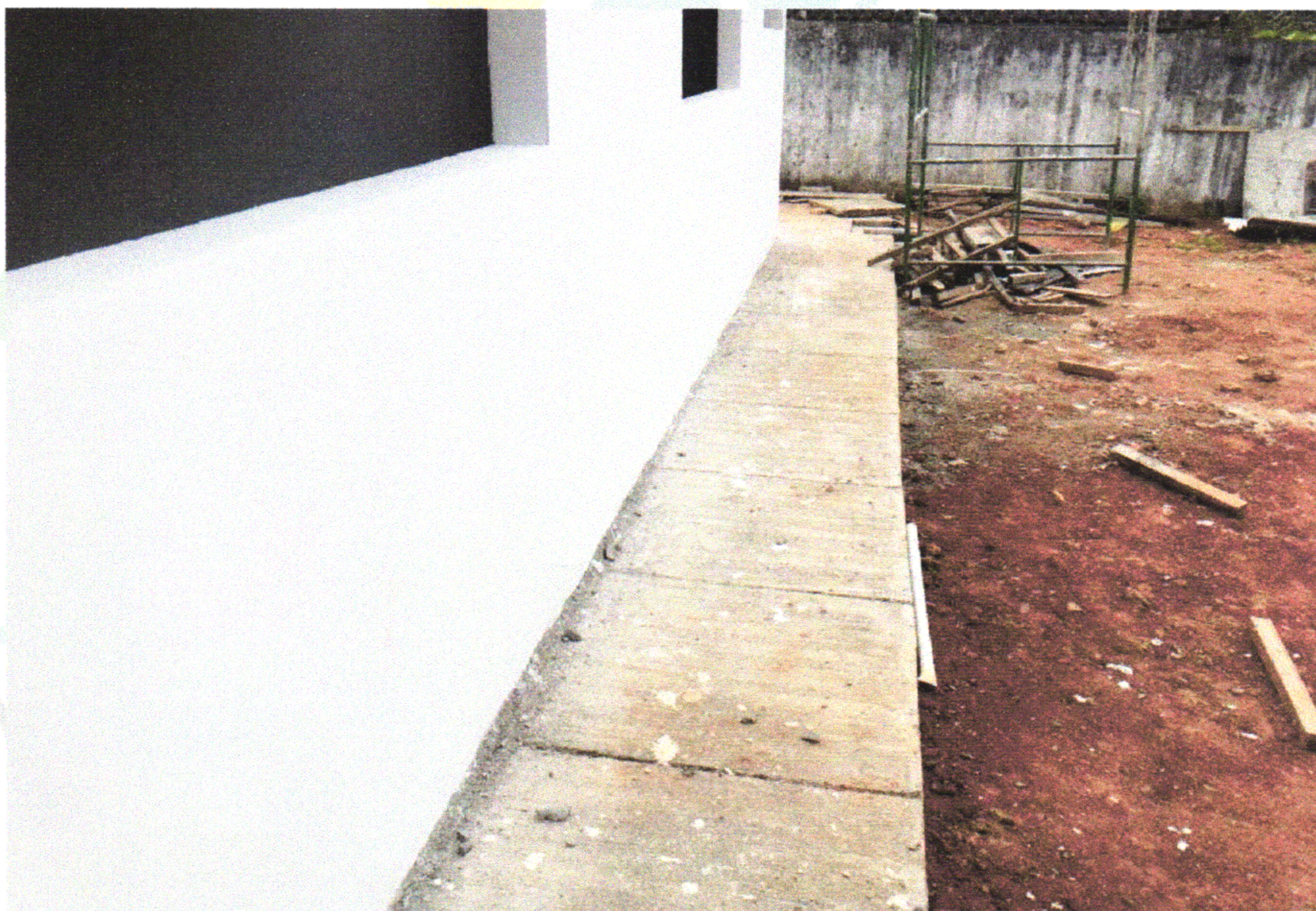
FOTO 03 (PASSEIO EM CONCRETO)
