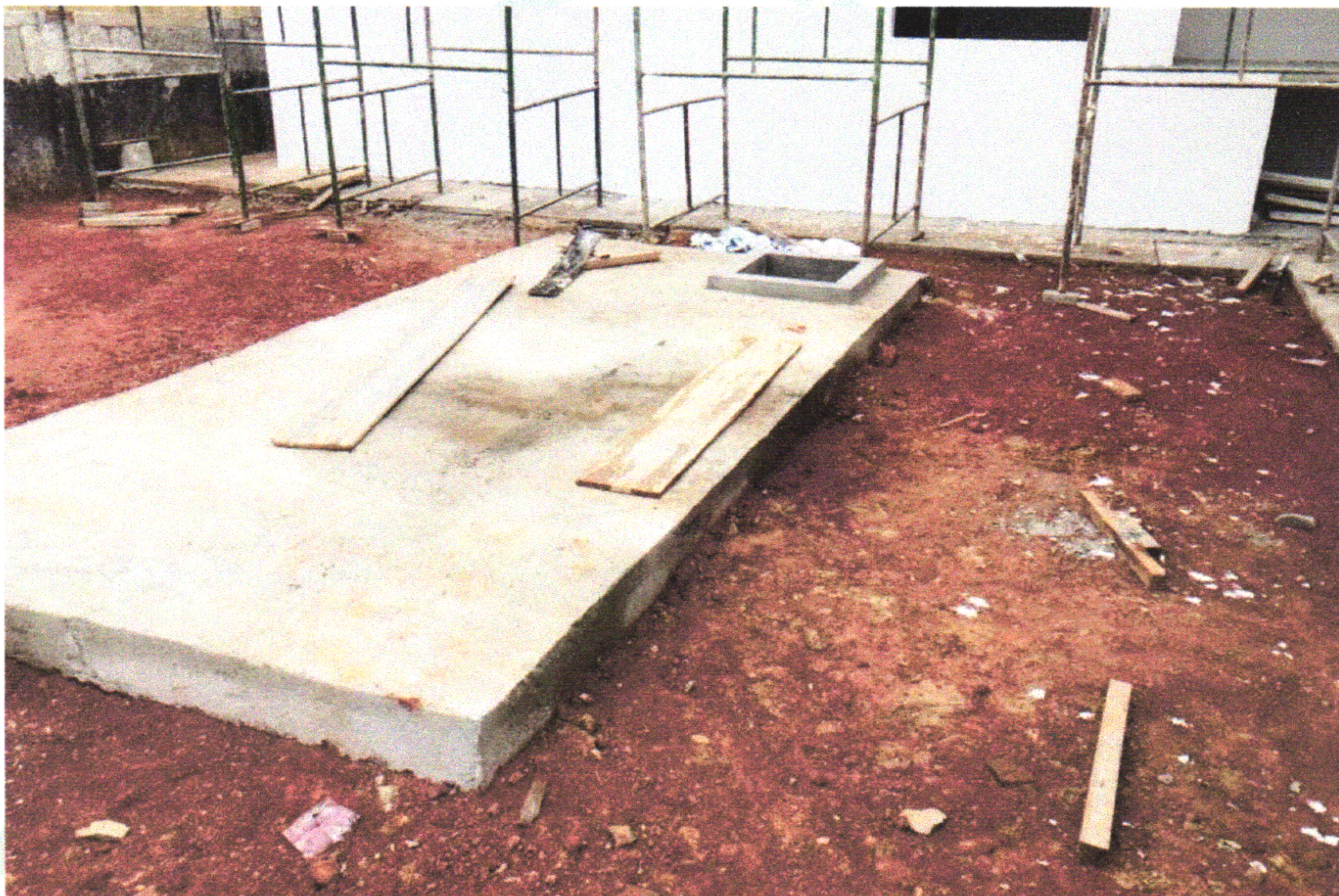
FOTO 01 (LAJE RESERVATÓRIO INFERIOR)
