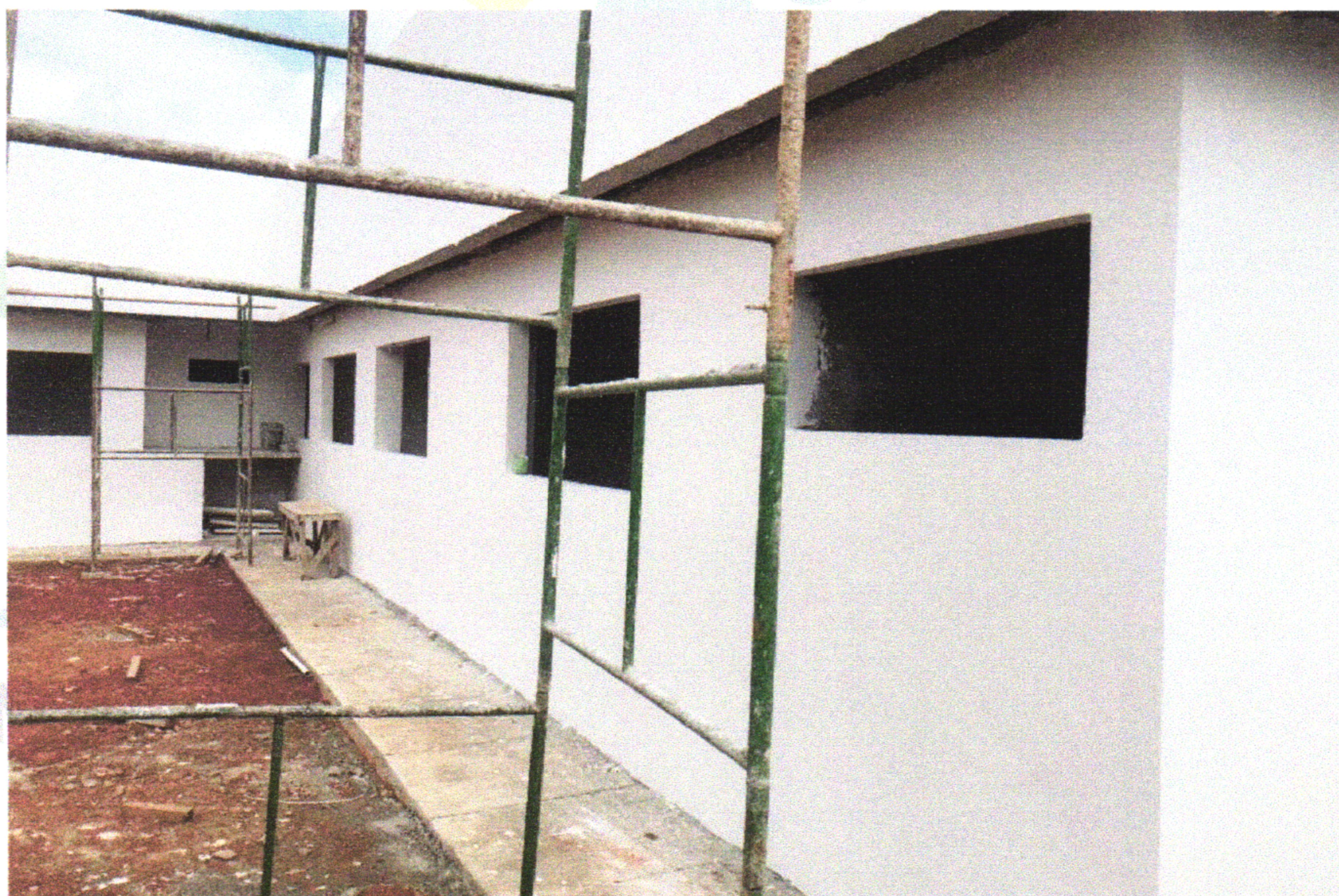
FOTO 15 (EMASSAMENTO DE PAREDES DA FACHADA)
