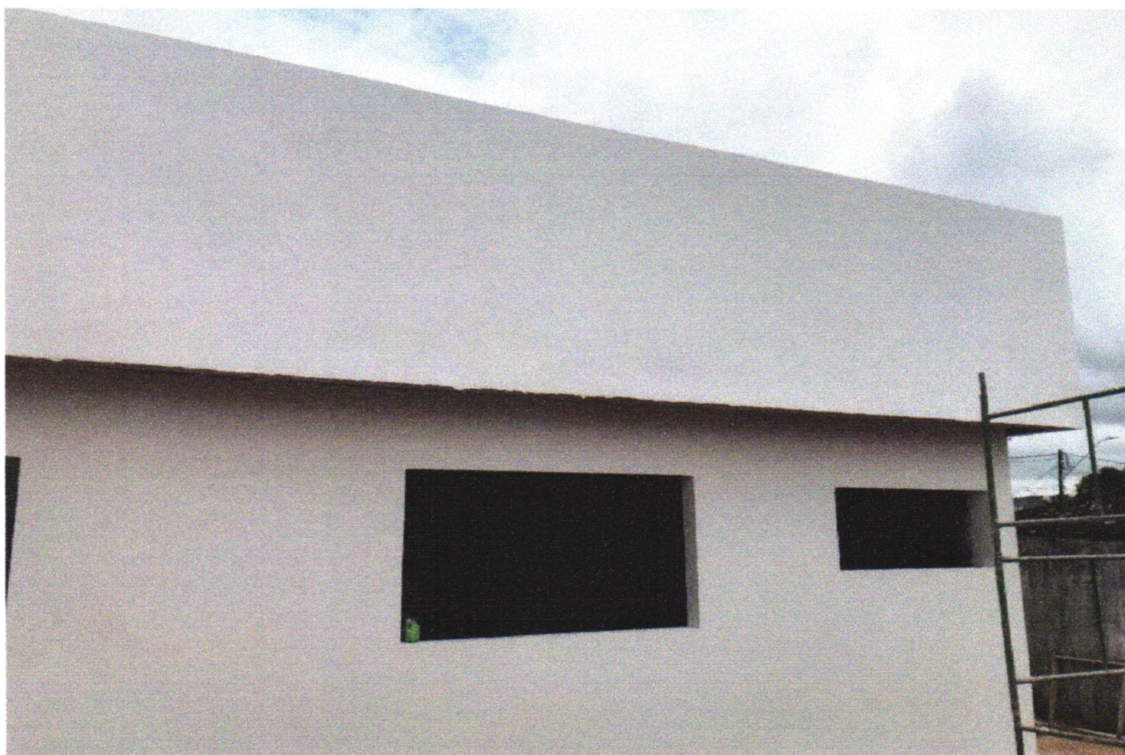
FOTO 12 (EMASSAMENTO DE PAREDES DA FACHADA)
