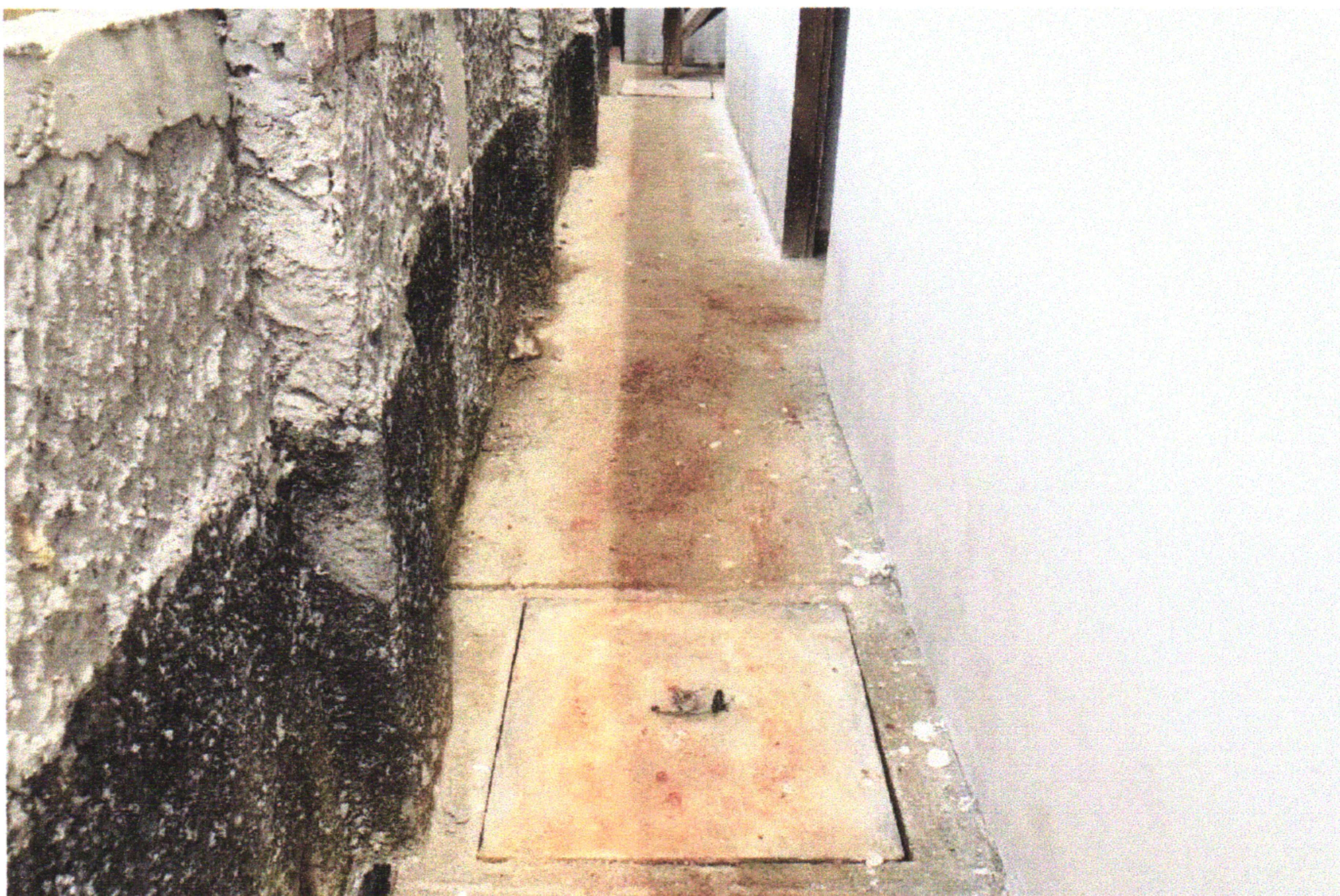
FOTO 04 (PASSEIO EM CONCRETO)
