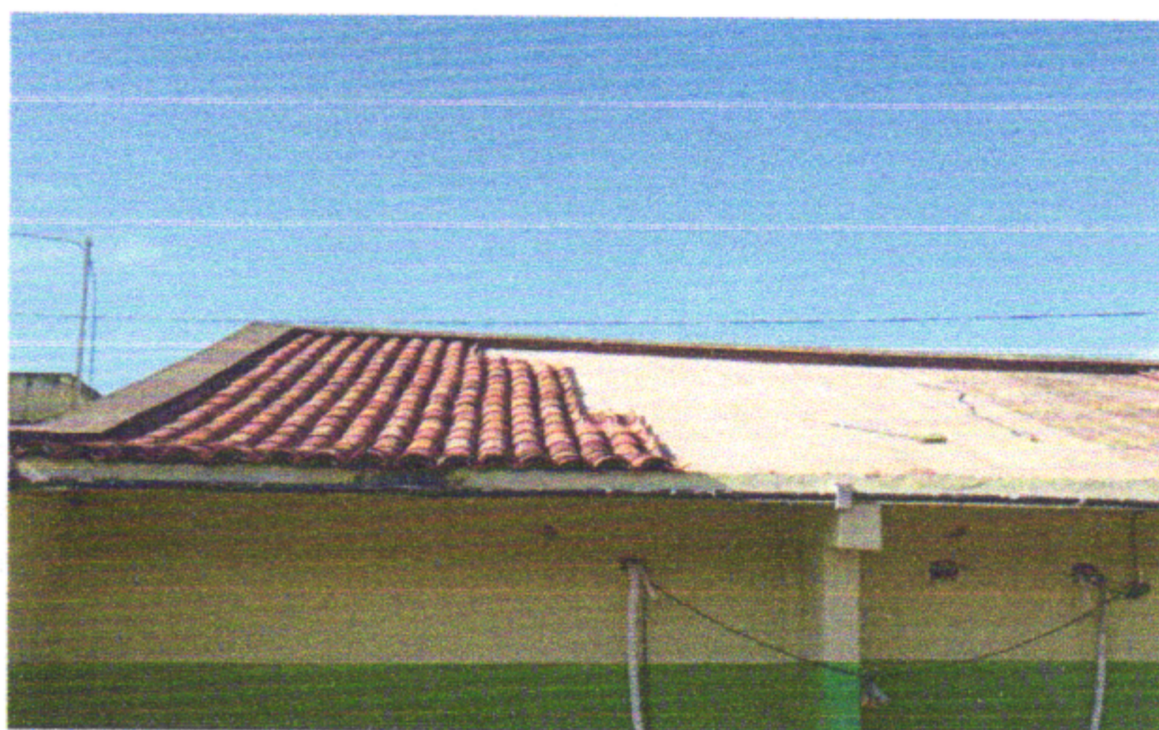
RETELHAMENTO COM TELHA CANAL
