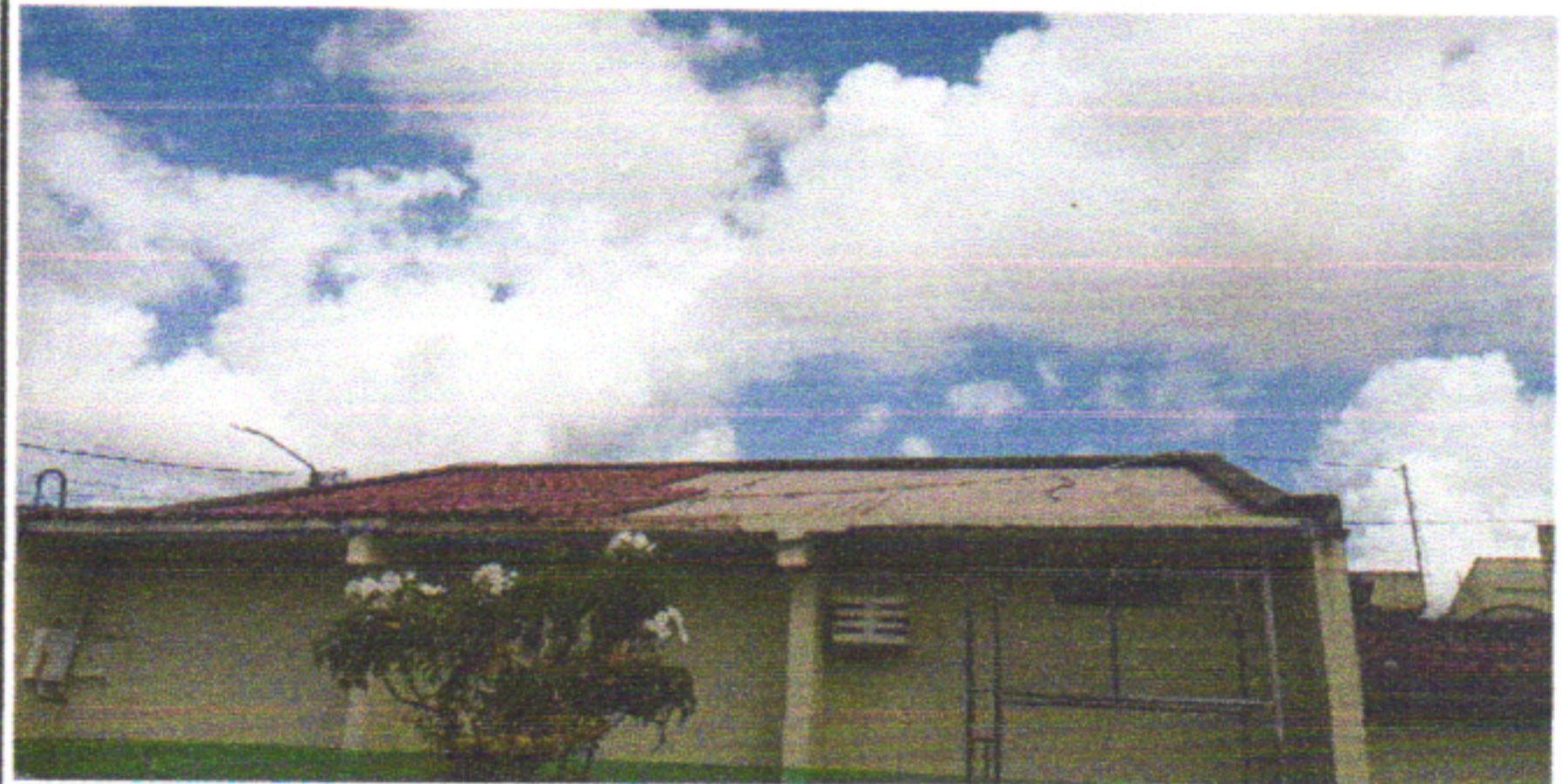
TELHAMENTO E RETELHAMENTO COM TELHA CANAL COM UTILIZAÇÃO DE ANDAIME
