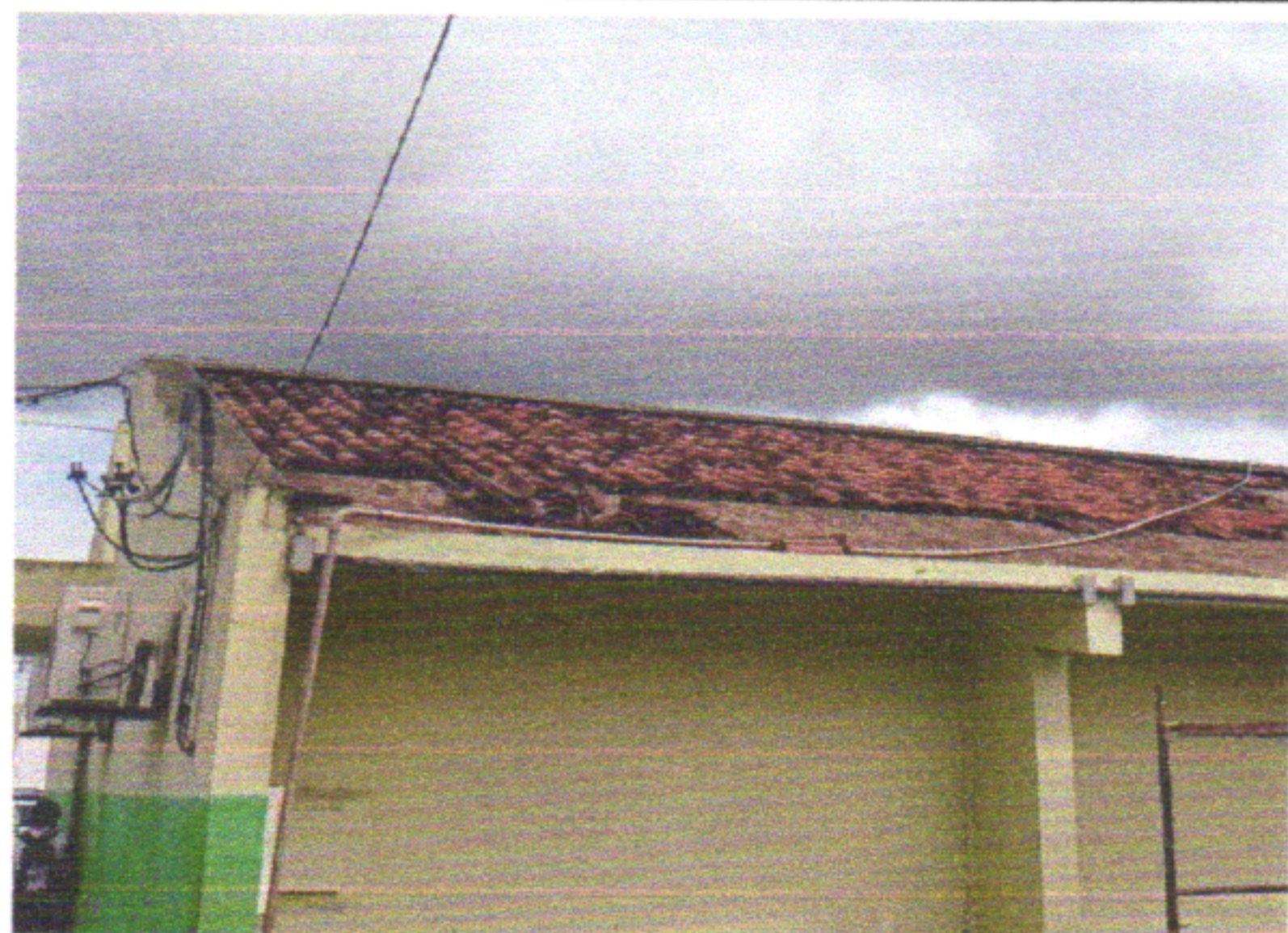
RETELHAMENTO COM TELHA CANAL
