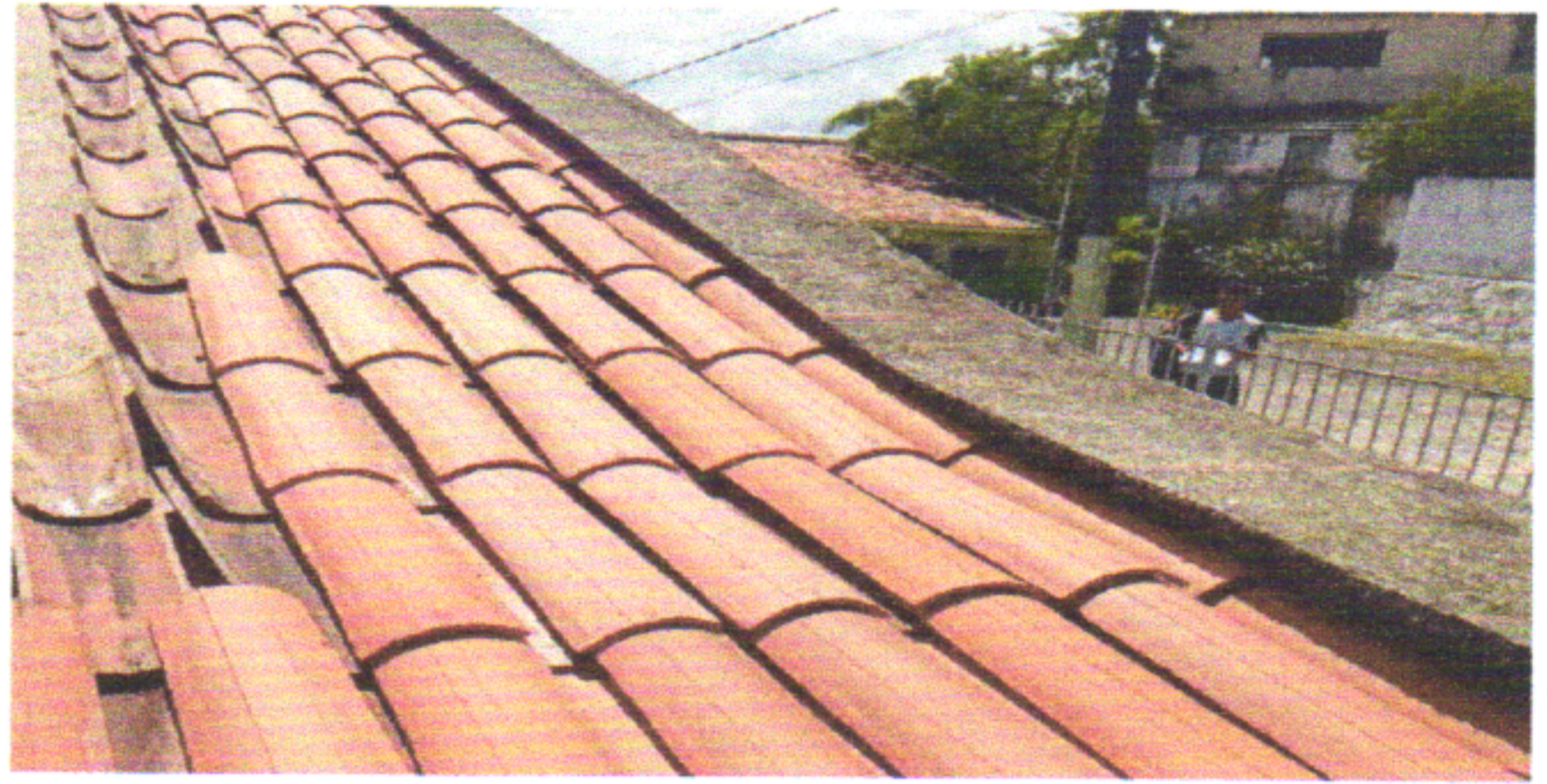
TELHAMENTO COM TELHA CANAL
