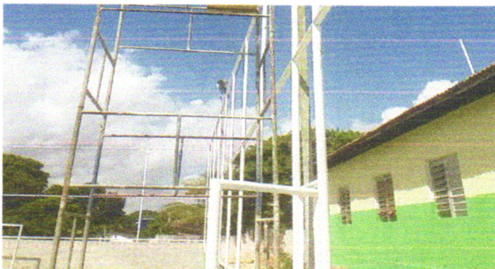
UTILIZAÇÃO DE ANDAIME PARA REMOÇÃO DO REFLETOR, PARA A COLOCAÇÃO DO ALAMBRADO, PARA A PINTURA DO ALAMBRADO E PARA COLOCAÇÃO DAS TELAS
