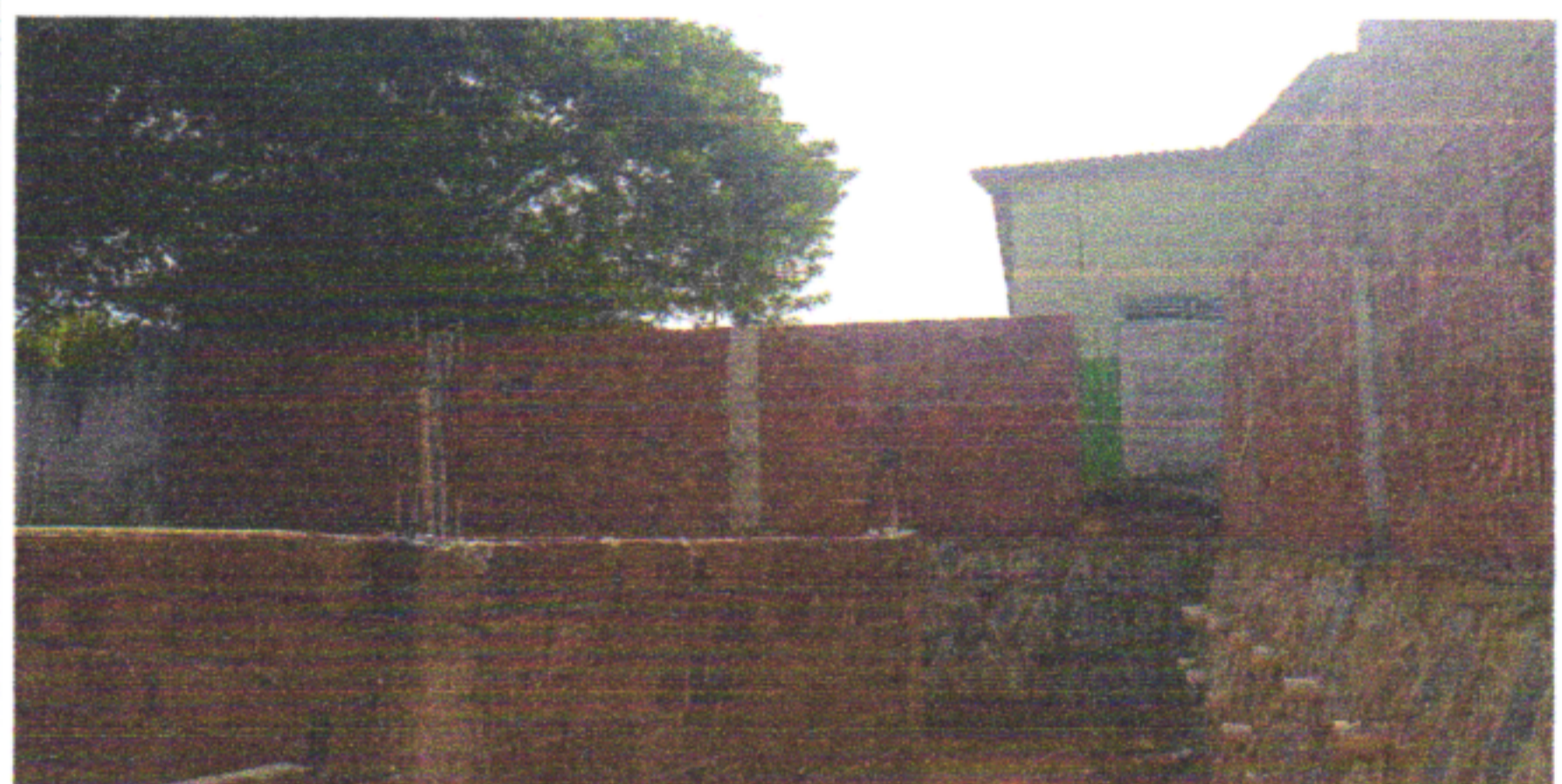
ELEVAÇÃO DO MURO COM BLOCO CERÂMICO E CONCRETAGEM DOS PILARES COM UTILIZAÇÃO DE FORMA
