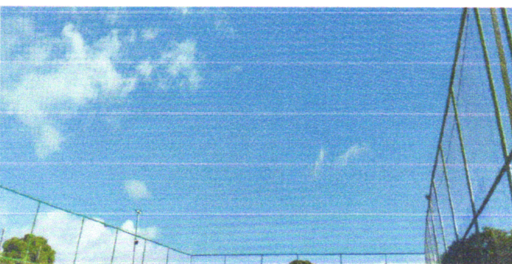
COLOCAÇÃO DA TELA EM NYLON E FIXAÇÃO COM CABOS DE AÇO NA PARTE SUPERIOR NA QUADRA
