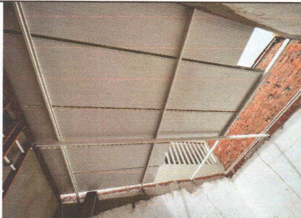
EXECUÇÃO DOS SERVIÇOS DE ESTRUTURA METÁLICA E TELHA METÁLICA TERMOACÚSTICA
