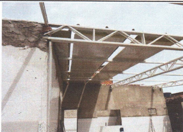
EXECUÇÃO DOS SERVIÇOS DE ESTRUTURA METÁLICA E TELHA METÁLICA TERMOACÚSTICA
