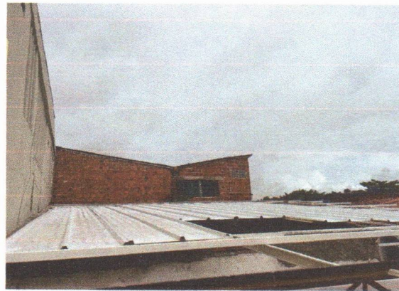
EXECUÇÃO DOS SERVIÇOS DE ESTRUTURA METÁLICA E TELHA METÁLICA TERMOACÚSTICA
