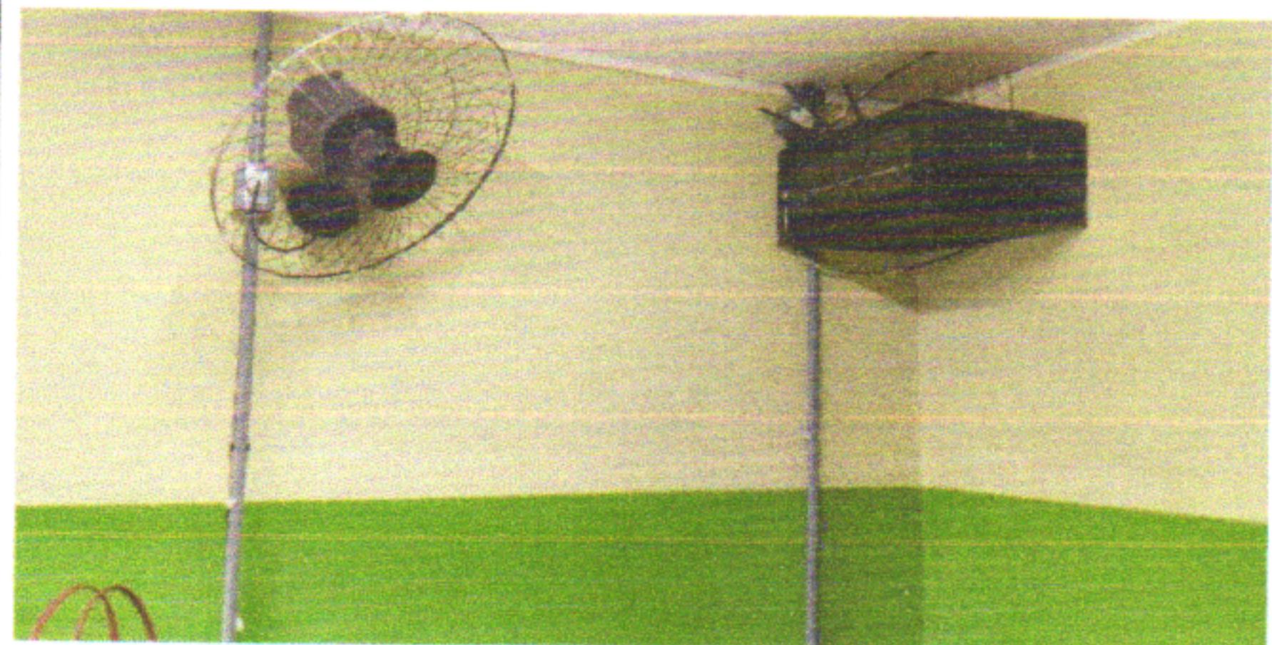
UTILIZAÇÃO DE CABO PP E PLUG MACHO PARA A INSTALAÇÃO DOS VENTILADORES
