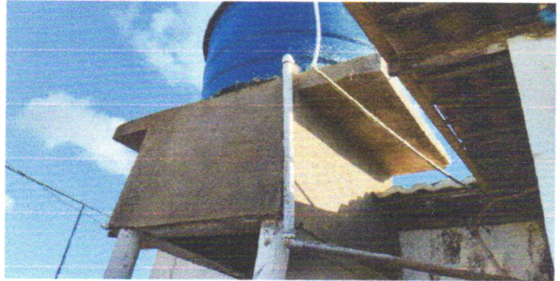
CHAPISCO E MASSA ÚNICA NA TORRE DA CAIXA D'ÁGUA
