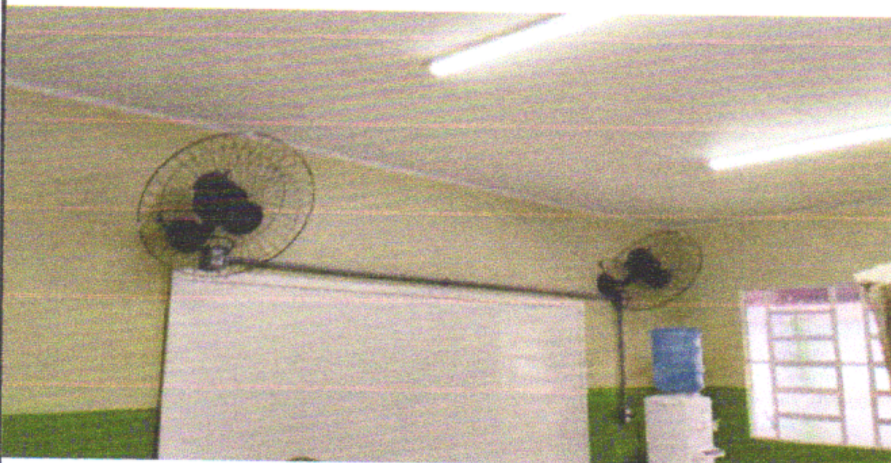
UTILIZAÇÃO DE CABO PP E PLUG MACHO PARA A INSTALAÇÃO DOS VENTILADORES
