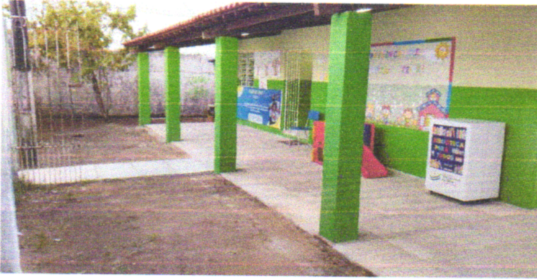
APLICAÇÃO DE LASTRO E LAJOTA NO PISO DA ENTRADA
