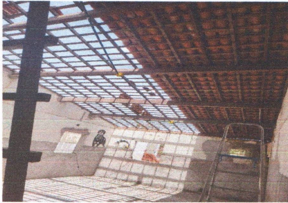
TELHAMENTO COM TELHA CERÂMICA
