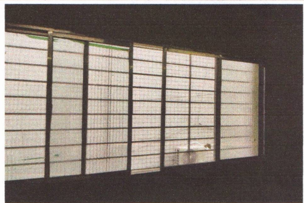
ANTES DA COLOCAÇÃO DOS VIDROS
