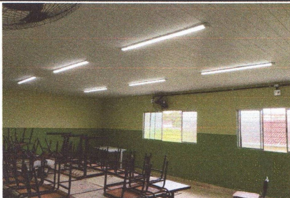
APLICAÇÃO DE PINTURA ACRÍLICA NAS PAREDES, INSTALAÇÃO DO FORRO PVC E DAS LUMINÁRIAS LED SLIM
