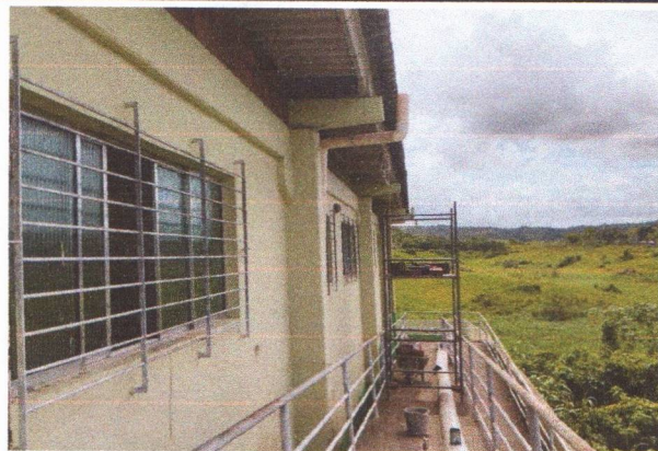
UTILIZAÇÃO DE ANDAIME PARA O FECHAMENTO COM ALVENARIA DE BLOCO CERÂMICO
