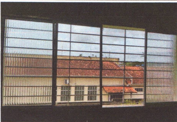
ANTES DA COLOCAÇÃO DOS VIDROS
