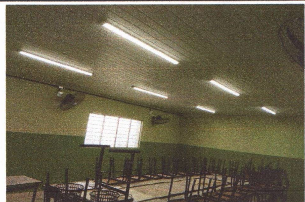
APLICAÇÃO DE PINTURA ACRÍLICA NAS PAREDES, INSTALAÇÃO DO FORRO PVC E DAS LUMINÁRIAS LED SLIM
