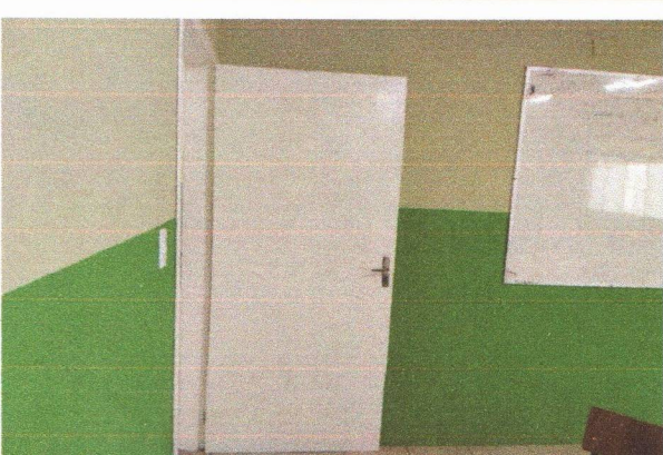
APLICAÇÃO DE PINTURA ACRÍLICA NAS PAREDES E DE PINTURA ESMALTE NAS PORTAS
