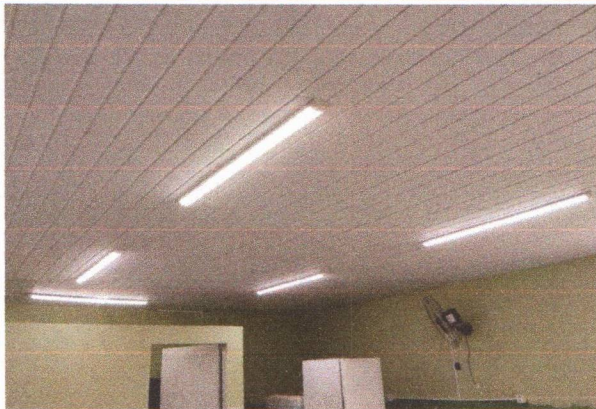
APLICAÇÃO DO FORRO PVC E DE LUMINÁRIAS LED SLIM
