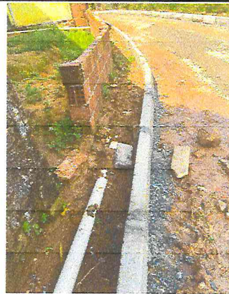
ASSENTAMENTO DE MEIO-FIO
