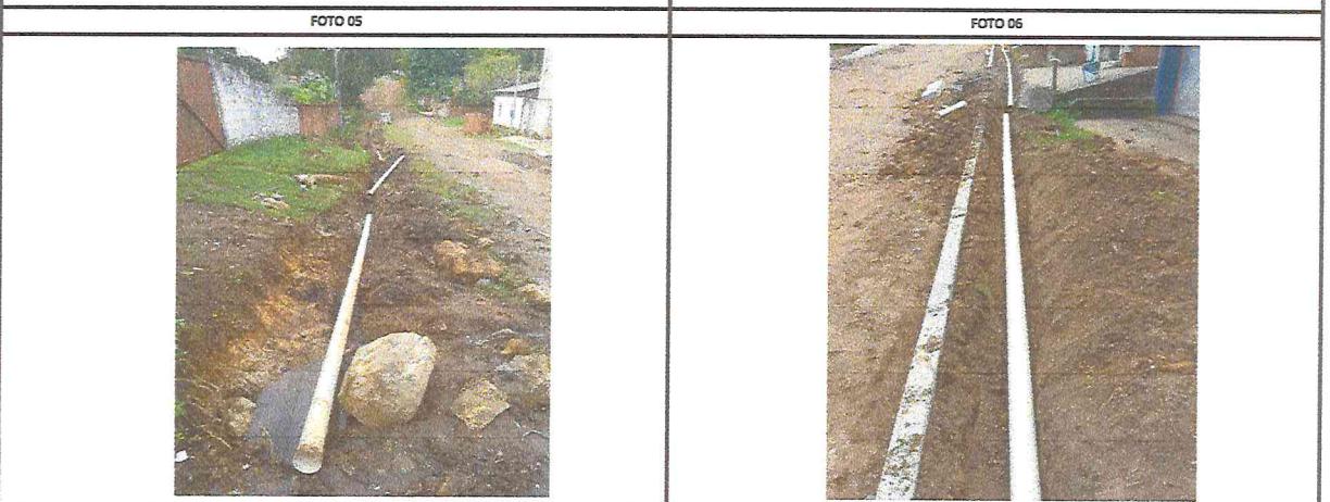
REBAIXAMENTO DE PENA D'ÁGUA
