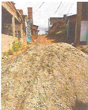
REGULARIZAÇÃO DE SOLO
