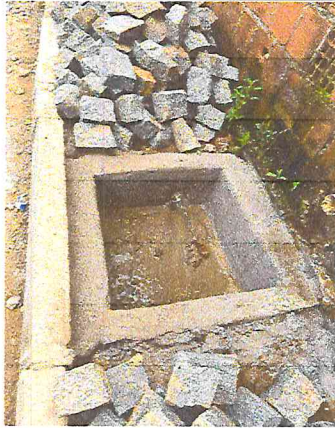
EXECUÇÃO DE CAIXA ENTERRADA HIDRÁULICA 0,60X0,60X0,60
