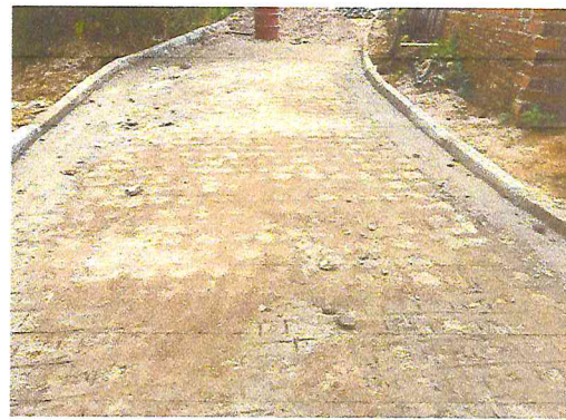
EXECUÇÃO DE PAVIMENTO EM PARALELEPÍPEDO
