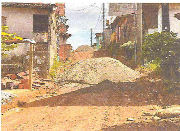
REGULARIZAÇÃO DE SOLO
