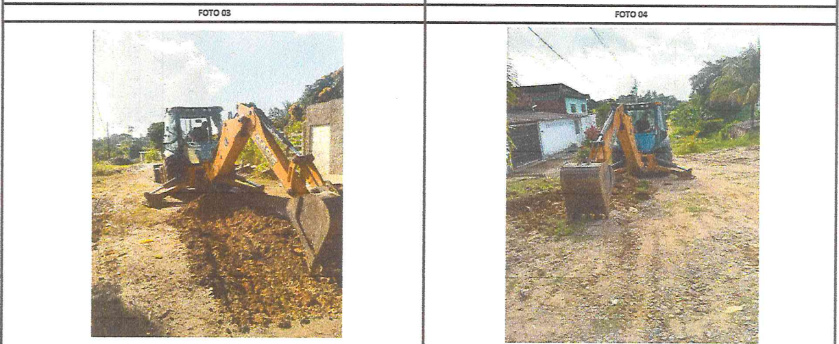
REGULARIZAÇÃO DE SOLO
