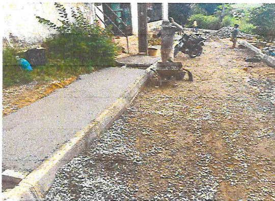
EXECUÇÃO DE PASSEIO
