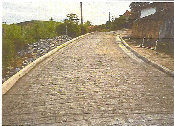
EXECUÇÃO DE PAVIMENTO EM PARALELEPÍPEDO
