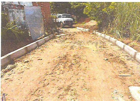
REGULARIZAÇÃO E COMPACTAÇÃO DE SUBLITO DE SOLO
