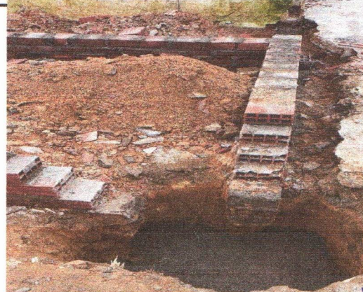
ESCAVAÇÃO ALVENARIA NA ESPESURA DE 20 CM (ASTRO DE CONCRETO)
