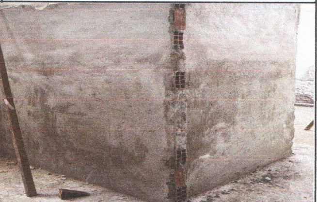
EMBOÇO, PARA RECEBIMENTO DE CERÂMICA
