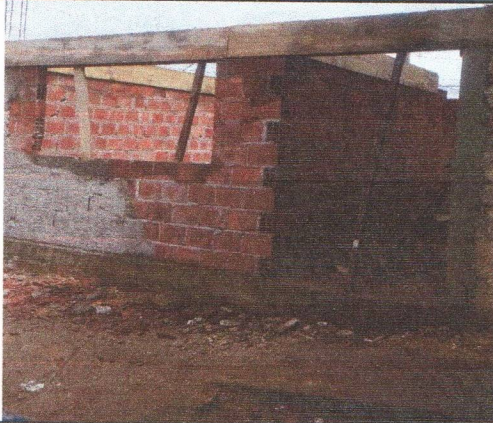
EXECUÇÃO DAS VIGAS, ALVENARIAS BALDRAME
