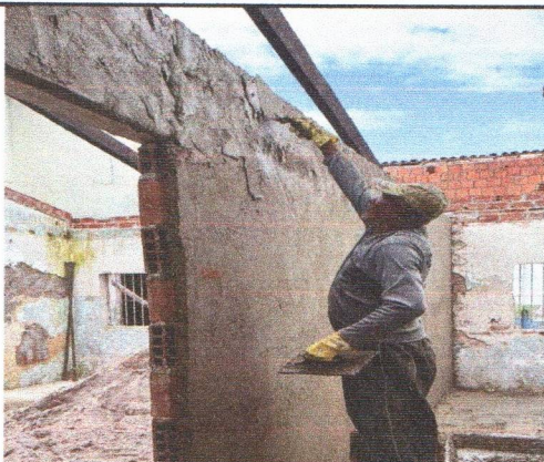
VERGA DE CONCRETO PARA VÃOS DE PORTA
