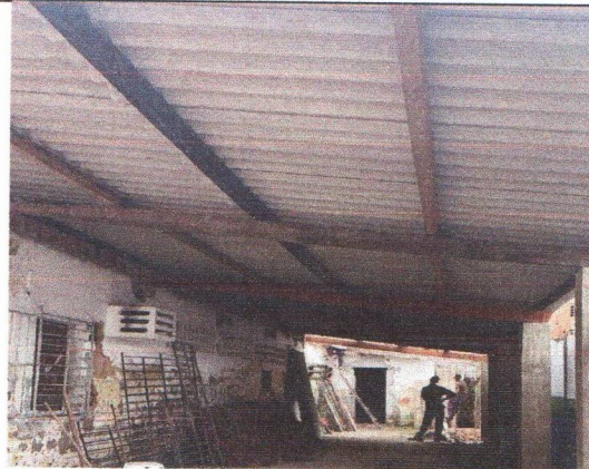
ESTRUTURA DE MADEIRA, TEHAMENTO COM TELHA EM FIBROCIMENTO, PILARES DE CONCRETO
