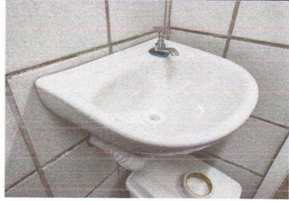
ESCOLA MUNICIPAL PADRE JOÃO COLLIGNON - LAVATÓRIO, TORNEIRA, VÁLVULA, SIFÃO E ENGATE - WC DOS FUNCIONÁRIOS
