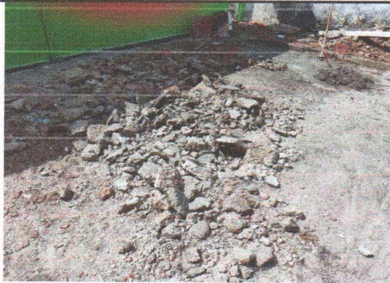
ESCOLA MUNICIPAL CLETO CAMPELO (SEDE) - DEMOLIÇÃO DE CONCRETO
