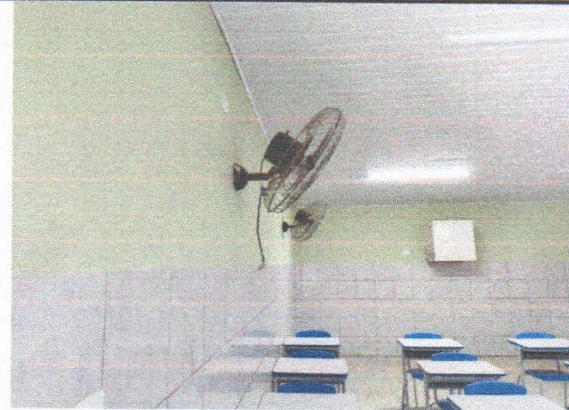
ESCOLA MUNICIPAL ERCINA LAPENDA - SUBSTITUIÇÃO DE LUMINÁRIAS
