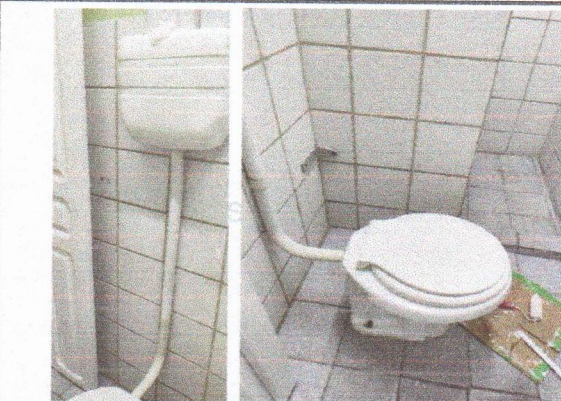
ESCOLA MUNICIPAL PADRE JOÃO COLLIGNON - TROCA DE ENGATE, ASSENTOS SANITÁRIOS E DESCARGAS
