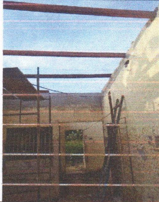
ESCOLA MUNICIPAL FRANCISCO GOMES DE ARAÚJO - INSTALAÇÃO DE ESTRUTURA DE MADEIRAMENTO PARA COBERTA
