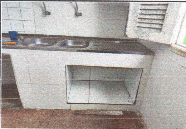
ESCOLA MUNICIPAL PADRE JOÃO COLLIGNON - ASSENTAMENTO DE REVESTIMENTO CERÂMICO - COZINHA
