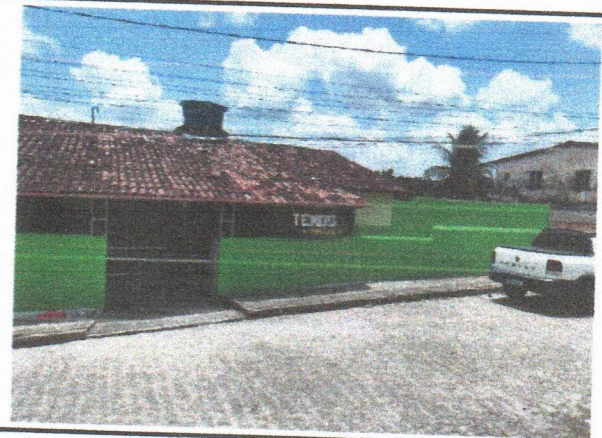
ESCOLA MUNICIPAL ALFREDO DIAS - APLICAÇÃO DE PINTURA NAS PAREDES
