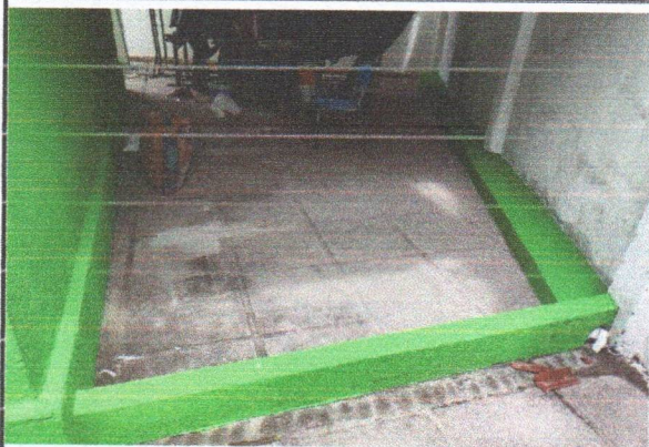
- ESCOLA MUNICIPAL PADRE JOÃO COLLIGNON - ELEVação DE ALVENARIA PARA CONTENÇÃO DE ÁGUA PLUVIAL, TUBULAÇÃO DN 100MM PARA ÁGUA PLUVIAL NA ÁREA POSTERIOR DA ESCOLA
