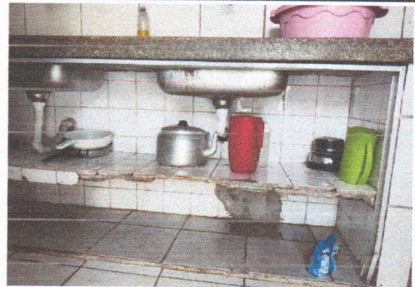
ESCOLA MUNICIPAL ERCINA LAPENDA - SUBSTITUIÇÃO DE SIFÕES
