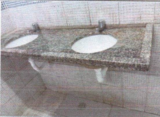
ESCOLA MUNICIPAL CLETO CAMPELO (SEDE) - INSTALAÇÃO DE CUBAS DE EMBUTIR E INSTALAÇÃO DE SIFÃOS E ENGATES
