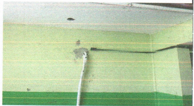
ESCOLA MUNICIPAL APOLÔNIO SALES - INSTALAÇÃO DE PONTOS DE AR CONDICIONADO
