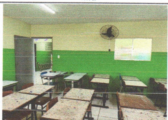
ESCOLA MUNICIPAL CLETO CAMPELO (SEDE) - PINTURA ESMALTE DE ESQUADRIA DE MADEIRA
