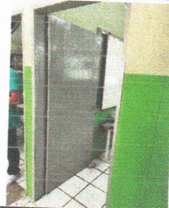
ESCOLA MUNICIPAL ALFREDO DIAS - APLICAÇÃO DE PINTURA ESMALTE EM ESQUADRIAS DE MADEIRA
