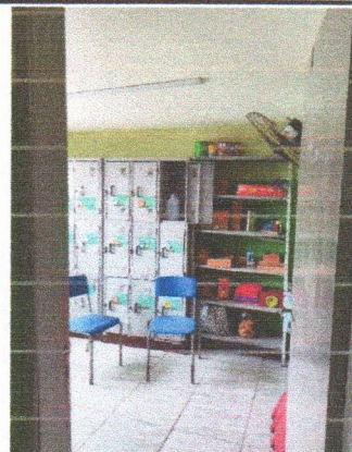
ESCOLA MUNICIPAL PROFESSOR ALFREDO DIAS DE OLIVEIRA (ANEXO) - PINTURA EM PAREDES E ESQUADRIAS DE MADEIRA
