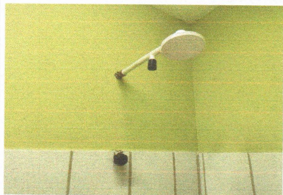
ESCOLA MUNICIPAL PADRE JOÃO COLLIGNON - TROCA DE CHUVEIRO
