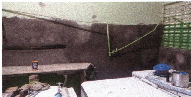
ESCOLA MUNICIPAL APOLÔNIO SALES - CHAPISCO E REBOCO NA COZINHA
