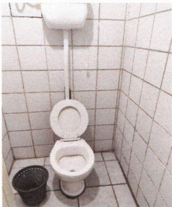
ESCOLA MUNICIPAL PADRE JOÃO COLLIGNON - INSTALAÇÃO DE DESCARGA SUSPensa DE SOBREPOR
