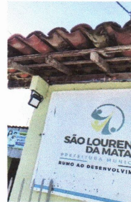
ESCOLA MUNICIPAL PADRE JOÃO BARBALHO - INSTALAÇÃO DE REFLETOR
