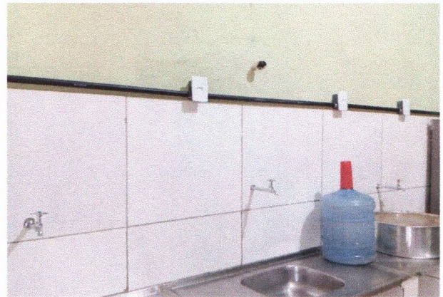
ESCOLA MUNICIPAL APOLÔNIO SALES - PAREDE COM REVESTIMENTO CERÂMICO E INSTALAÇÃO DE TORNEIRA DE PAREDE (COZINHA)
