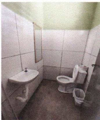
ESCOLA MUNICIPAL SENADOR FRANCISCO GOMES DE ARAÚJO - VASO SANITÁRIO, ASSENTO, LAVATÓRIO, CHUVEIRO, REGISTRO, RALO E PINTURA NAS PAREDES
