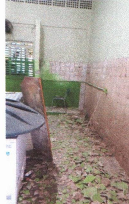
ESCOLA MUNICIPAL APOLÔNIO SALES - DEMOLIÇÃO DE REVESTIMENTO CERÂMICO
