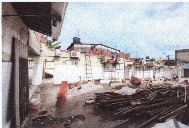
ESCOLA MUNICIPAL CLODOALDO GOMES DE ARAÚJO - REMOÇÃO (PORTA, TELHA, TRAMA, LUMINÁRIA, INTERRUPTOR, TOMADA) E ELEVAÇÃO DE ALVENARIA
