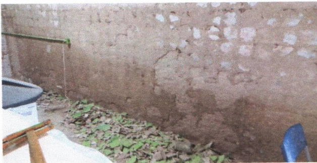
ESCOLA MUNICIPAL APOLÔNIO SALES - DEMOLIÇÃO DE REVESTIMENTO CERÂMICO
