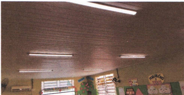
ESCOLA MUNICIPAL PAULO GOMES DE ARAÚJO - INSTALAÇÃO DE LUMINÁRIAS
