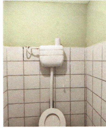
ESCOLA MUNICIPAL PADRE JOÃO COLLIGNON - INSTALAÇÃO DE DESCARGA SUSPensa DE SOBREPOR
