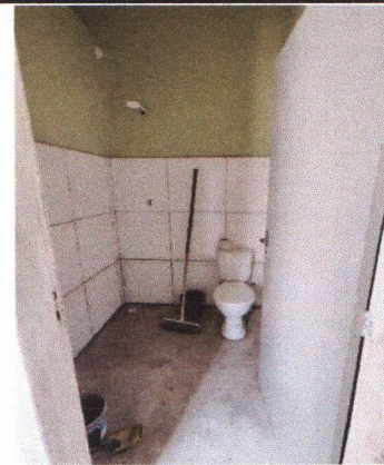
ESCOLA MUNICIPAL FRANCISCO TAVARES - PONTO DE ÁGUA E ESGOTO, INSTALAÇÃO DE LOUÇAS SANITÁRIAS, CHUVEIRO, REGISTRO, RALO (BLOCO WC'S)
