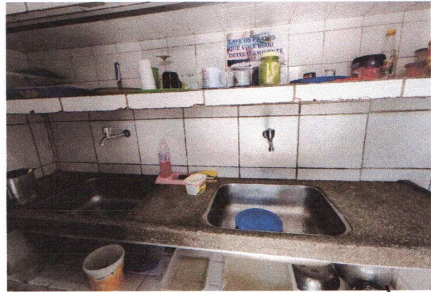
ESCOLA MUNICIPAL ERCINA LAPENDA - INSTALAÇÃO DE TORNEIRA EM PAREDE
