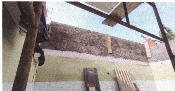
ESCOLA MUNICIPAL CLODOALDO GOMES DE ARAÚJO - ALVENARIA E CHAPISCO
