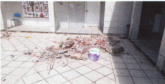
ESCOLA MUNICIPAL ERCINA LAPENDA - DEMOLIÇÃO DE ALVENARIA NO PÁTIO
