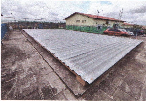
ESCOLA MUNICIPAL TIRADENTES - TELHAMENTO COM TELHA METÁLICA
