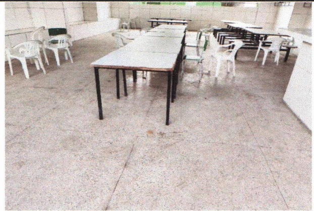
ESCOLA MUNICIPAL APOLÔNIO SALES - POLIMENTO E RESINA NO PISO
