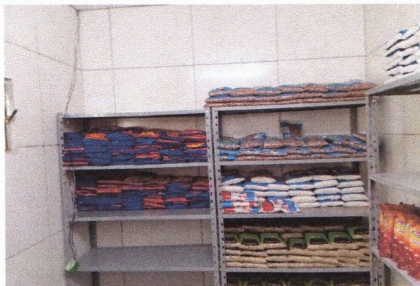
ESCOLA MUNICIPAL APOLÔNIO SALES - PAREDE COM REVESTIMENTO CERÂMICO (DESPENSA DE CEREAIS)
