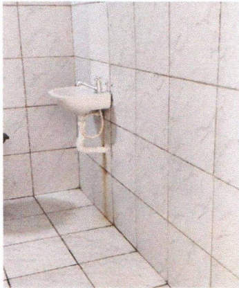
ESCOLA MUNICIPAL ERCINA LAPENDA - INSTALAÇÃO DE LAVATÓRIO COM TORNEIRA, SIFÃO, VÁLVULA E ENGATE
