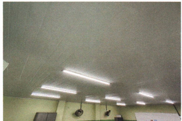
ESCOLA MUNICIPAL PADRE JOÃO BARBALHO - INSTALAÇÃO DO FORRO PVC, INSTALAÇÃO DE PONTOS ELÉTRICOS (ILUMINAÇÃO/LUMINÁRIAS E TOMADA)
