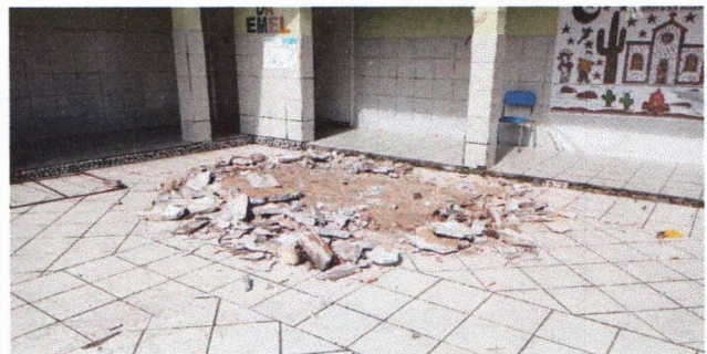
ESCOLA MUNICIPAL ERCINA LAPENDA - DEMOLIÇÃO DE ALVENARIA NO PÁTIO
