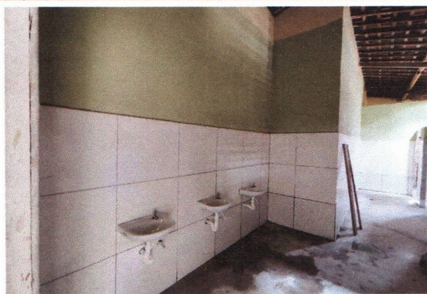
ESCOLA MUNICIPAL FRANCISCO TAVARES - REVESTIMENTO CERÂMICO NAS PAREDES, PONTO DE ÁGUA E ESGOTO, LAVATÓRIOS, TORNEIRAS E RALO (BLOCO WC'S)
