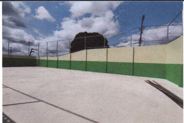
ESCOLA MUNICIPAL INÁCIO GOMES DA SILVA - APLICAÇÃO DE PINTURA ACRÍLICA NAS PAREDES
