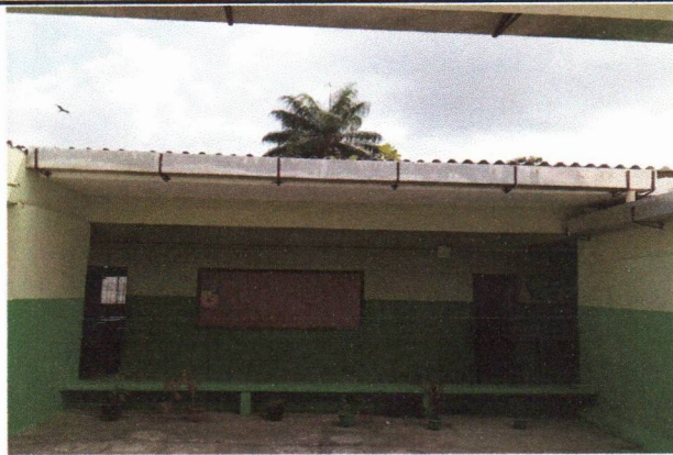
ESCOLA MUNICIPAL INÁCIO GOMES DA SILVA - APLICAÇÃO DE PINTURA ACRÍLICA NAS PAREDES E INSTALAÇÃO DE CALHA
