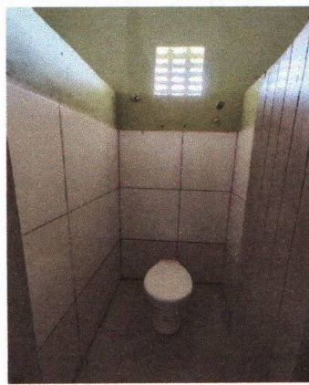
ESCOLA MUNICIPAL FRANCISCO TAVARES - REVESTIMENTO CERÂMICO NAS PAREDES, PONTO DE ÁGUA E ESGOTO, VASO SANITÁRIO E REGISTRO (BLOCO WC'S)
