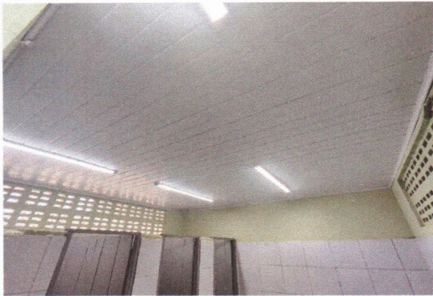
ESCOLA MUNICIPAL PADRE JOÃO BARBALHO - INSTALAÇÃO DO FORRO PVC, INSTALAÇÃO DE PONTOS ELÉTRICOS (ILUMINAÇÃO/LUMINÁRIA)
