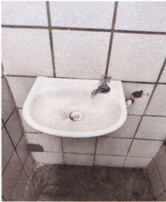
ESCOLA MUNICIPAL PADRE JOÃO COLLIGNON - REASSENTAMENTO DO LAVATÓRIO E COLOCAÇÃO DE ACESSÓRIOS NOVOS (TORNEIRA, VÁLVULA, SIFÃO, ENGATE)
