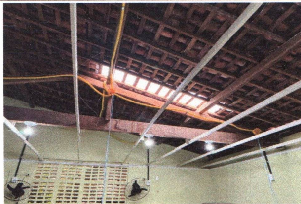
ESCOLA MUNICIPAL PADRE JOÃO BARBALHO - INSTALAÇÃO DO FORRO PVC, INSTALAÇÃO DE PONTOS ELÉTRICOS (ILUMINAÇÃO E TOMADA)
