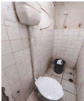
ESCOLA MUNICIPAL ERCINA LAPENDA - INSTALAÇÃO DE DESCARGA SUSPensa DE SOBREPOR
