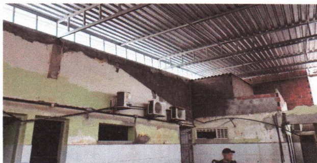
ESCOLA MUNICIPAL CLODOALDO GOMES DE ARAÚJO - TELHAMENTO COM TELHA METÁLICA NO PÁTIO
