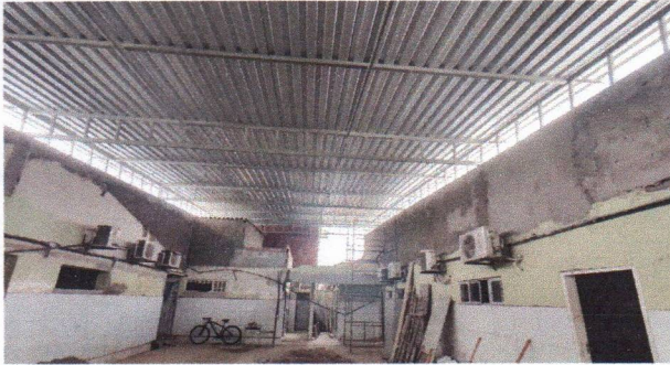
ESCOLA MUNICIPAL CLODOALDO GOMES DE ARAÚJO - TELHAMENTO COM TELHA METÁLICA NO PÁTIO
