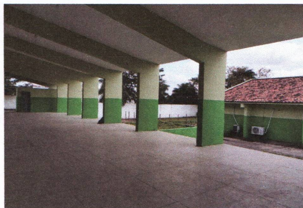
ESCOLA MUNICIPAL APOLÔNIO SALES - APLICAÇÃO DE PINTURA ACRÍLICA NAS PAREDES E TETO
