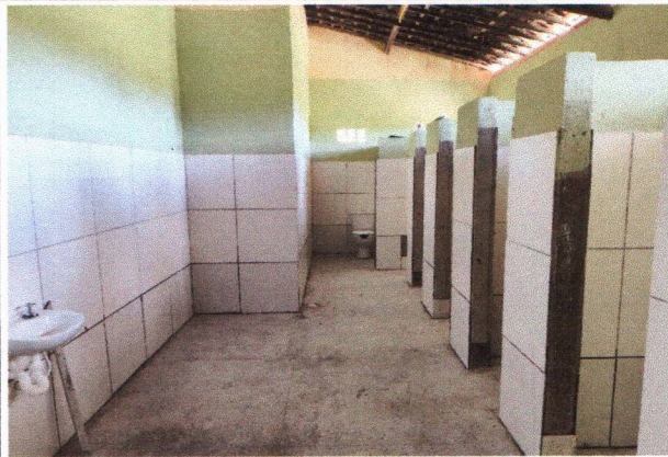
ESCOLA MUNICIPAL FRANCISCO TAVARES - REVESTIMENTO CERÂMICO NAS PAREDES, PONTO DE ÁGUA E ESGOTO (BLOCO WC'S)
