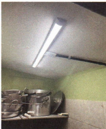
ESCOLA MUNICIPAL PADRE JOÃO BARBALHO - INSTALAÇÃO DO FORRO PVC, INSTALAÇÃO DE PONTOS ELÉTRICOS (ILUMINAÇÃO/LUMINÁRIA)
