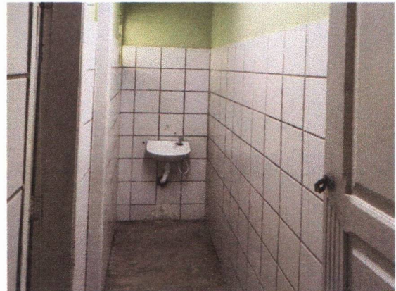
ESCOLA MUNICIPAL PADRE JOÃO COLLIGNON - REASSENTAMENTO DO LAVATÓRIO E COLOCAÇÃO DE ACESSÓRIOS NOVOS (TORNEIRA, VÁLVULA, SIFÃO, ENGATE)
