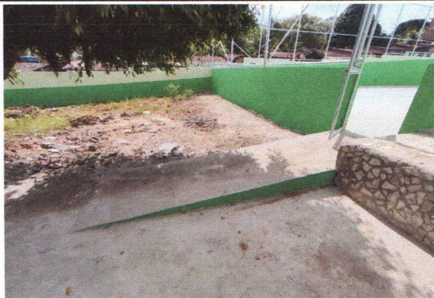
ESCOLA MUNICIPAL ERCINA LAPENDA - APLICAÇÃO DE PINTURA NAS PAREDES
