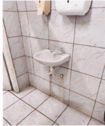
ESCOLA MUNICIPAL ERCINA LAPENDA - INSTALAÇÃO DE LAVATÓRIO COM TORNEIRA, SIFÃO, VÁLVULA E ENGATE
