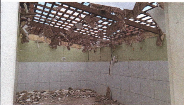
ESCOLA MUNICIPAL CLODOALDO GOMES DE ARAÚJO - DEMOLIÇÃO DE FORRO
