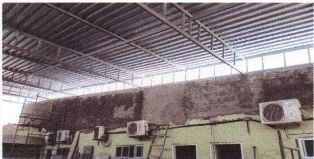
ESCOLA MUNICIPAL CLODOALDO GOMES DE ARAÚJO - TELHAMENTO COM TELHA METÁLICA NO PÁTIO
