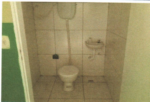
ESCOLA MUNICIPAL INÁCIO GOMES DA SILVA - INSTALAÇÃO DE VASO SANITÁRIO, LAVATÓRIO COM SEUS ACESSÓRIOS E RALO
