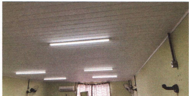
ESCOLA MUNICIPAL PAULO GOMES DE ARAÚJO - INSTALAÇÃO DE LUMINÁRIAS
