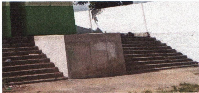
ESCOLA MUNICIPAL APOLÔNIO SALES - REBOCO
