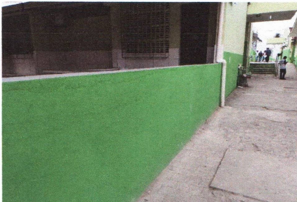
ESCOLA MUNICIPAL APOLÔNIO SALES - APLICAÇÃO DE PINTURA ACRÍLICA NAS PAREDES
