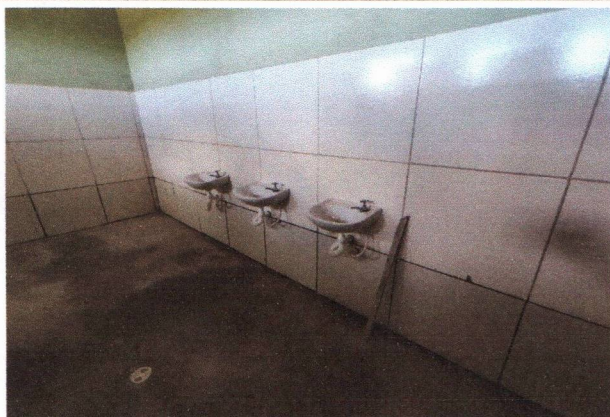
ESCOLA MUNICIPAL FRANCISCO TAVARES - REVESTIMENTO CERÂMICO NAS PAREDES, PONTO DE ÁGUA E ESGOTO, LAVATÓRIOS, TORNEIRAS E RALO (BLOCO WC'S)
