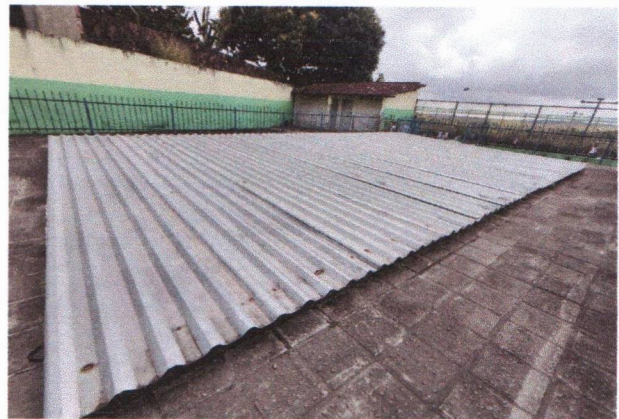
ESCOLA MUNICIPAL TIRADENTES - TELHAMENTO COM TELHA METÁLICA
