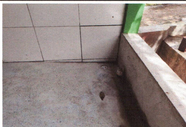
ESCOLA MUNICIPAL FRANCISCO TAVARES - REVESTIMENTO CERÂMICO NAS PAREDES, PONTO DE ESGOTO E RALO (BLOCO WC'S)
