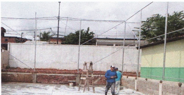
ESCOLA MUNICIPAL ERCINA LAPENDA - APLICAÇÃO DE SELADOR
