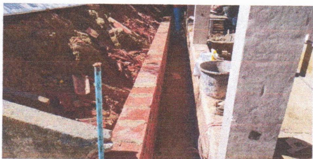
ESCOLA MUNICIPAL FRANCISCO TAVARES (ALVENARIA DA CANALETA ENTRE O BLOCO A E O BLOCO B)
