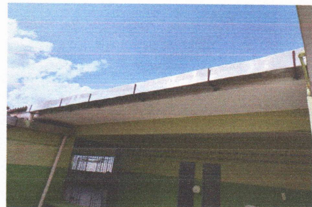
ESCOLA MUNICIPAL INÁCIO GOMES DA SILVA (CALHA NA ÁREA INTERNA)
