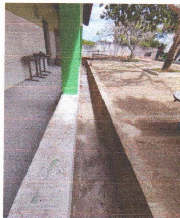
ESCOLA MUNICIPAL FRANCISCO TAVARES (ALVENARIA DA CANALETA ENTRE O BLOCO A E O BLOCO B)
