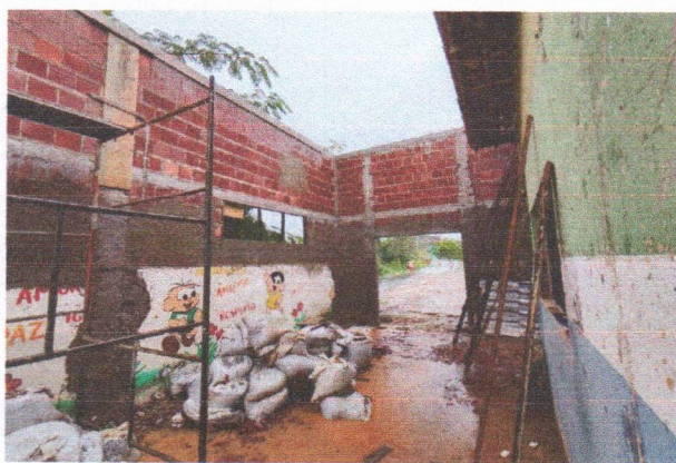
ESCOLA MUNICIPAL FRANCISCO TAVARES (ALVENARIA, PILARES E CINTA NA ENTRADA DA ESCOLA)
