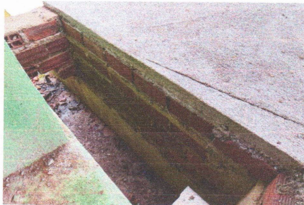
ESCOLA MUNICIPAL FRANCISCO TAVARES (ALVENARIA DA CAIXA DE DRENAGEM)
