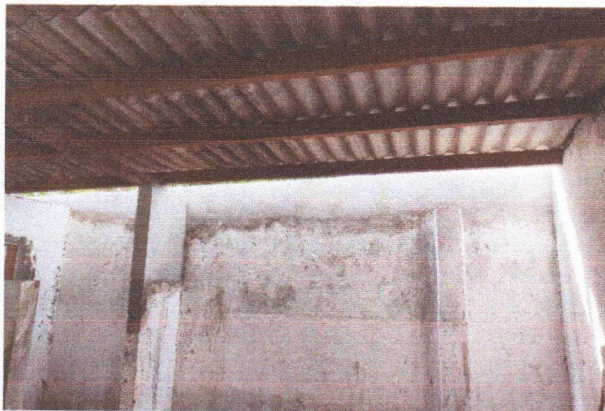
ESCOLA MUNICIPAL INÁCIO GOMES DA SILVA (TELHAMENTO COM TELHA ONDULADA DE FIBROCIMENTO)
