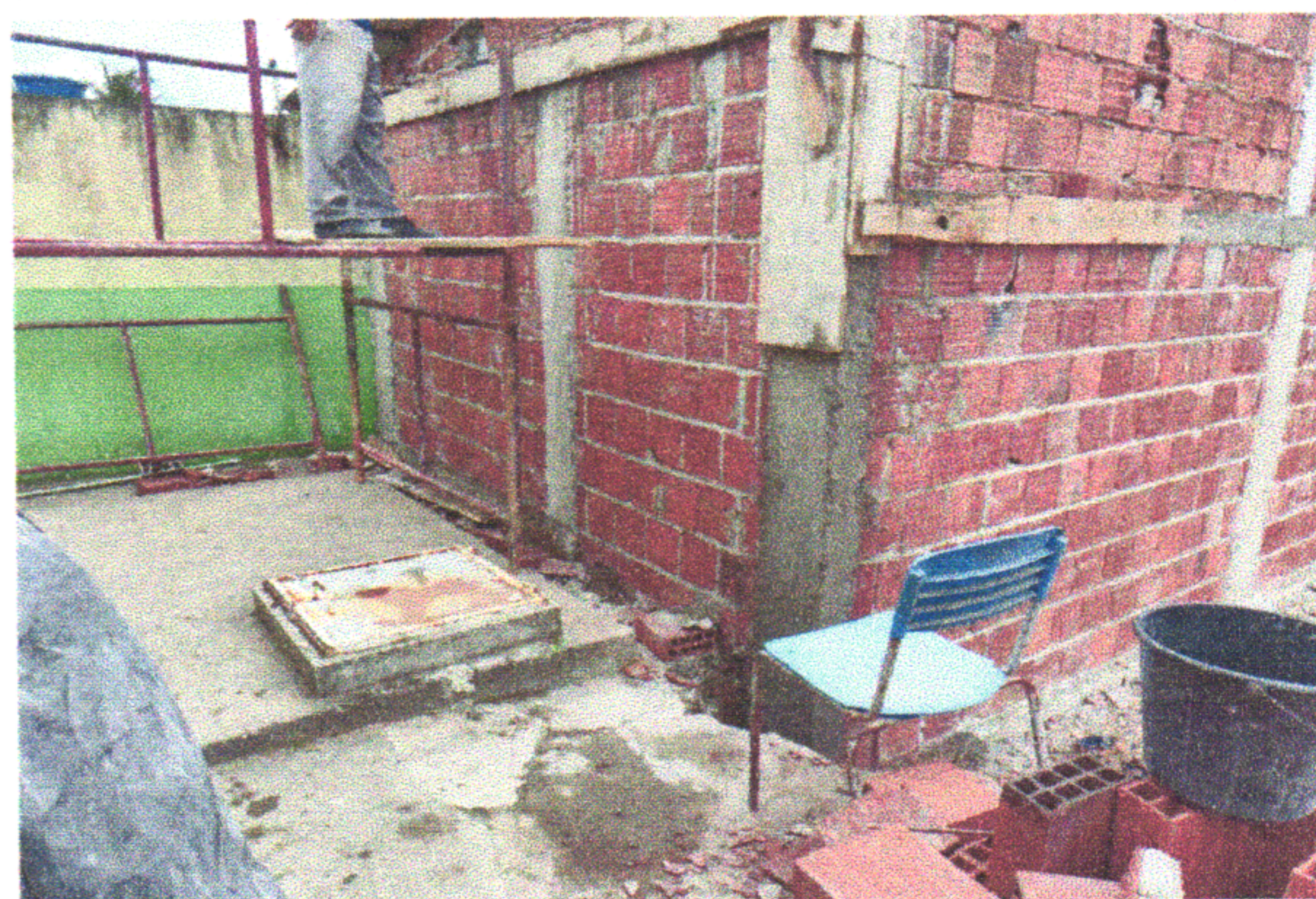
ESCOLA MUNICIPAL DR. FERNANDO SAMPAIO - UTILIZAÇÃO DE ANDAIME PARA CONCRETAGEM DOS PILARES E CINTAS
