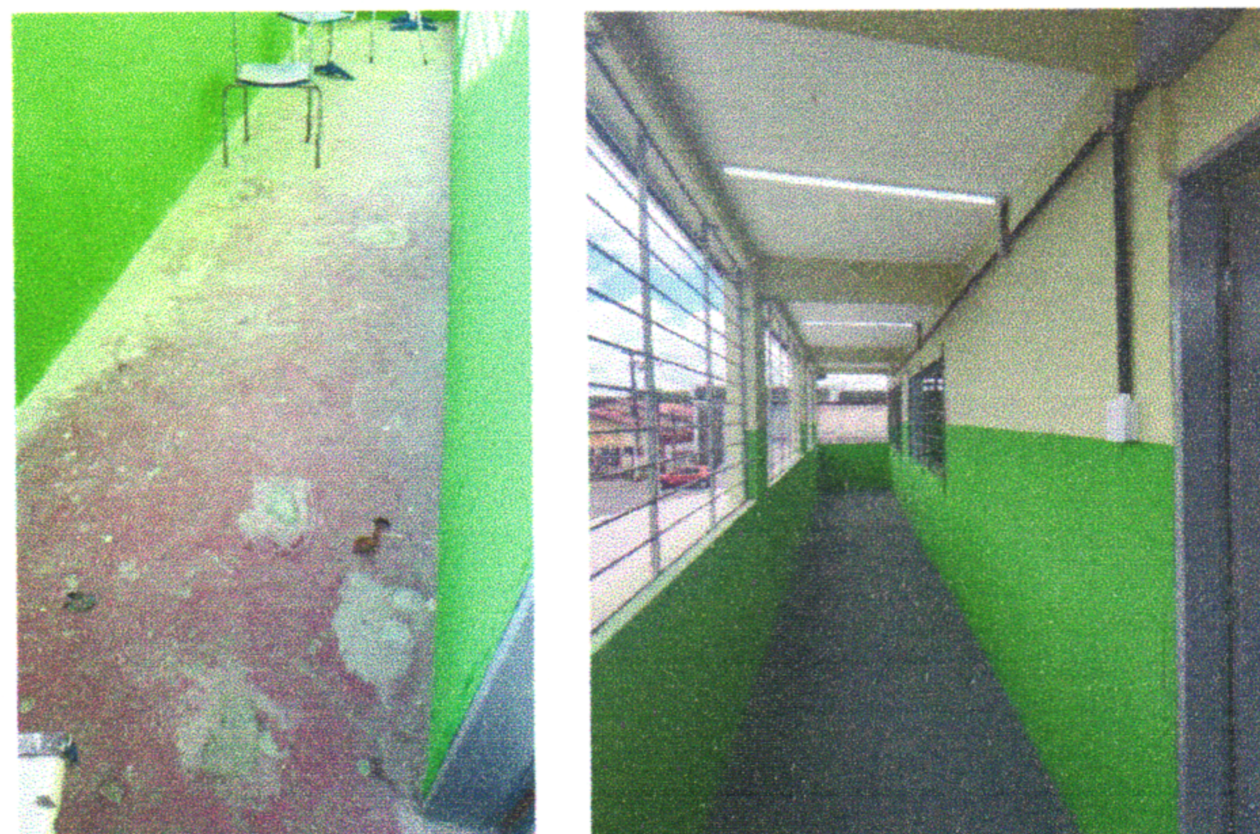
ESCOLA MUNICIPAL CLETO CAMPELO (ANEXO 2) - APLICAÇÃO DE PINTURA DE PISO
