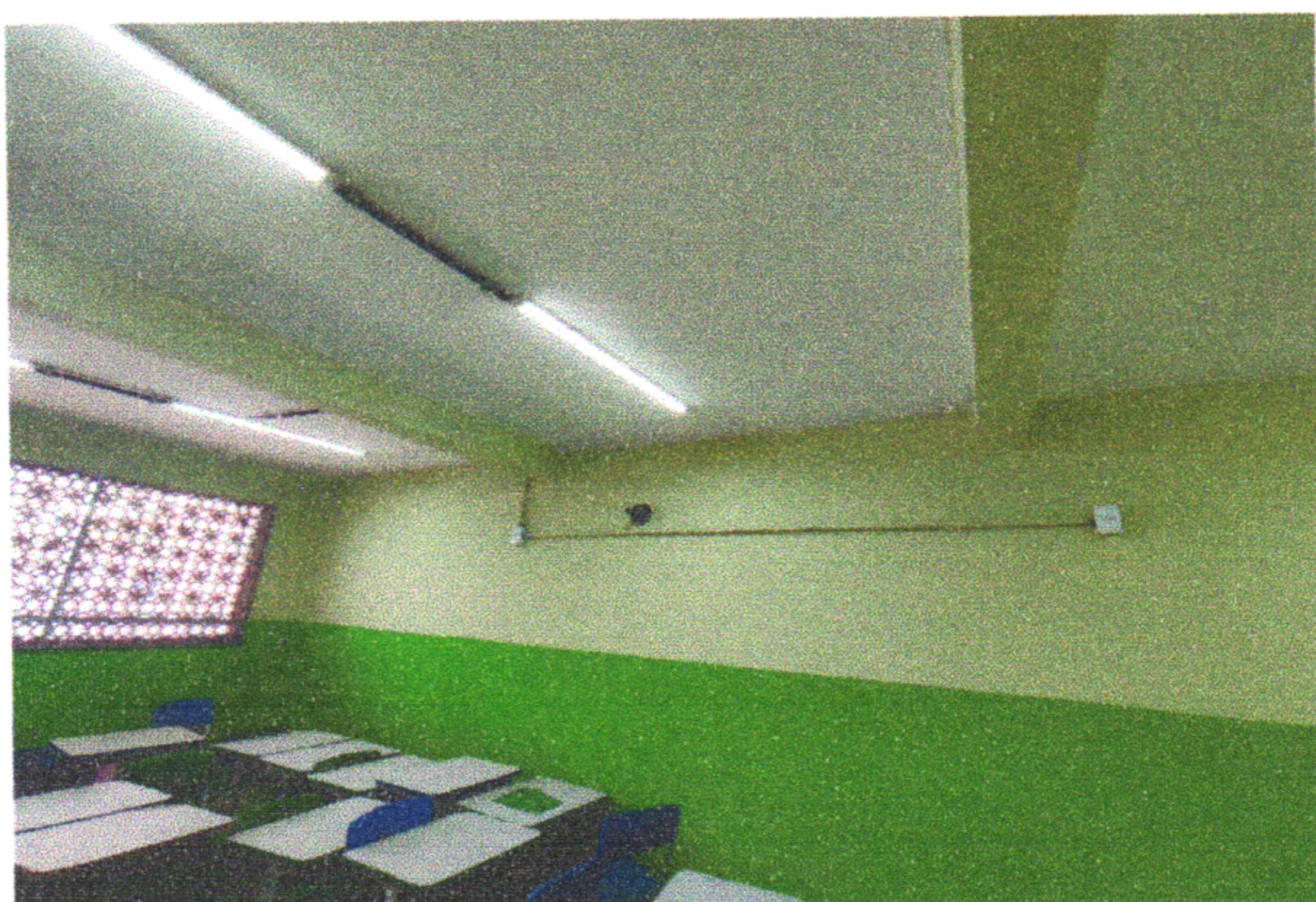
ESCOLA MUNICIPAL CLETO CAMPELO (ANEXO 2) - PINTURA ACÍLICA NAS PAREDES
