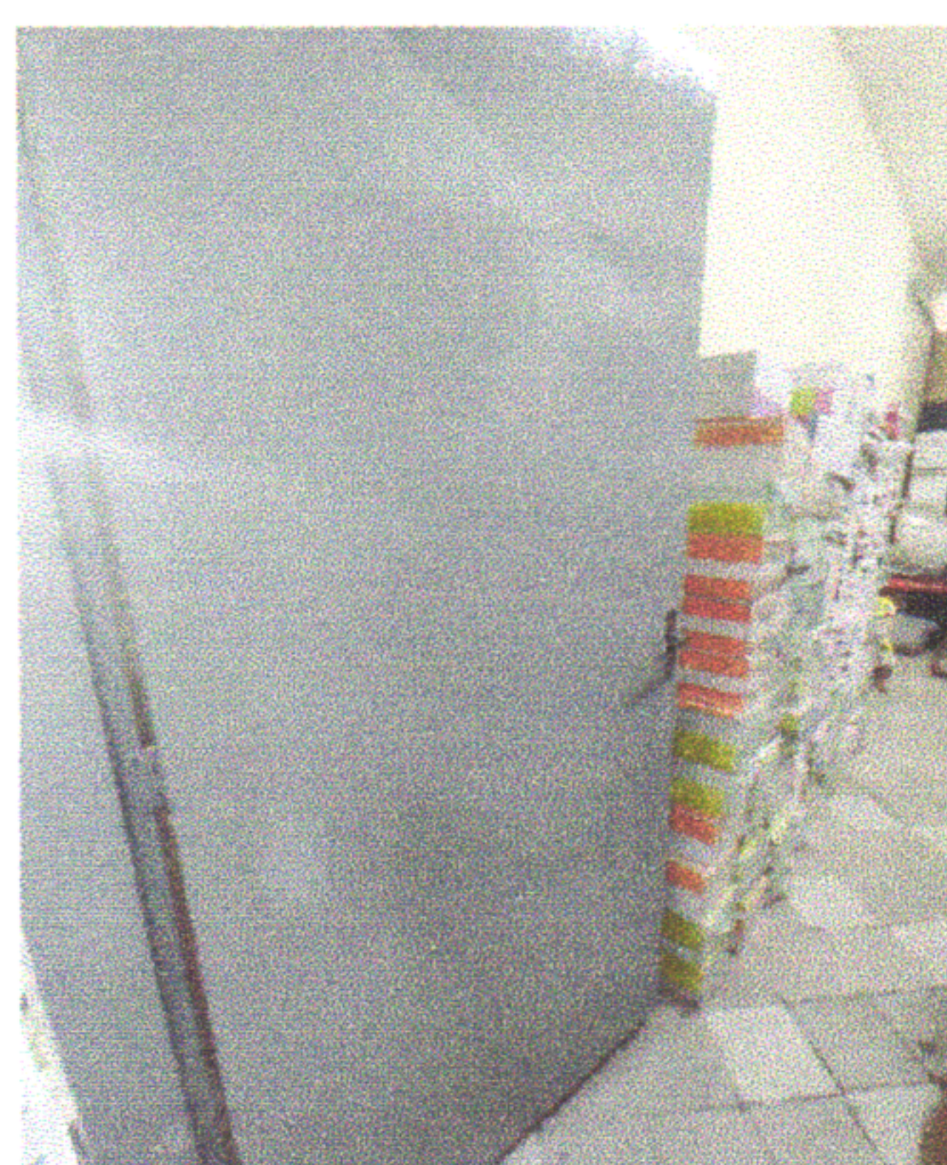
ESCOLA MUNICIPAL CLETO CAMPELO (ANEXO 2) - PORTAS DE MADEIRA COM FECHADURA, EMASSADO E PINTADO
