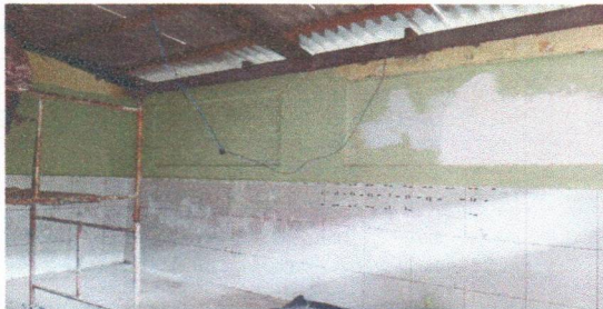
ESCOLA MUNICIPAL CLODOALDO GOMES DE ARAÚJO - APLICAÇÃO DE MASSA CORRIDA
