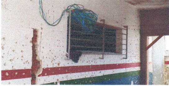
ESCOLA MUNICIPAL MARIA JOSÉ DE SOUZA - REMOÇÃO DE ESQUADRIA METÁLICA
