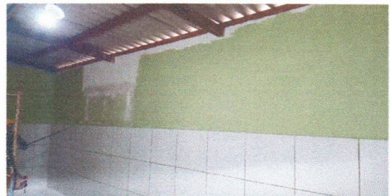
ESCOLA MUNICIPAL CLODOALDO GOMES DE ARAÚJO - APLICAÇÃO DE MASSA CORRIDA
