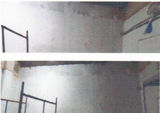
ESCOLA MUNICIPAL CLODOALDO GOMES DE ARAÚJO - APLICAÇÃO DE SELADOR
