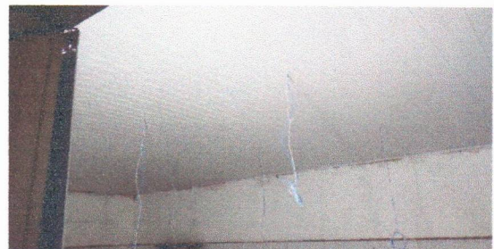
ESCOLA MUNICIPAL CLODOALDO GOMES DE ARAÚJO - APLICAÇÃO DE SELADOR
