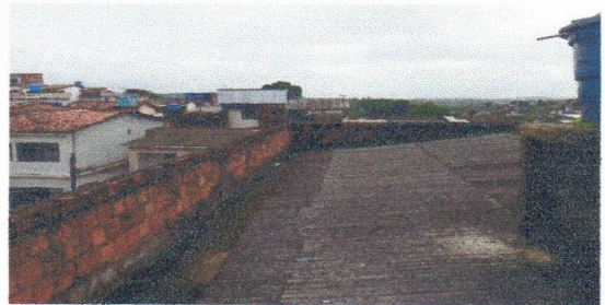
ESCOLA MUNICIPAL MARIA JOSÉ DE SOUZA - REMOÇÃO DE TELHAS
