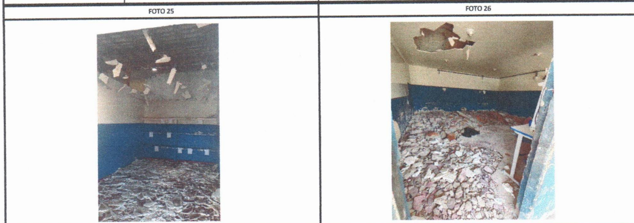
ESCOLA MUNICIPAL MARIA JOSÉ DE SOUZA - TRANSPORTE DO ENTULHO DAS DEMOLIÇÕES
