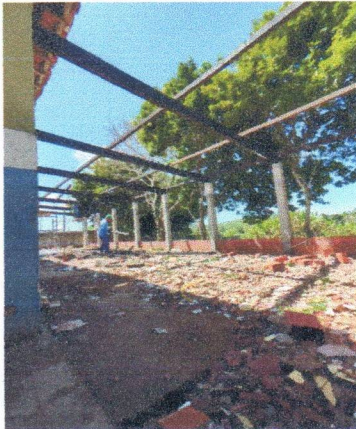
ESCOLA MUNICIPAL FRANCISCO TAVARES - ESTRUTURA DE MADEIRA
