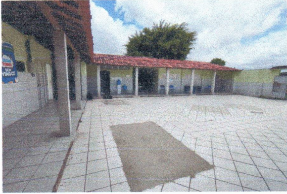
ESCOLA MUNICIPAL ERCINA LAPENDA - SAPATA E PILARES
