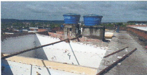
ESCOLA MUNICIPAL MARIA JOSÉ - ANTES DA DEMOLIÇÃO DE CONCRETO (LAJE)
