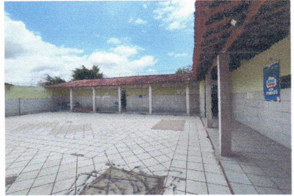
ESCOLA MUNICIPAL ERCINA LAPENDA - SAPATA E PILARES
