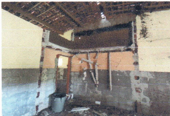
ESCOLA MUNICIPAL FRANCISCO TAVARES - DEMOLIÇÃO DE CONCRETO (LAJE)
