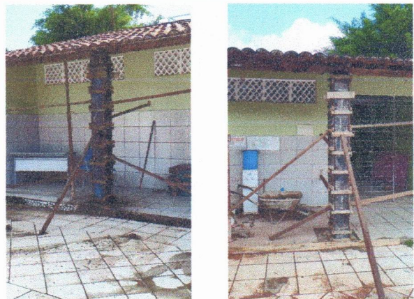
ESCOLA MUNICIPAL ERCINA LAPENDA - SAPATA E PILARES
