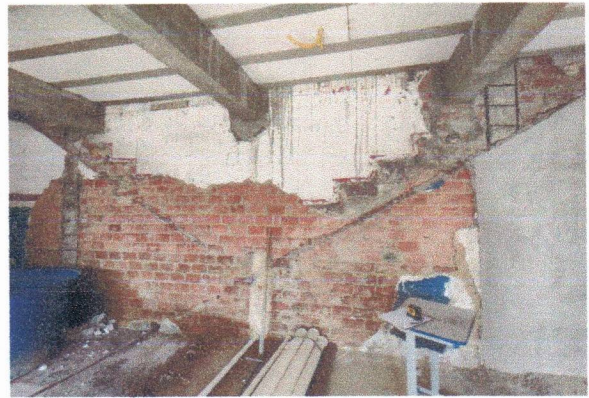
ESCOLA MUNICIPAL MARIA JOSÉ - DEMOLIÇÃO DE CONCRETO (ESCALA)
