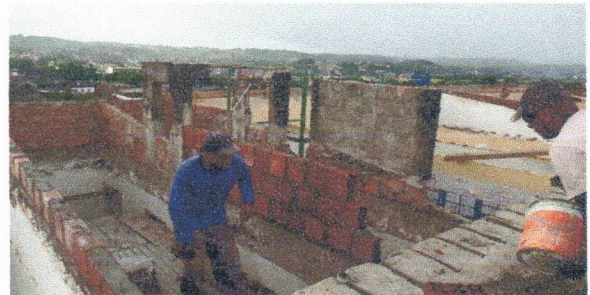
ESCOLA MUNICIPAL MARIA JOSÉ - DEMOLIÇÃO DE CONCRETO (LAJE)
