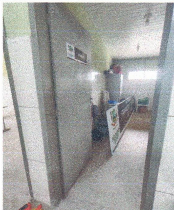
ESCOLA MUNICIPAL FRANCISCO TAVARES - PLACAS DE IDENTIFICAÇÃO DAS PORTAS E DA IDENTIFICAÇÃO COM O NOME DA ESCOLA (FACHADA)
