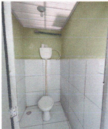
ESCOLA MUNICIPAL CLODOALDO GOMES DE ARAÚJO - DESCARGA SUSPENSA
