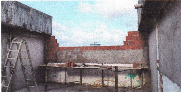
ESCOLA MUNICIPAL MARIA JOSÉ DE SOUZA - ASSENTAMENTO DE ALVENARIA DE BLOCO CERÂMICO
