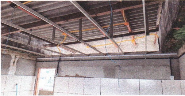
ESCOLA MUNICIPAL MARIA JOSÉ DE SOUZA - PONTO DE LUZ EM TETO COM ELETRODUTO DE PVC FLEXIVEL
