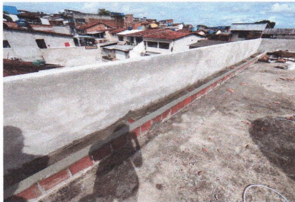
ESCOLA MUNICIPAL MARIA JOSÉ DE SOUZA - ASSENTAMENTO DE ALVENARIA DE BLOCO CERÂMICO
