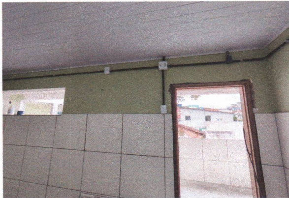
ESCOLA MUNICIPAL MARIA JOSÉ DE SOUZA - PONTO DE INTERRUPTOR (01 SEÇÃO) E PONTO DE TOMADA 10A (01 SEÇÃO) APARENTE COM ELETRODUTO DE PVC RÍGIDO
