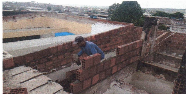
ESCOLA MUNICIPAL MARIA JOSÉ DE SOUZA - ASSENTAMENTO DE ALVENARIA DE BLOCO CERÂMICO
