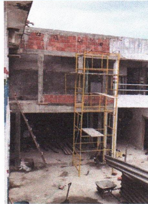
ESCOLA MUNICIPAL MARIA JOSÉ DE SOUZA - ASSENTAMENTO DE ALVENARIA DE BLOCO CERÂMICO
