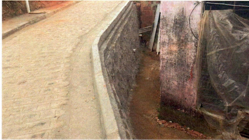
(17) Muro de Arrimo
