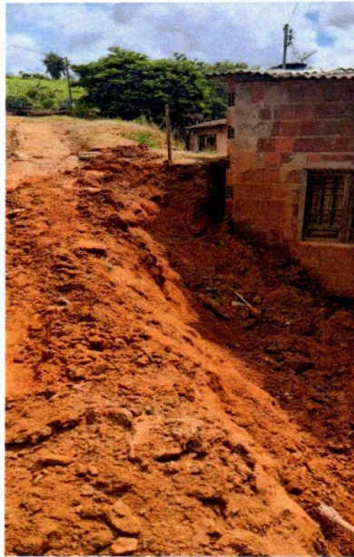
(01) Regularização de Talude
