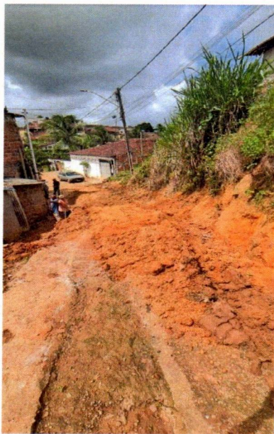
(04) Regularização da Rua Esperança
