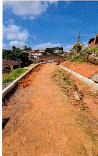
(10) Assentamento de Meio-fio
