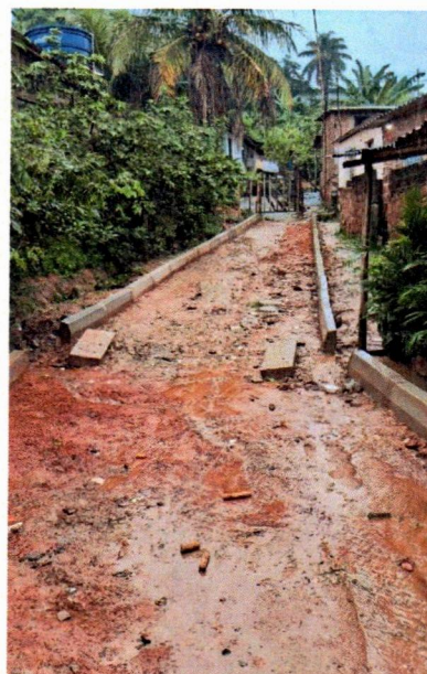
(03) Assentamento de meio-fio
