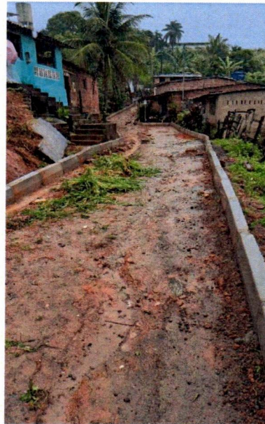
(06) Assentamento de meio-fio
