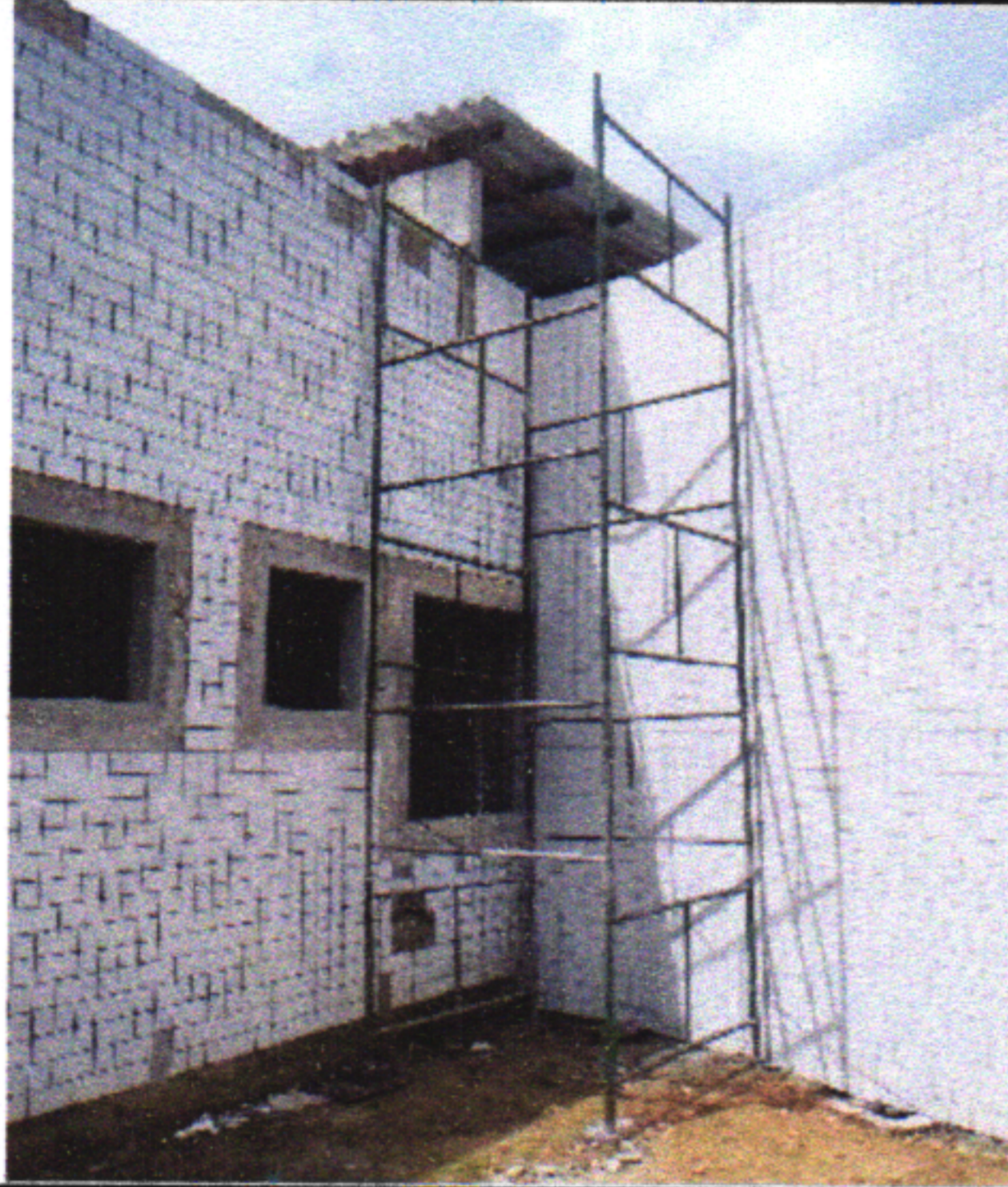
1.2 - LOCAÇÃO DE ANDAIME METÁLICO TIPO FACHADEIRO, INCLUSIVE MONTAGEM E DESMONTAGEM
