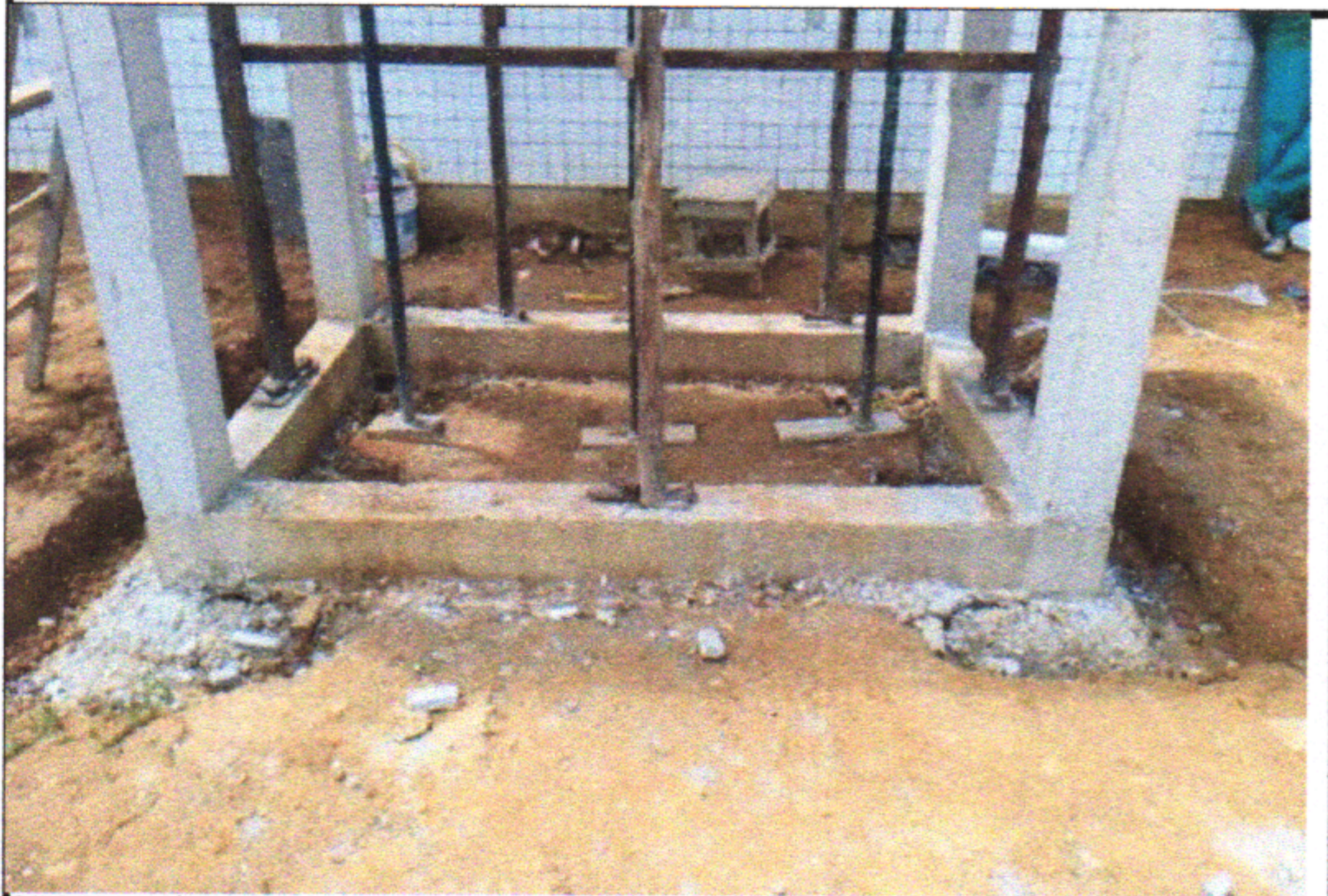
6.1 - CONCRETO MAGRO PARA LASTRO, TRAÇO 1:4,5:4,5 (EM MASSA SECA DE CIMENTO/ AREIA MÉDIA/ BRITA 1) - PREPARO MECÂNICO COM BETONEIRA 400 L. AF_05/2021 / 6.2 COMPOSIÇÃO PARAMÉTRICA PARA EXECUÇÃO DE ESTRUTURAS DE CONCRETO ARMADO, PARA EDIFICAÇÃO HABITACIONAL UNIFAMILIAR TÉRREA (CASA EM EMPREENDIMENTOS), FCK = 25 MPA. AF_11/2022
