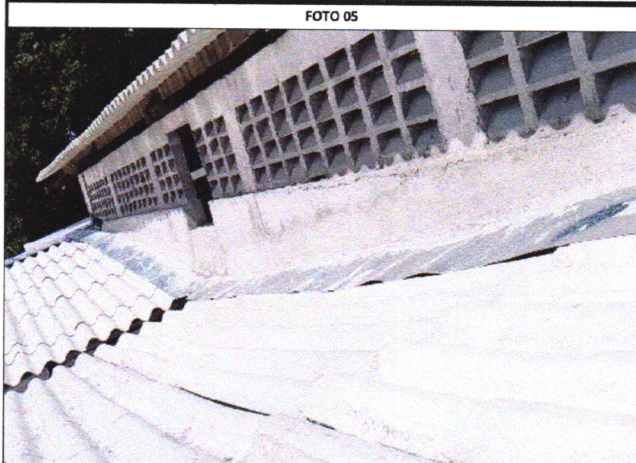
9.4 - RUFO EXTERNO/INTERNO EM CHAPA DE AÇO GALVANIZADO NÚMERO 26, CORTE DE 33 CM, INCLUSO IÇAMENTO. AF_07/2019
