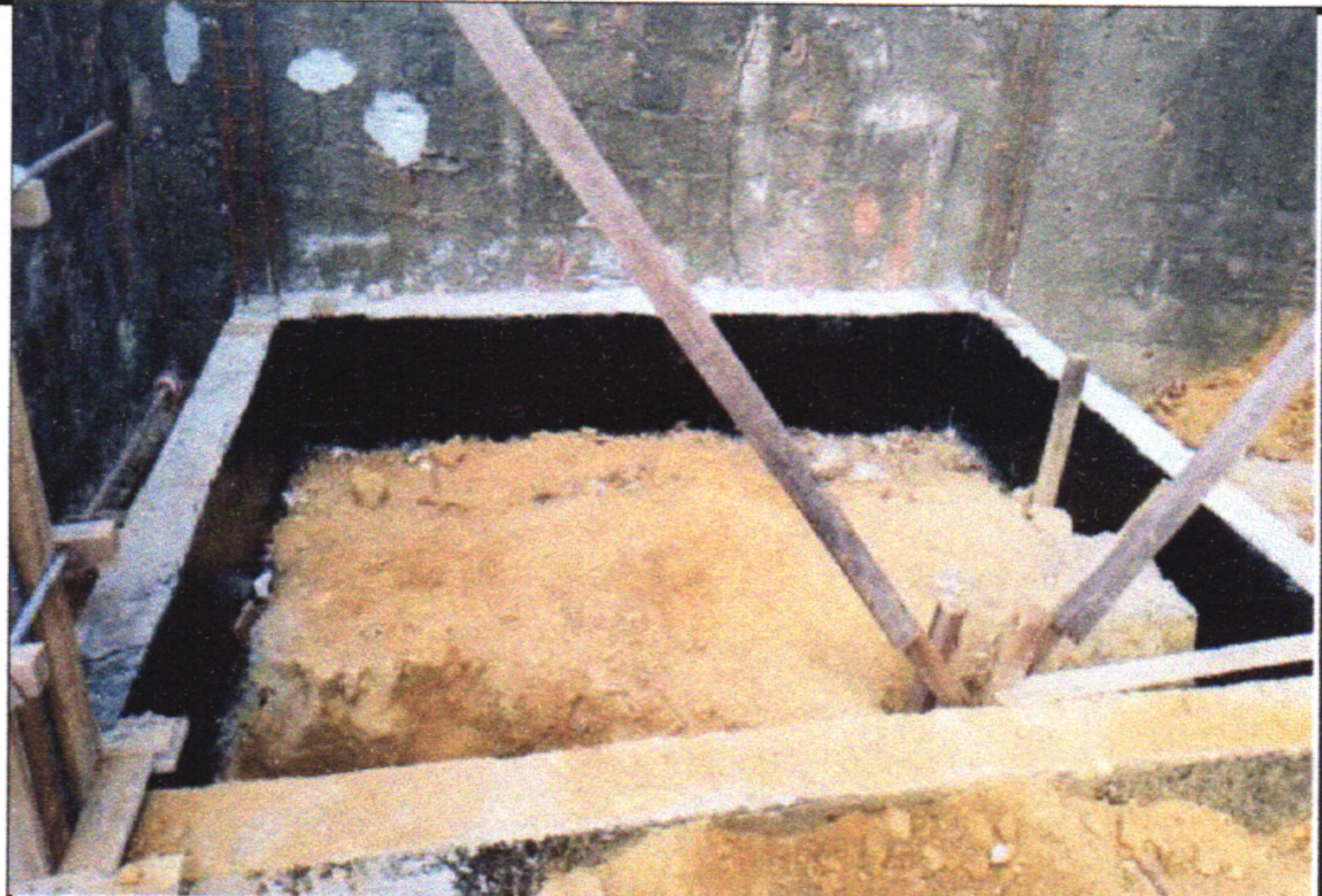
5.2 ESCAVAÇÃO MANUAL DE VALA PARA VIGA BALDRAME (INCLUINDO ESCAVAÇÃO PARA COLOCAÇÃO DE FÔRMAS). AF_06/2017
