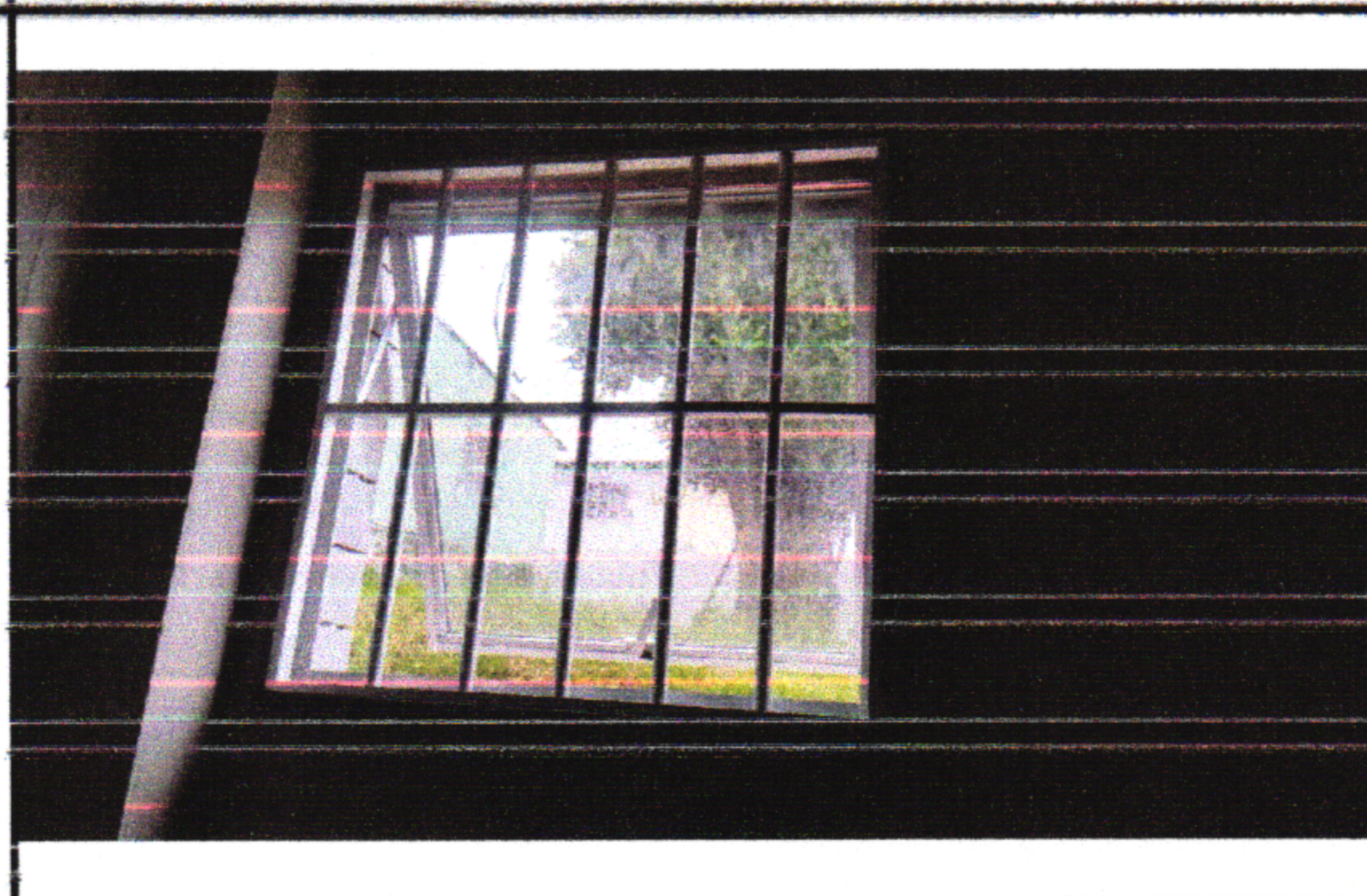
11.17 - GRADIL EM ALUMÍNIO FIXADO EM VÃOS DE JANELAS, FORMADO POR TUBOS DE 3/4". AF_04/2019
