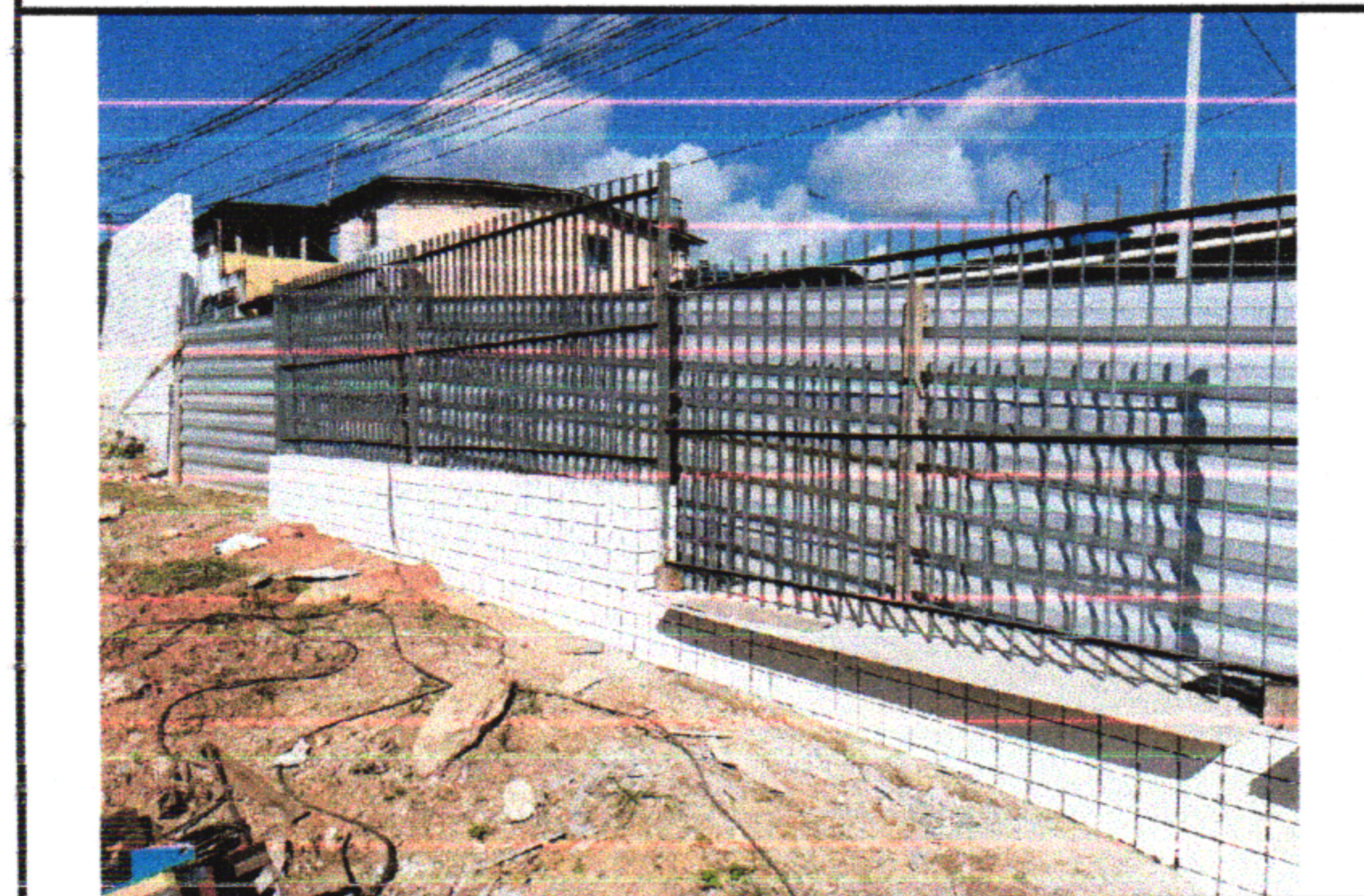
11.18 - GRADIL EM FERRO FIXADO EM VÃOS DE JANELAS, FORMADO POR BARRAS CHATAS DE 25X4,8 MM. AF_04/2019
