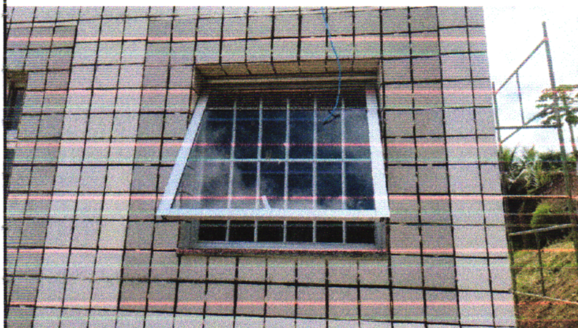
11.9 - JANELA DE ALUMÍNIO TIPO MAXIM-AR, COM VIDROS, BATENTE E FERRAGENS. EXCLUSIVE ALIZAR, ACABAMENTO E CONTRAMARCO. FORNECIMENTO E INSTALAÇÃO. AF_12/2019
