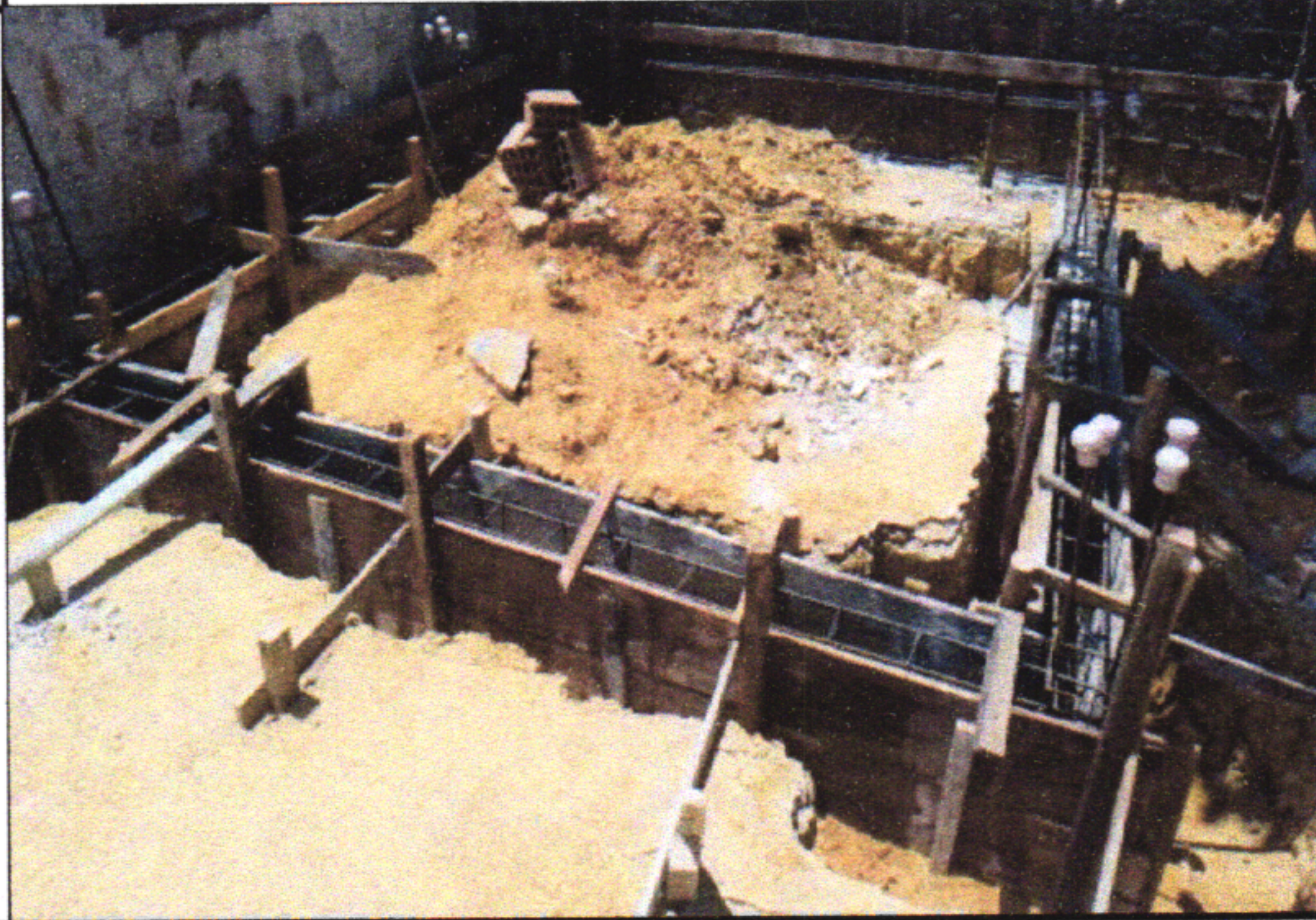
5.2 - ESCAVAÇÃO MANUAL DE VALA PARA VIGA BALDRAME (INCLUINDO ESCAVAÇÃO PARA COLOCAÇÃO DE FÔRMAS). AF_06/2017
