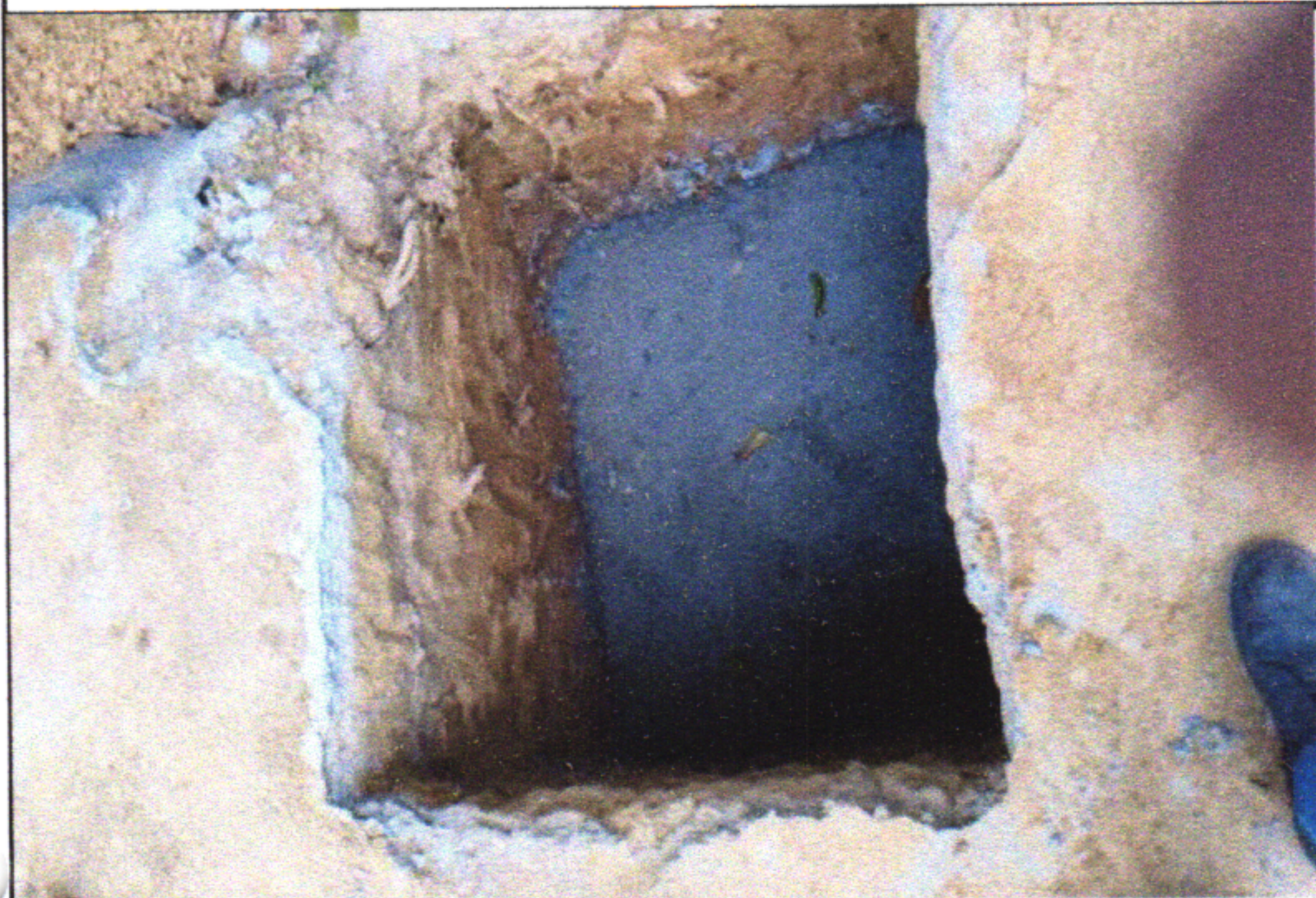
6.1 - CONCRETO MAGRO PARA LASTRO, TRAÇO 1:4,5:4,5 (EM MASSA SECA DE CIMENTO/ AREIA MÉDIA/ BRITA 1) - PREPARO MECÂNICO COM BETONEIRA 400 L. AF_05/2021
