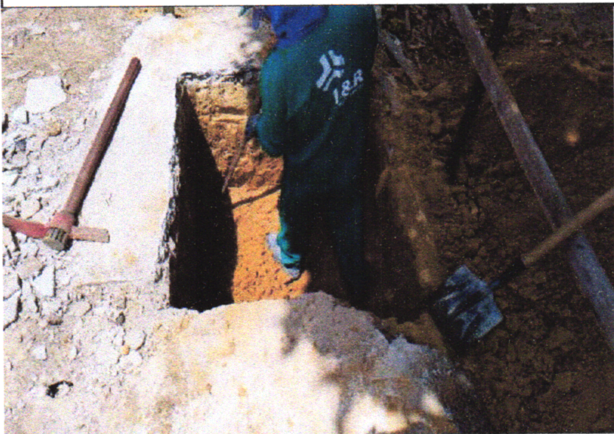
5.1 - ESCAVAÇÃO MANUAL PARA BLOCO DE COROAMENTO OU SAPATA (INCLUINDO ESCAVAÇÃO PARA COLOCAÇÃO DE FÔRMAS). AF_06/2017
